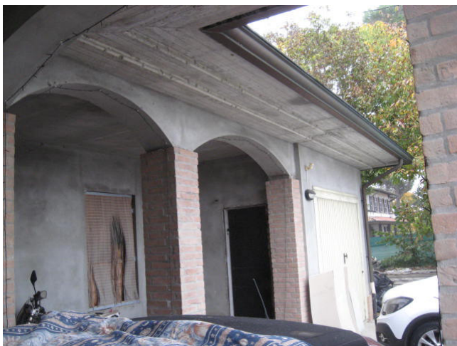
interna di accesso ai vani abitativi
