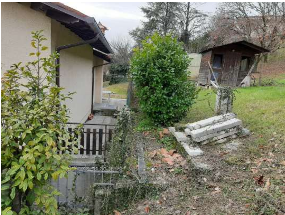
Fig. 18 – vista del fabbricato esistente a sud dei mappali 1252 - 1070
