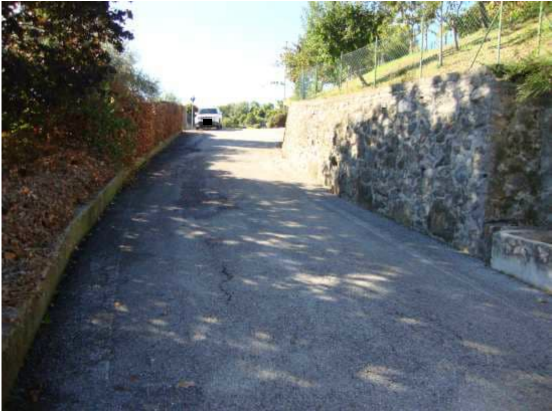
Fig. 10 – vista da est del lato nord dell’appezzamento confinante con via G. Verdi
