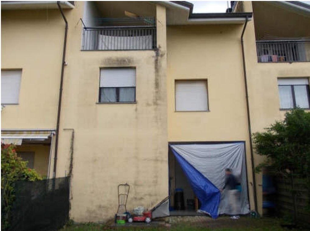
Foto 7 Prospetto su giardino mapp.1086 sub.1 Lotto 1
