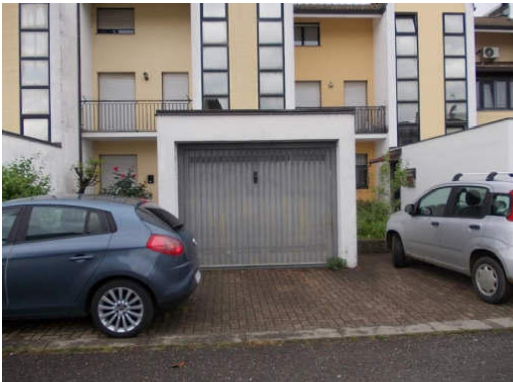
Foto 2 Particolare prospetto box mapp.1086 sub.2 su via Aldo Moro Lotto 1
