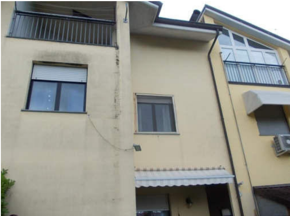
Foto 21 Prospetto su giardino mapp.1089 sub.1 Lotto 2
