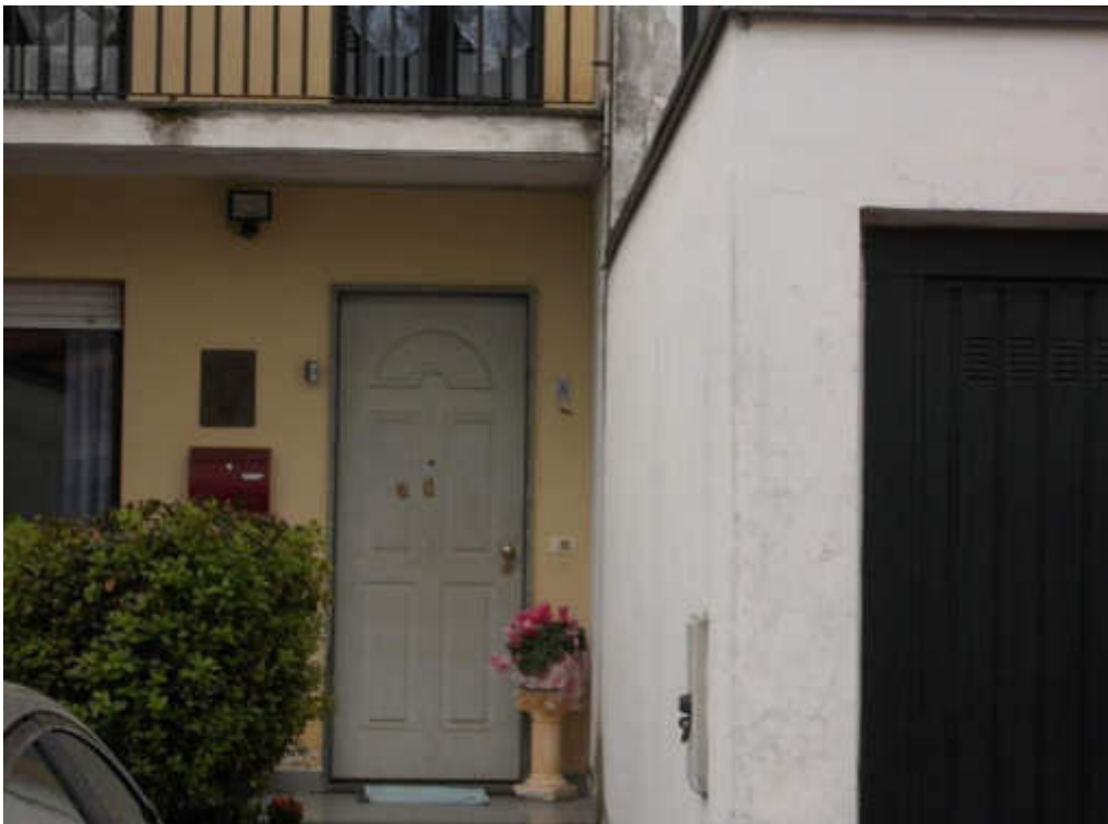
Foto 18 Particolare ingresso mapp.1089 sub.1 su via Aldo Moro Lotto 2
