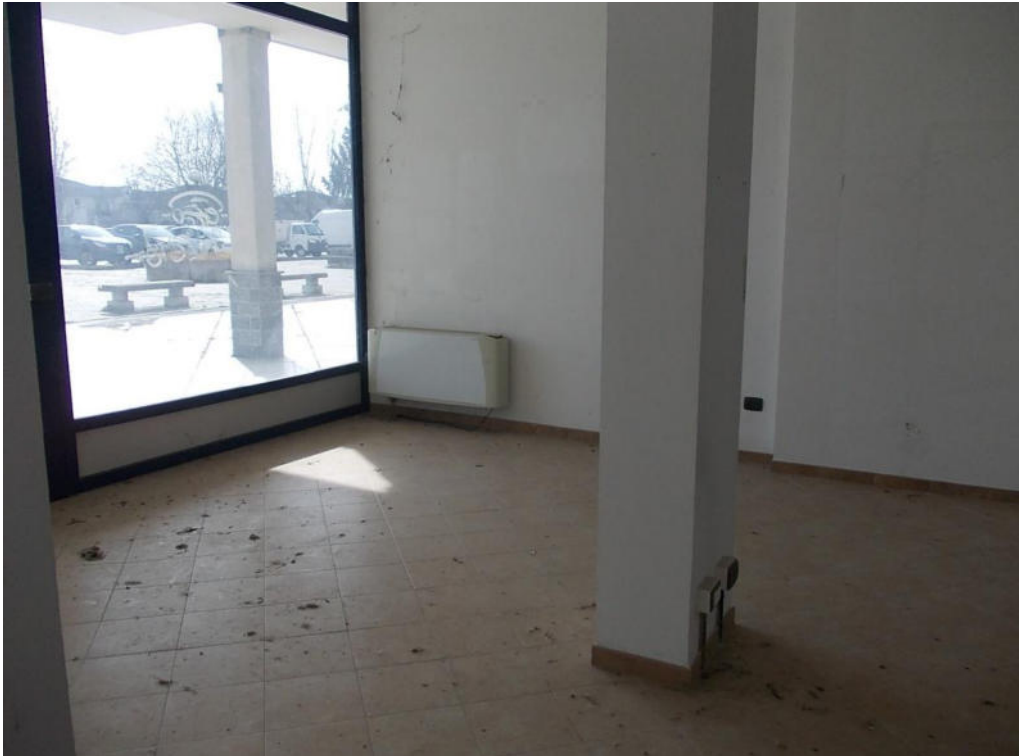
Foto 11 Particolare interno negozio lotto 2
