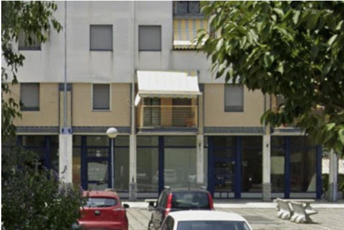
Foto 9 Prospetto negozio lotto 2
