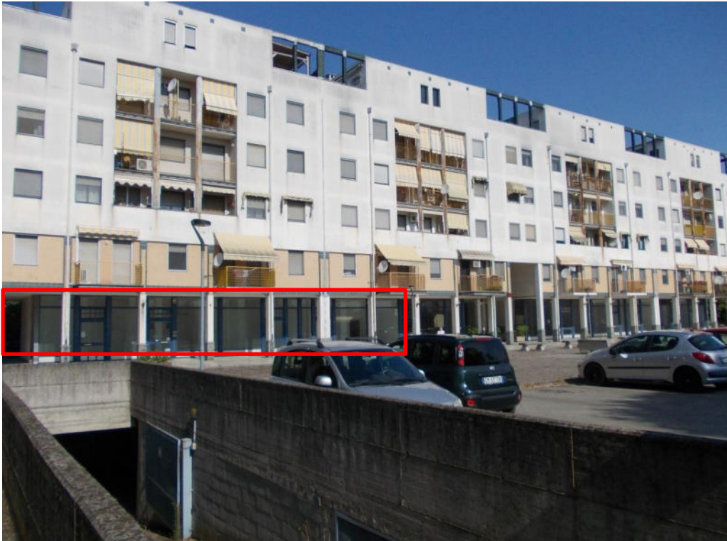
Foto 1 Piazza C.A. Dalla Chiesa vista su negozi lotto 1 e lotto 2
