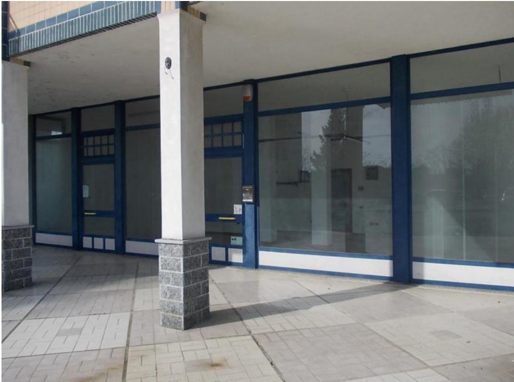
Foto 3 Prospetto negozio lotto 1
