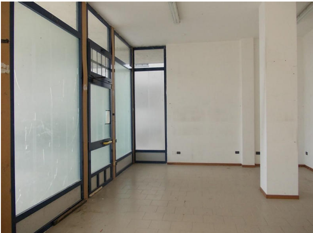
Foto 8 Particolare interno negozio lotto 1
