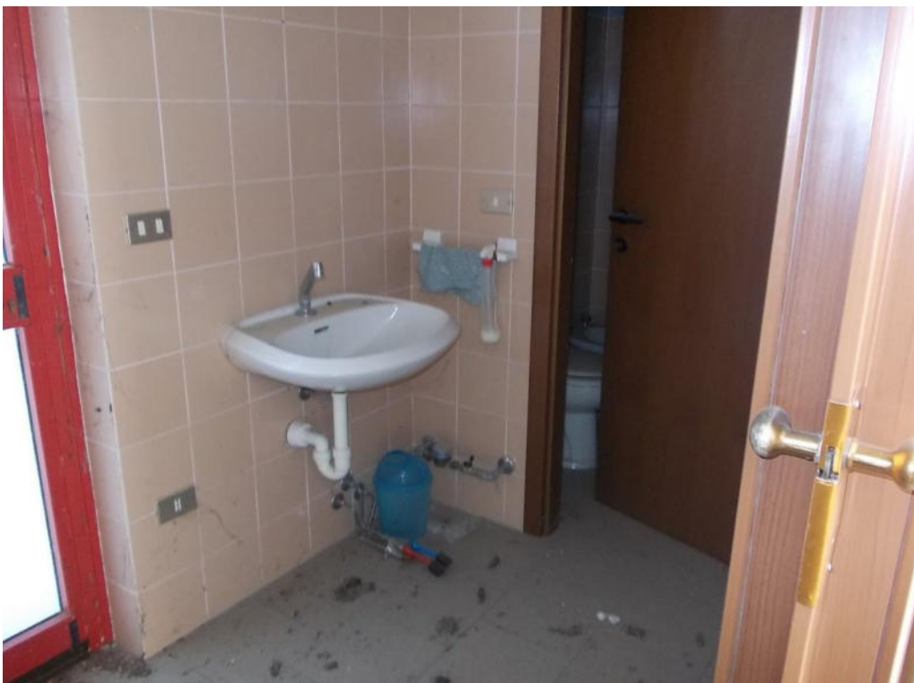
Foto 12 Particolare interno negozio lotto 2
