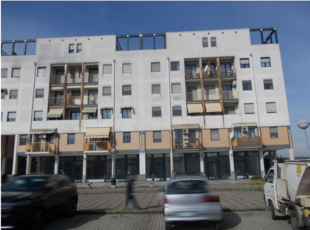
Foto 15 Prospetto negozio lotto 3
