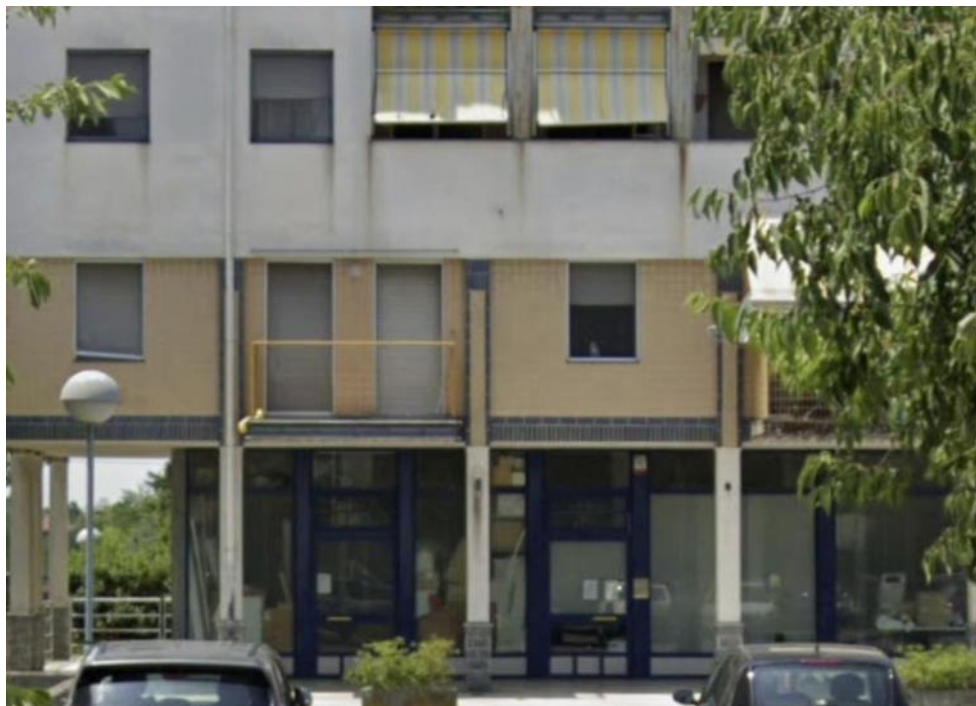
Foto 2 Prospetto negozio lotto 1
