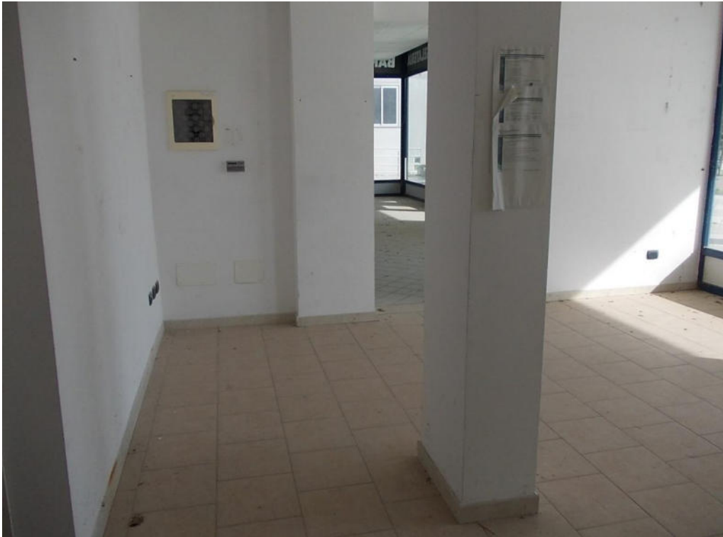
Foto 17 Particolare interno negozio lotto 3
