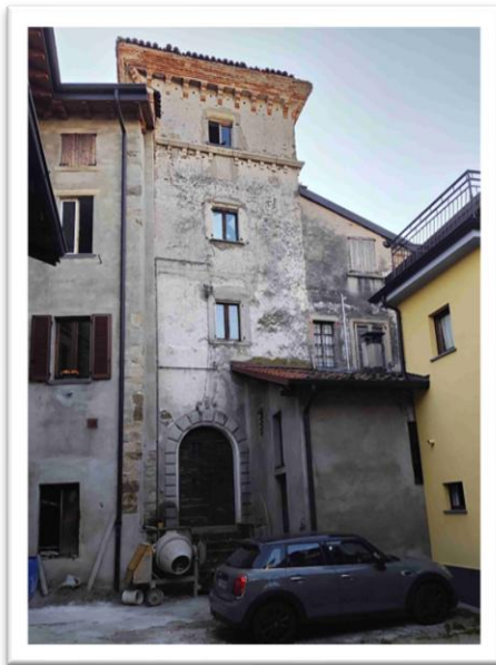
vista dal Cortile interno
