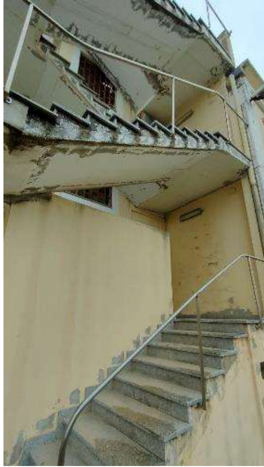
foto 9 - scala esterna sub. 1
