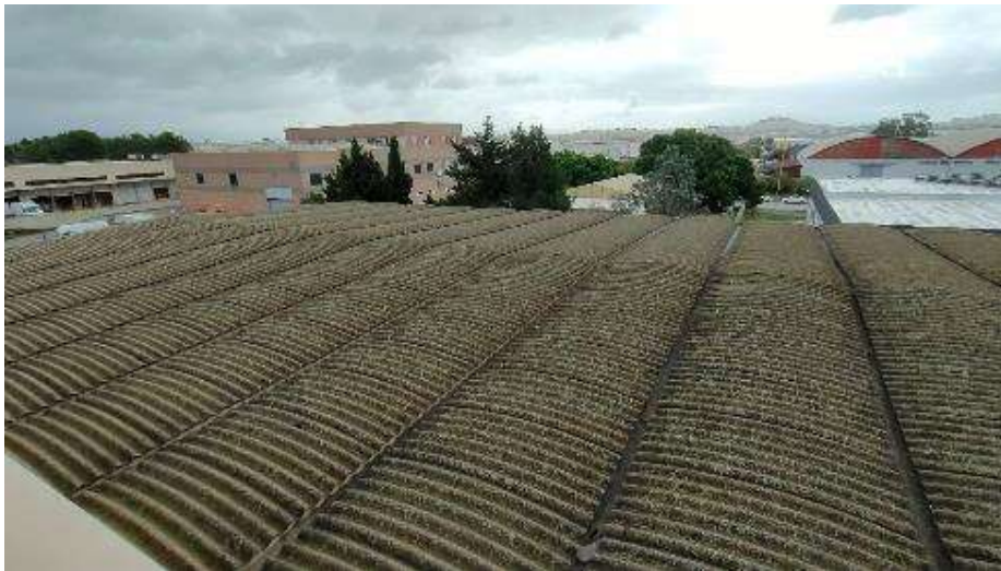
foto 10 – copertura in amianto del sub. 2
