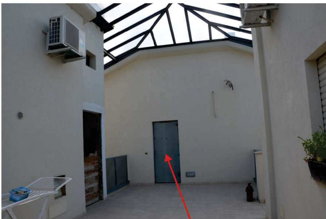
FOTO N. 4 Piano Secondo Sottotetto - Ingresso
