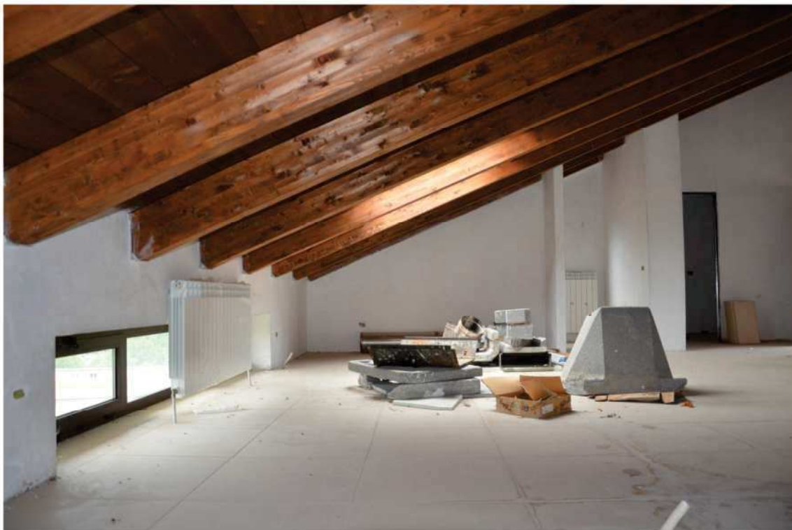
FOTO N. 11 Piano Secondo - Sottotetto
