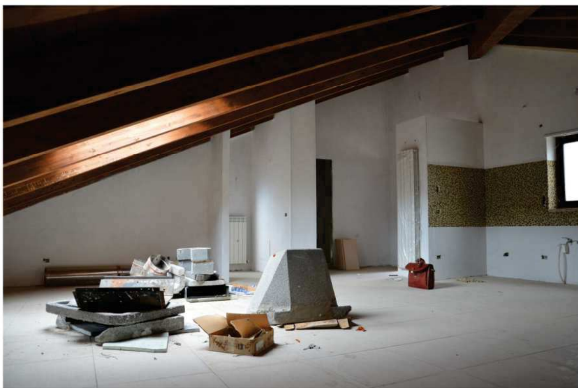
FOTO N. 8 Piano Secondo - Sottotetto
