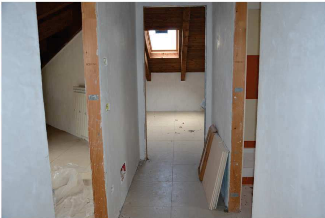
FOTO N. 13 Piano Secondo - Sottotetto
