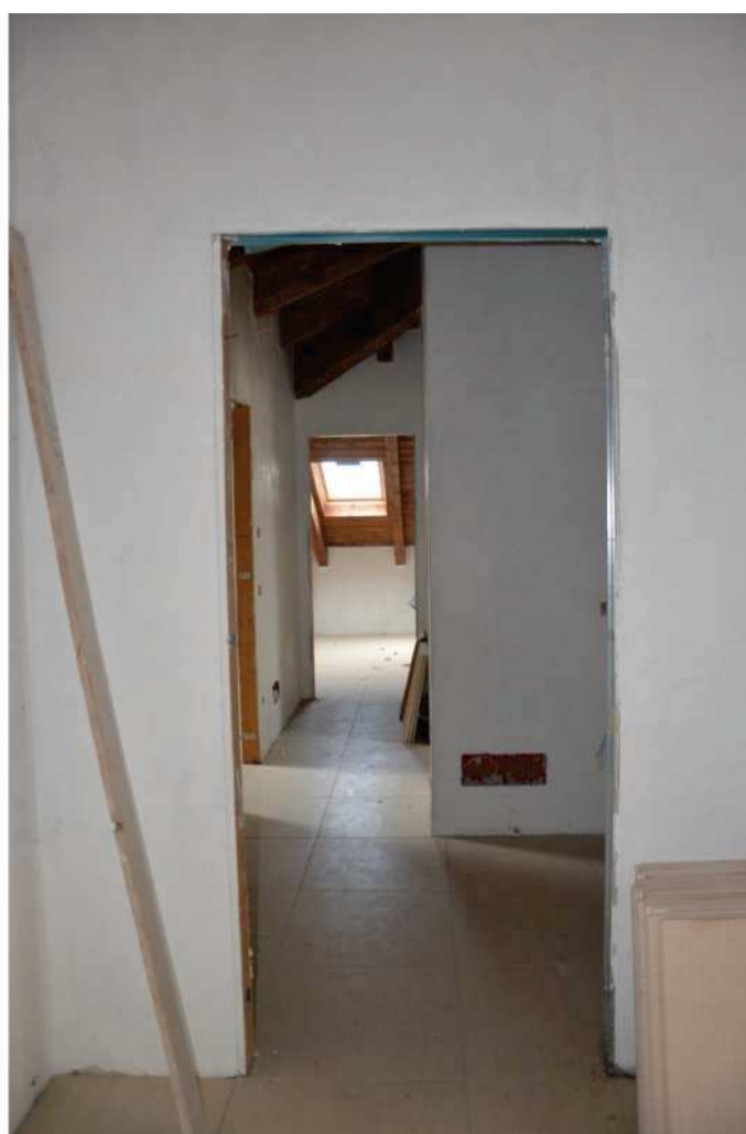
FOTO N. 12 Piano Secondo - Sottotetto
