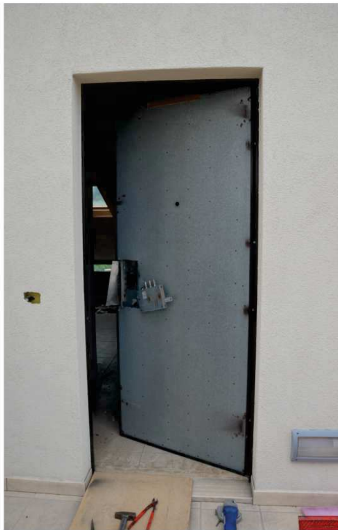
FOTO N. 5 Piano Secondo - Sottotetto Sostituzione serratura
