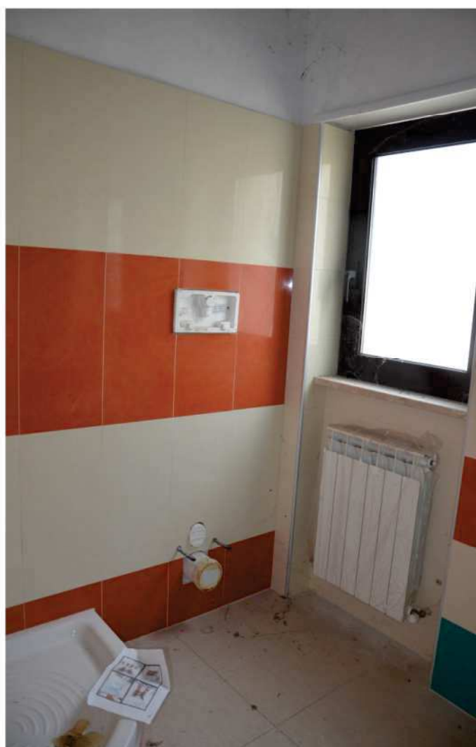
FOTO N. 14 Piano Secondo - Sottotetto
