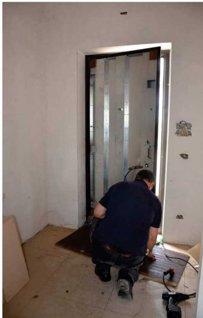
FOTO N. 7 Piano Secondo - Sottotetto Sostituzione serratura
