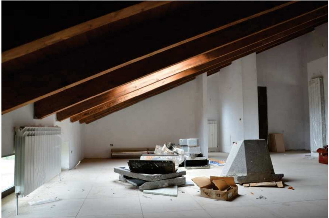
FOTO N. 9 Piano Secondo - Sottotetto
