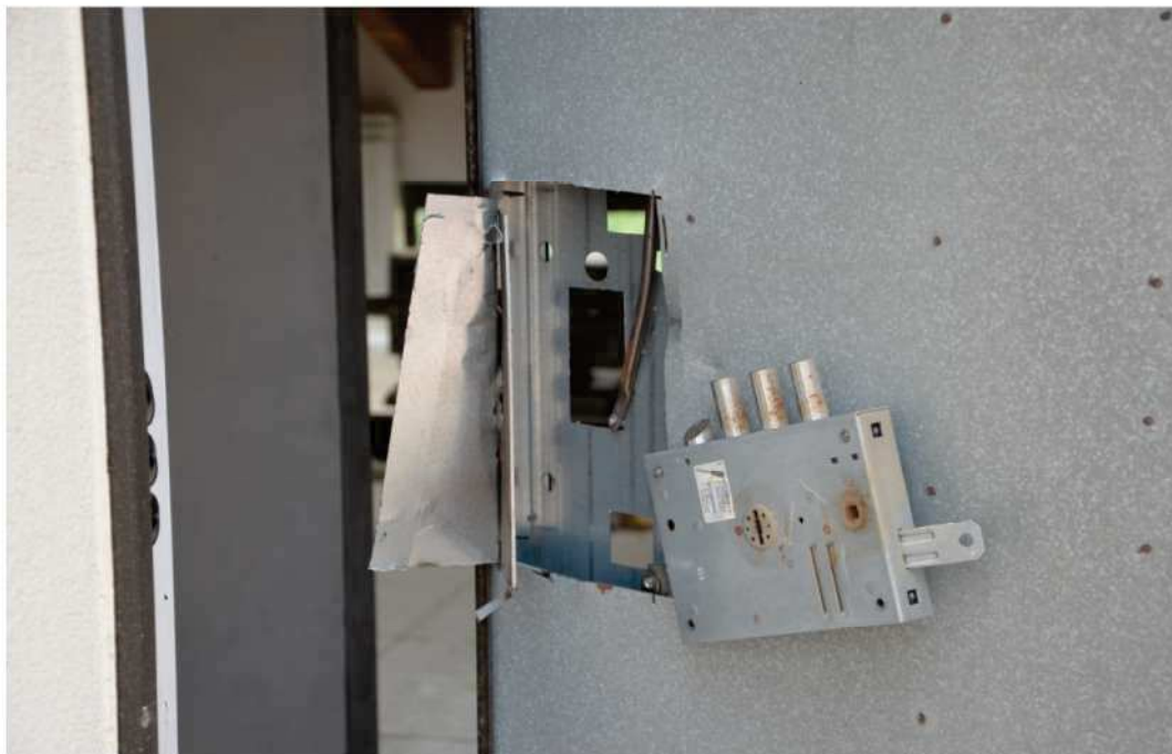
FOTO N. 6 Piano Secondo - Sottotetto Sostituzione serratura
