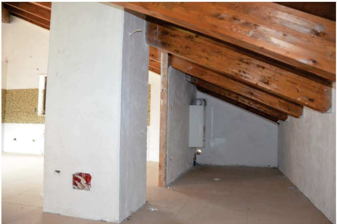
FOTO N. 10 Piano Secondo - Sottotetto
