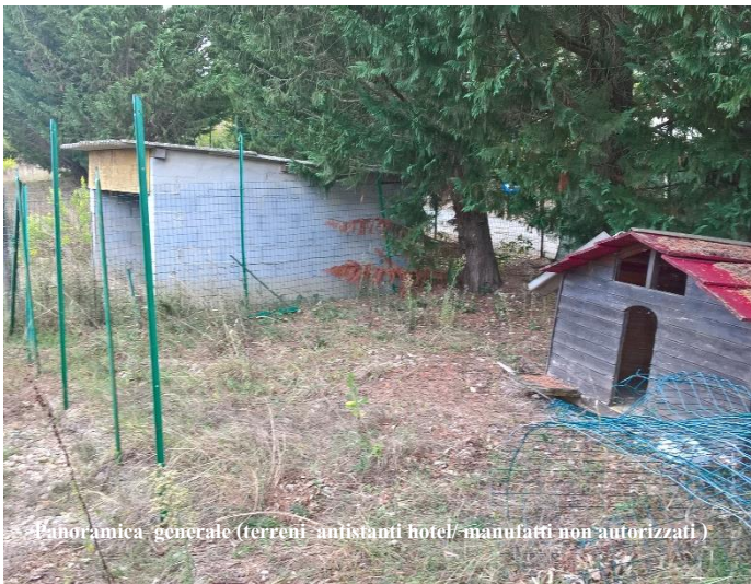
- Panoramica generale (terreni antistanti hotel/parcheggio e manufatti non autorizzati)
