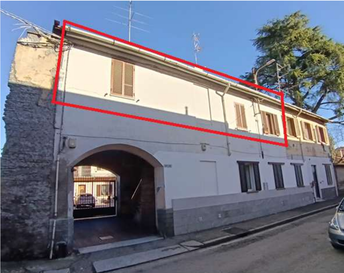
Vista esterna da Via Palestro
