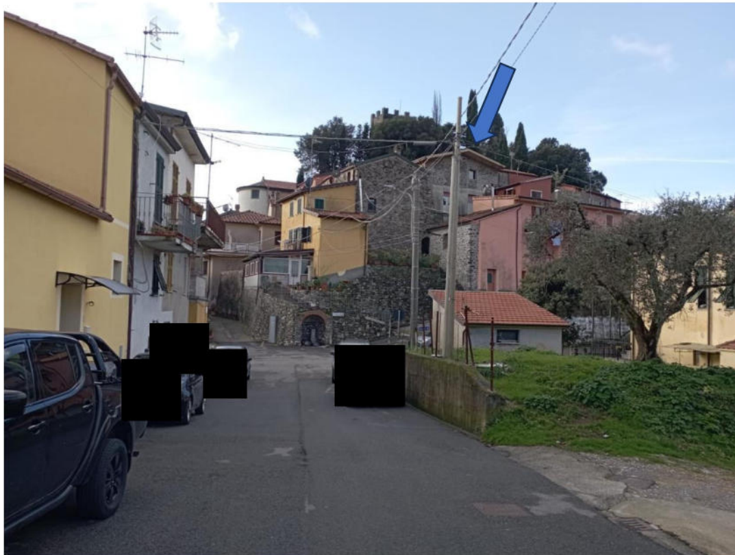
Figura 1 l'edificio vista da nord
