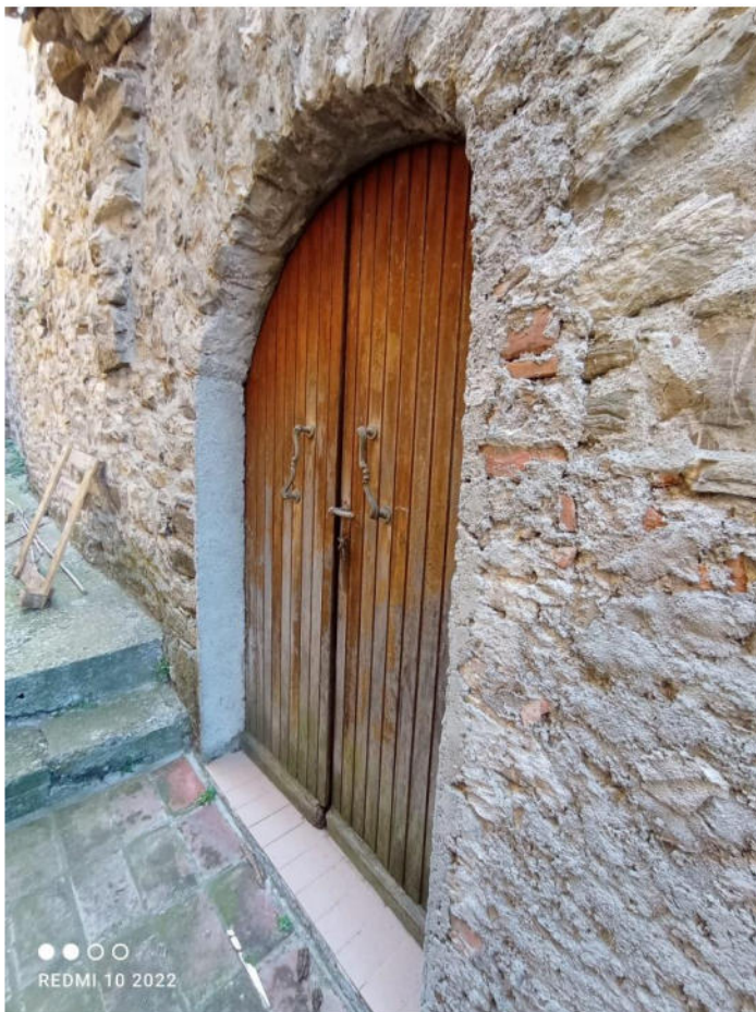
Figura 4 l'ingresso alla cantina
