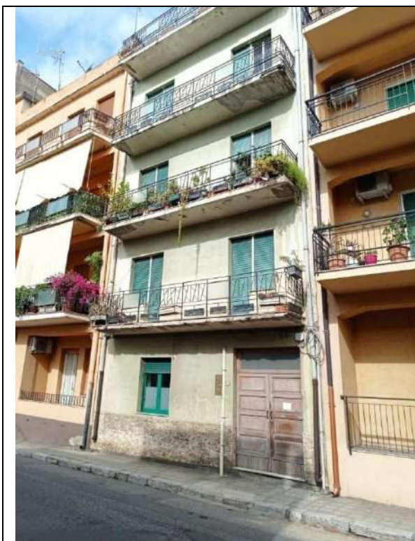
Foto 2. Vista esterna del fabbricato, prospetto principale, lato Sud
