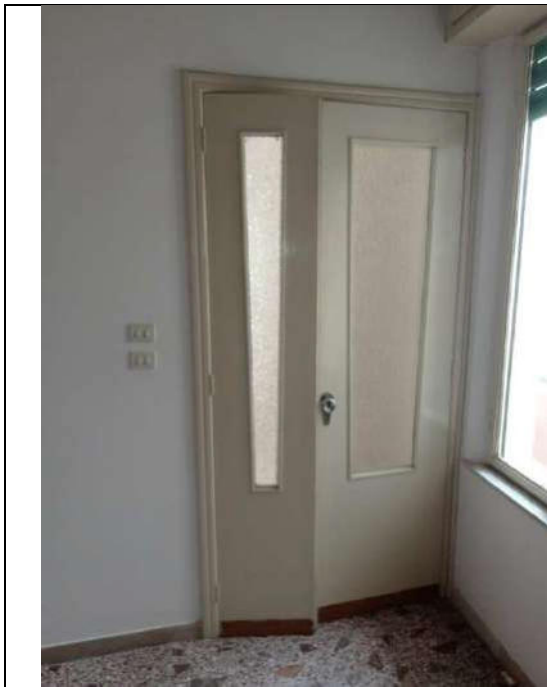
Foto 59. Particolare della tipologia di porta interna, in legno, ad un'anta
