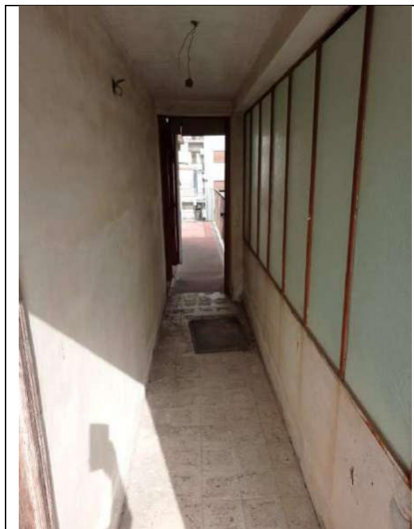
Foto 77. Vista del Corridoio
