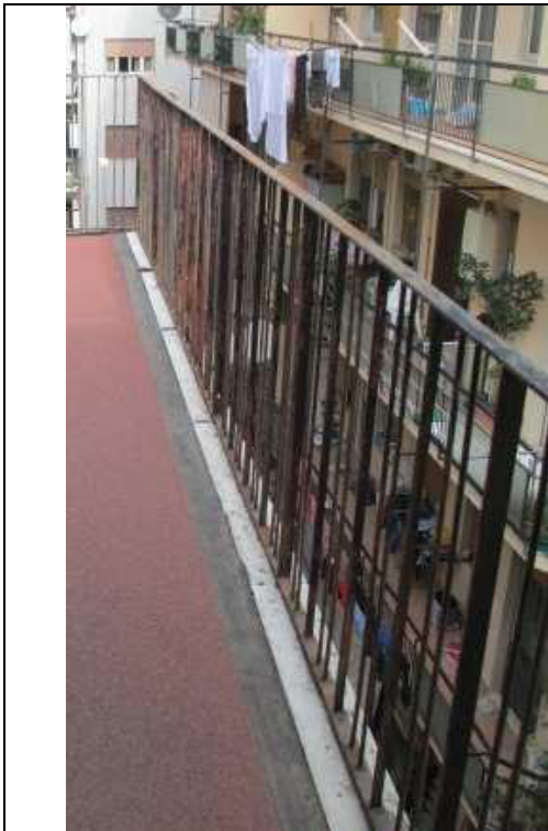
Foto 80. Particolare della tipologia di ringhiera in ferro presente sulle due terrazze praticabili, poste a Nord ed a Sud
