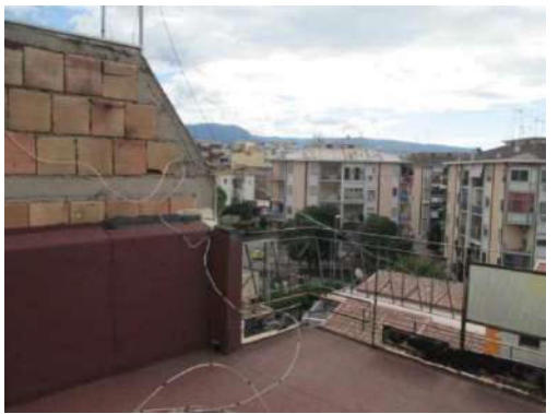
Foto 74. Particolari della terrazza praticabile posta sul lato Sud
