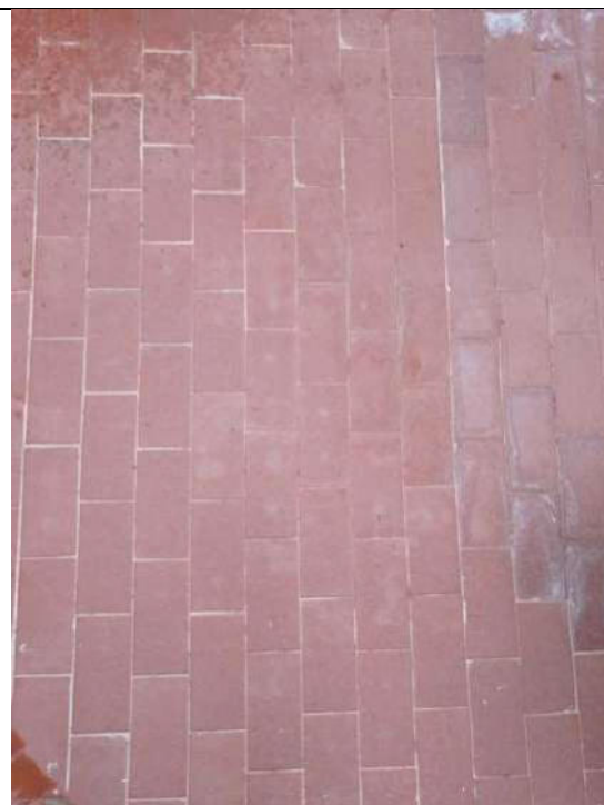
Foto 39. Particolare della tipologia di pavimentazione, in piastrelle di ceramica da esterno, presente nell'immobile, al piano Terra, nel cortile
