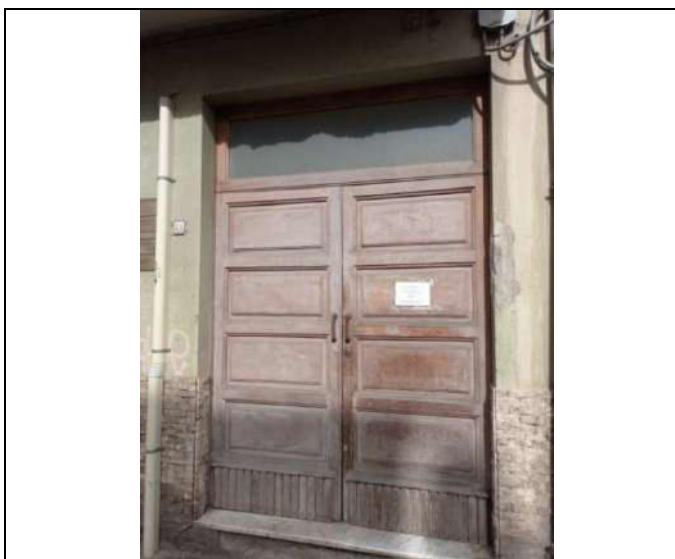
Foto 4. Particolare del portone di accesso alla scala del fabbricato dove sono presenti le unità abitative oggetto di pignoramento ai subb. 1,3,4 e 7
