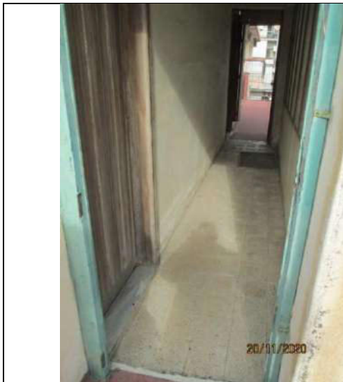
Foto 75. Particolare del Corridoio comune che consente l'accesso alle due terrazze
