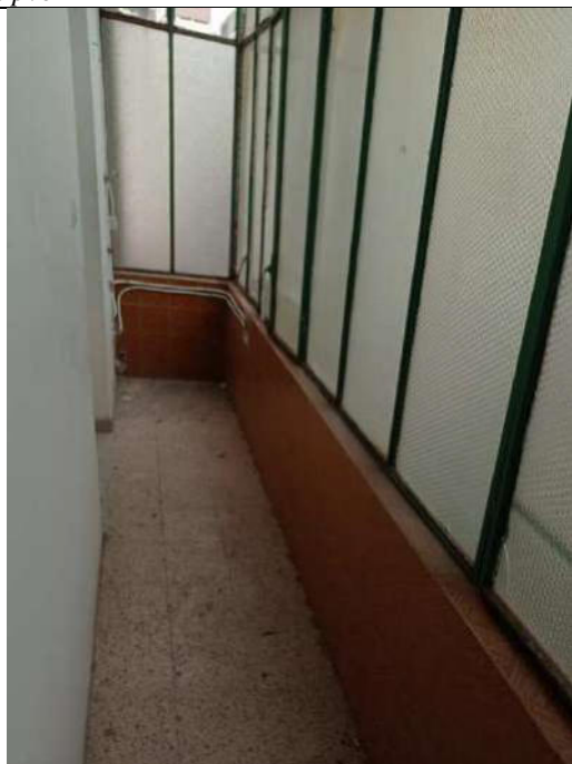
Foto 63. Particolare della tipologia vetrata presente nella veranda in ferro, vetro singolo, a tutta altezza, dal parapetto all'estradosso del balcone
