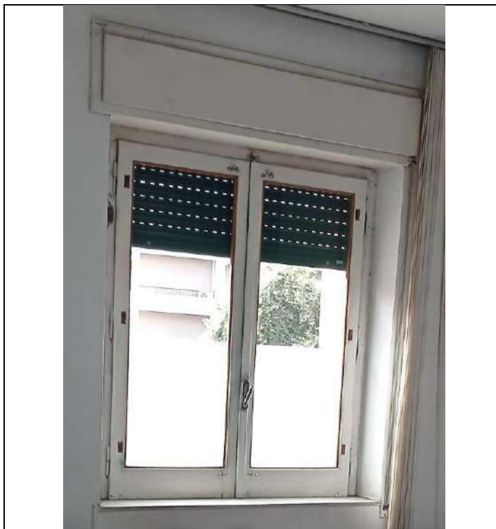
Foto 37. Particolare della tipologia di finestra, in legno, a due ante, con avvolgibile in pvc
