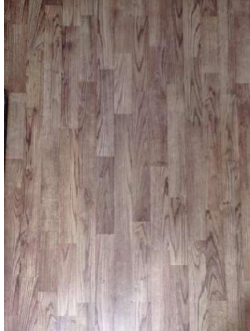
Foto 56. Particolare della tipologia di pavimentazione, in piastrelle di ceramica, tipo finto parquet, presente all'interno dell'ambiente Cucina, nell'immobile, al piano Secondo
