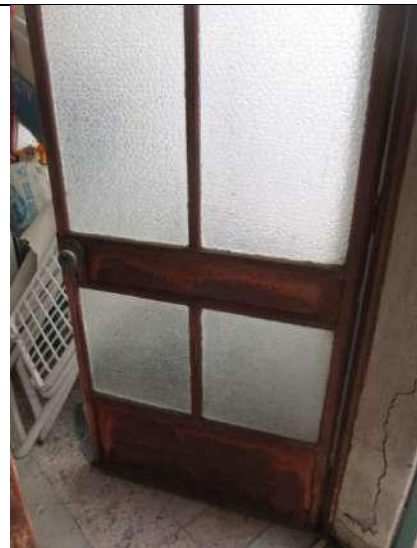
Foto 76. Particolare del Corridoio che disimpegna i due locali di sgombero e la terrazza praticabile
