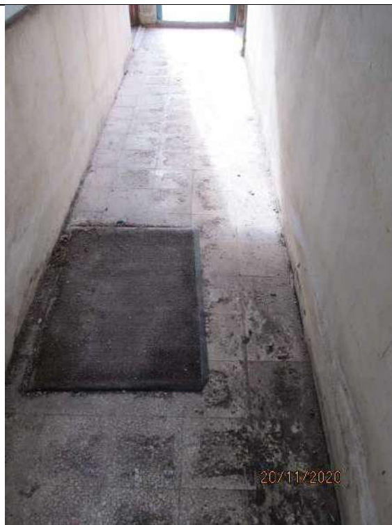
Foto 79. Particolare della tipologia di pavimentazione, in granigliato, presente all'interno dei locali insistenti sul lastrico solare
