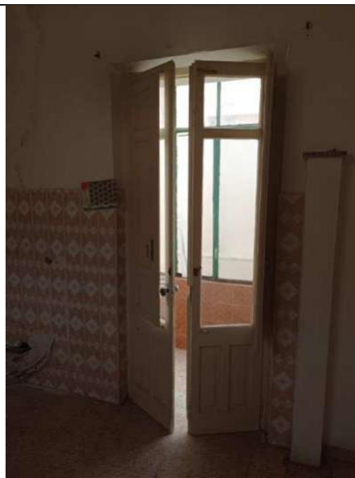
Foto 62. Particolare della tipologia porta-finestra esterna, in ferro, a due ante
