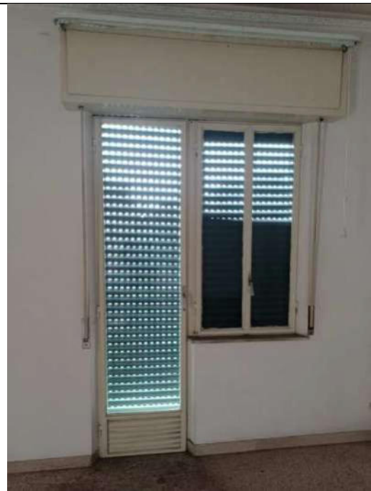
Foto 60. Particolare della tipologia di porta-finestra, in ferro, a due ante, vetro singolo, con tapparelle in pvc
