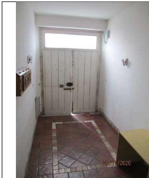
Foto 5. Particolare dell'androne scala del fabbricato
