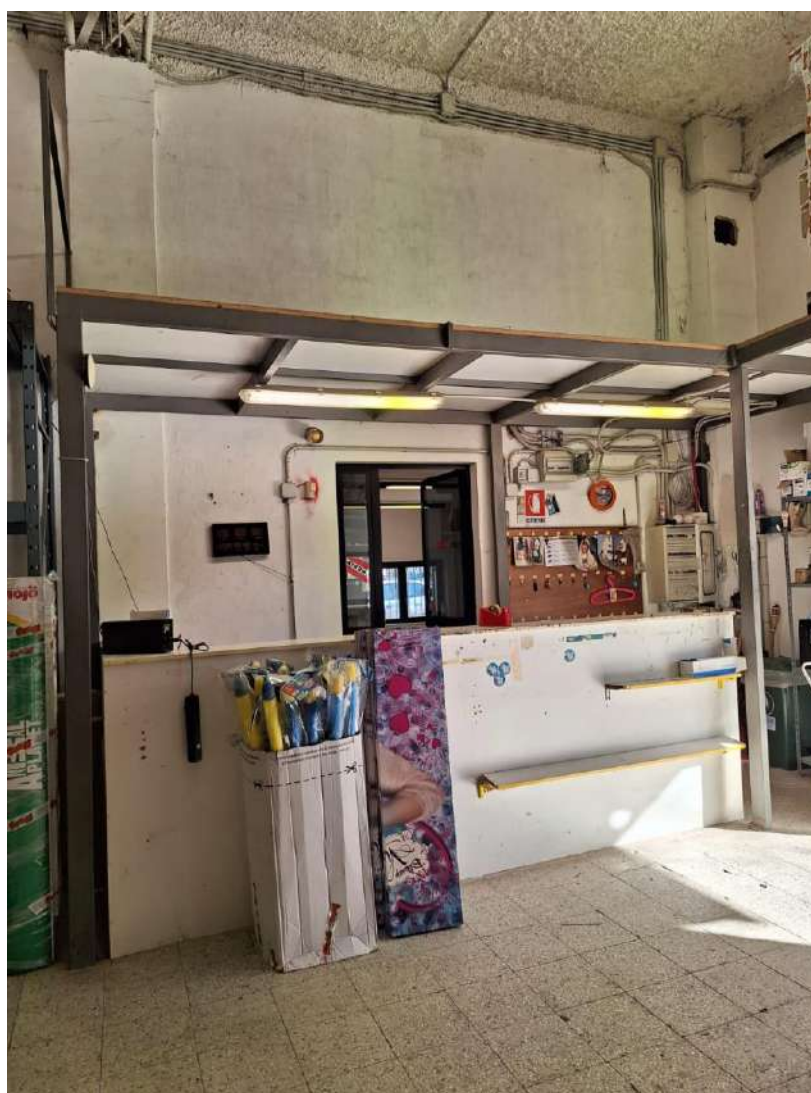
Foto N.8 – Particolare interno capannone con accesso locali ufficio
