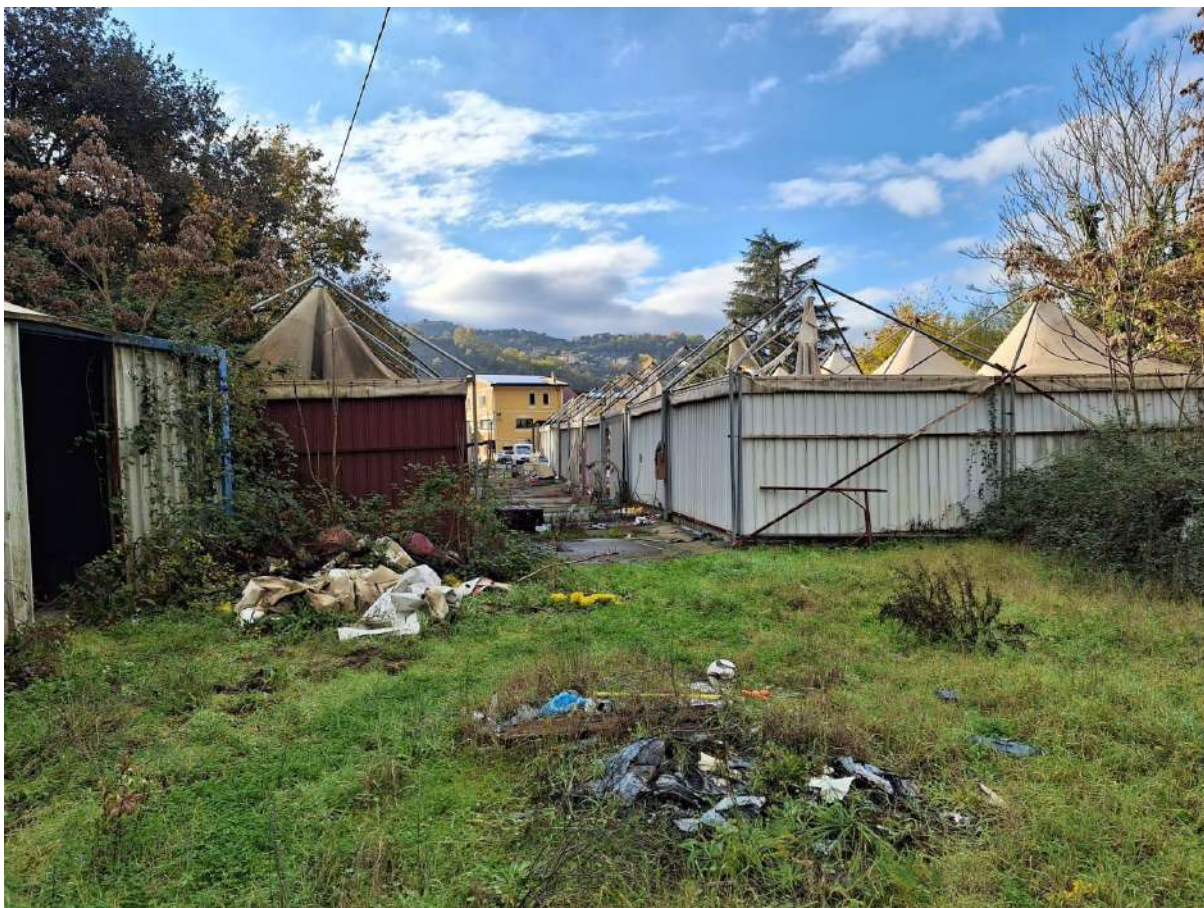
Foto N.23 – Gazebo vista lato Est
