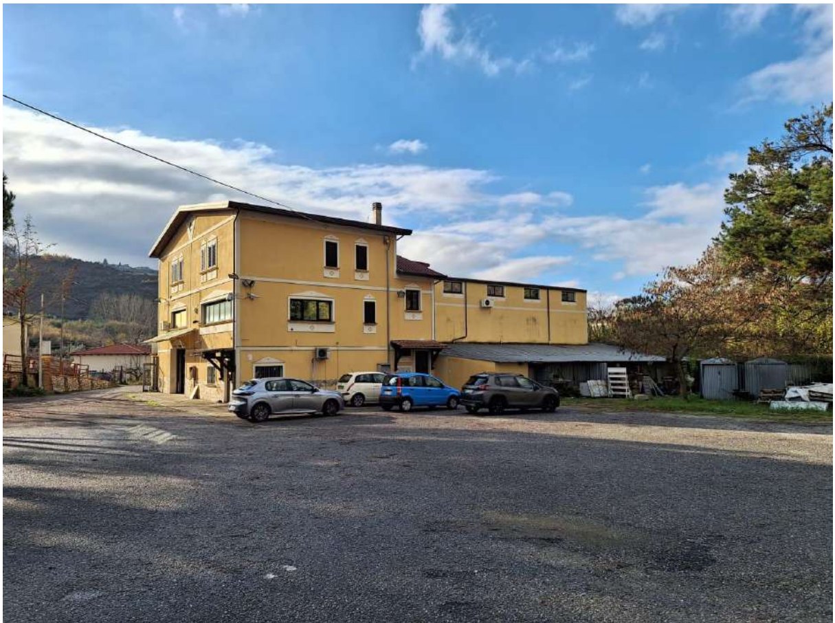
Foto N.2 – Prospetto capannone lato piazzale interno
