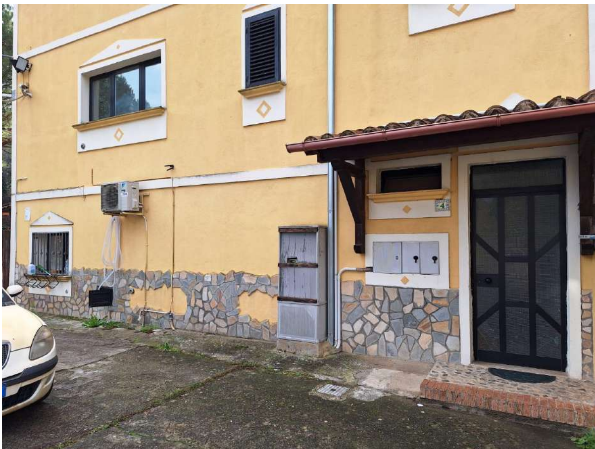
Foto N.4 – Particolare ingresso vano scala per accesso ai piani superiori
