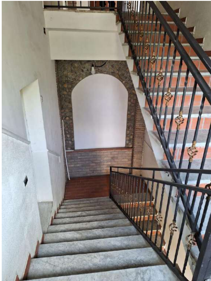
Foto N.17 – Particolare vano scala per accesso appartamenti e sottotetto capannone
