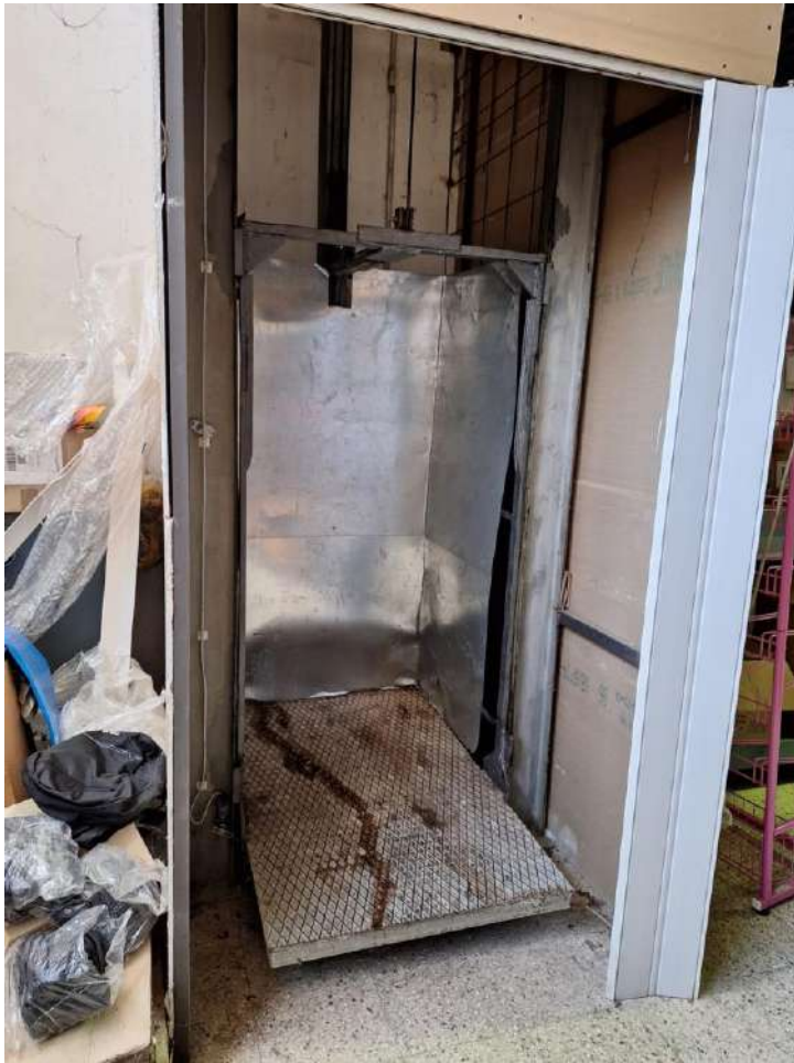
Foto N.9 – Particolare montacarichi interno al capannone
