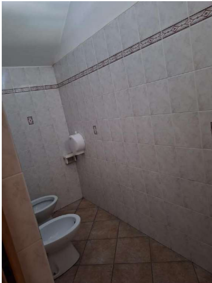
Foto N.16 – Particolare bagno ufficio a Piano Terra
