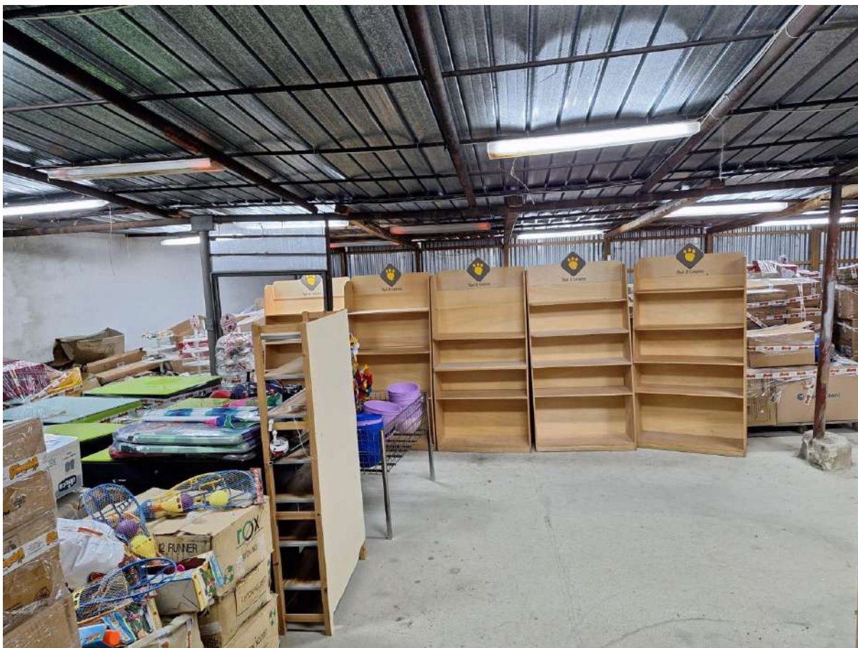
Foto N.11 – Particolare interno tettoia chiusa in lamiera
