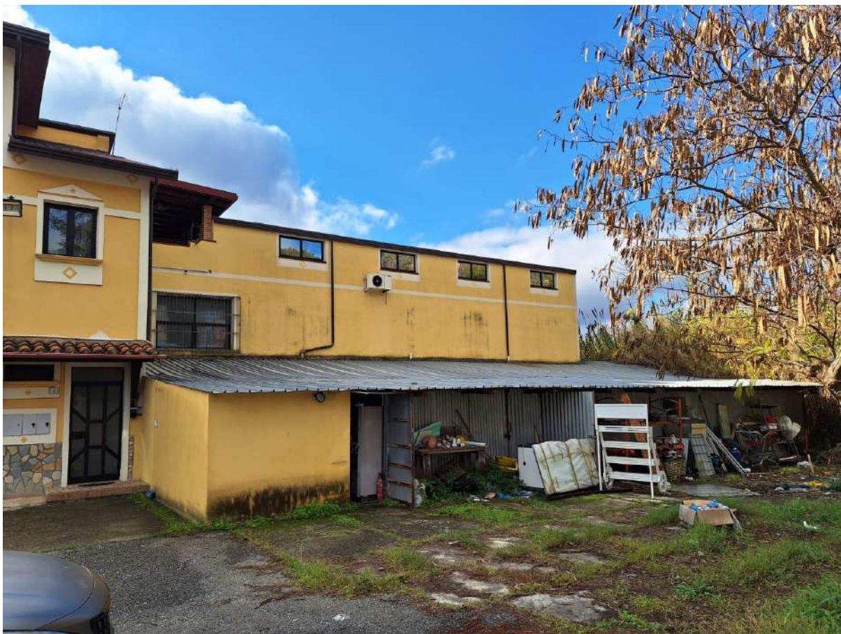
Foto N.5 – Particolare tettoia chiusa in lamiera posta sul lato interno piazzale
