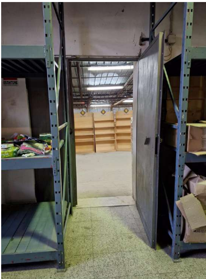
Foto N.10 – Particolare porta di accesso alla tettoia chiusa in lamiera
