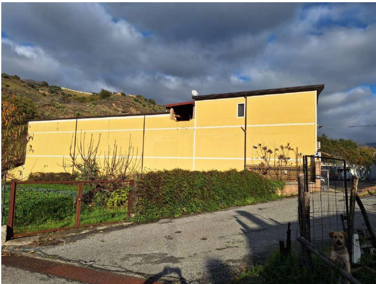
Foto N.3 – Prospetto laterale lato strada capannone
