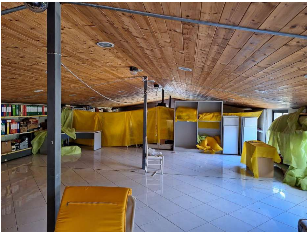
Foto N.19 – Piano sottotetto capannone
