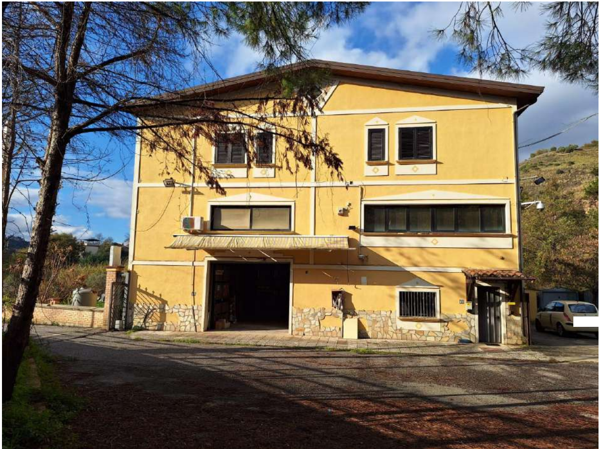
Foto N.1 – Prospetto principale capannone
