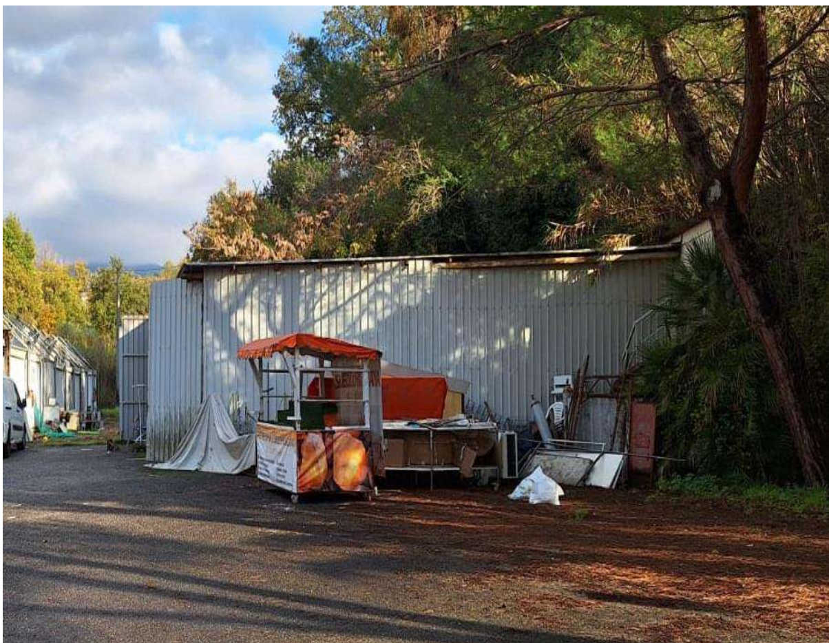
Foto N.26 – Baracca in lamiera a ridosso del muro di sostegno
