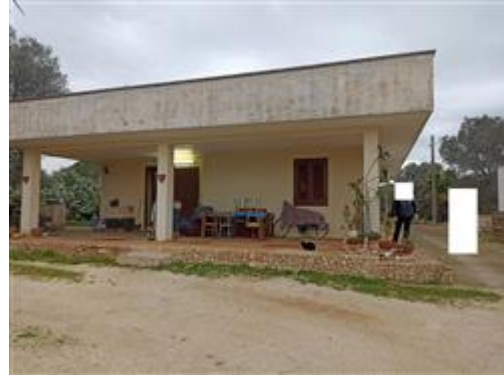
abitazione (foglio 46 particella 156 subalterno 4)
