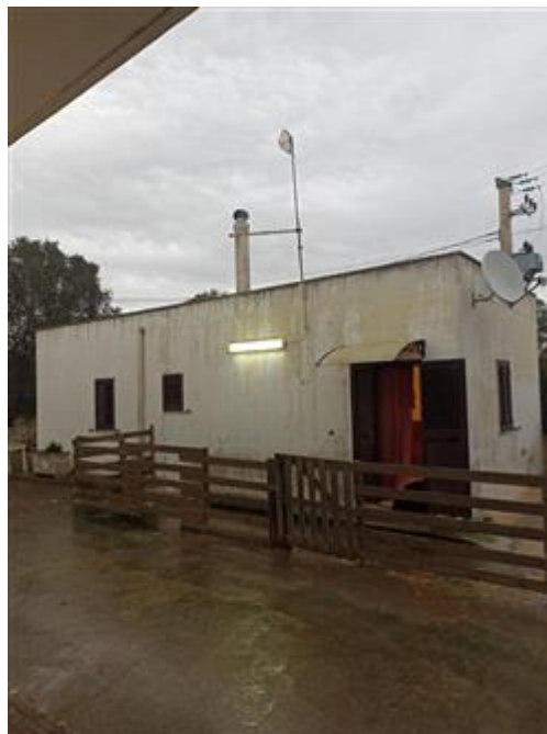
Abitazione (foglio 46 particella 156 subalterno 5)
