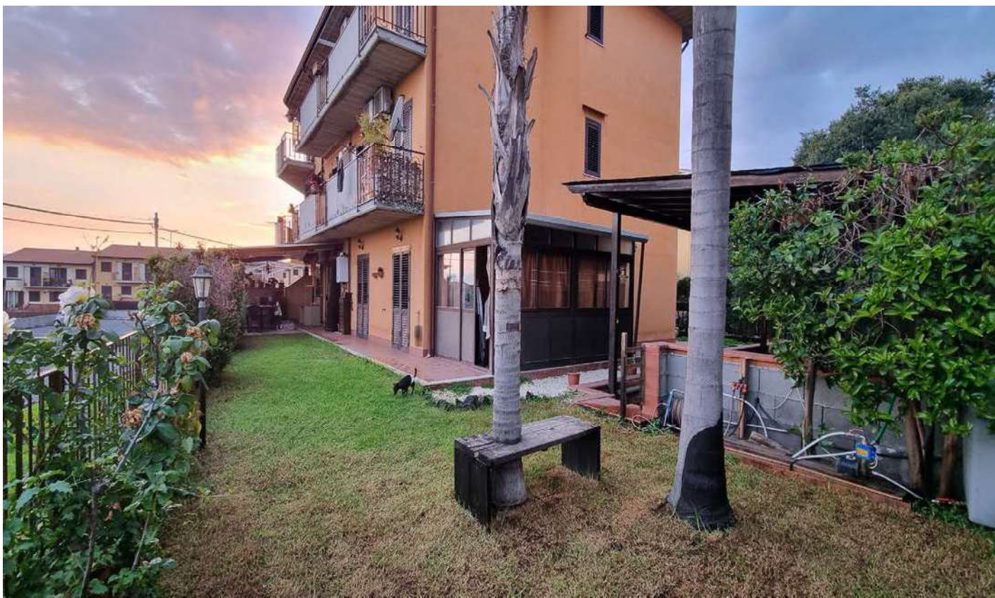
Allegato 23 – Area esterna con tettoie aperte e tettoia chiusa adibita a ripostiglio. Lato sudest con prospetto dell'edificio.
