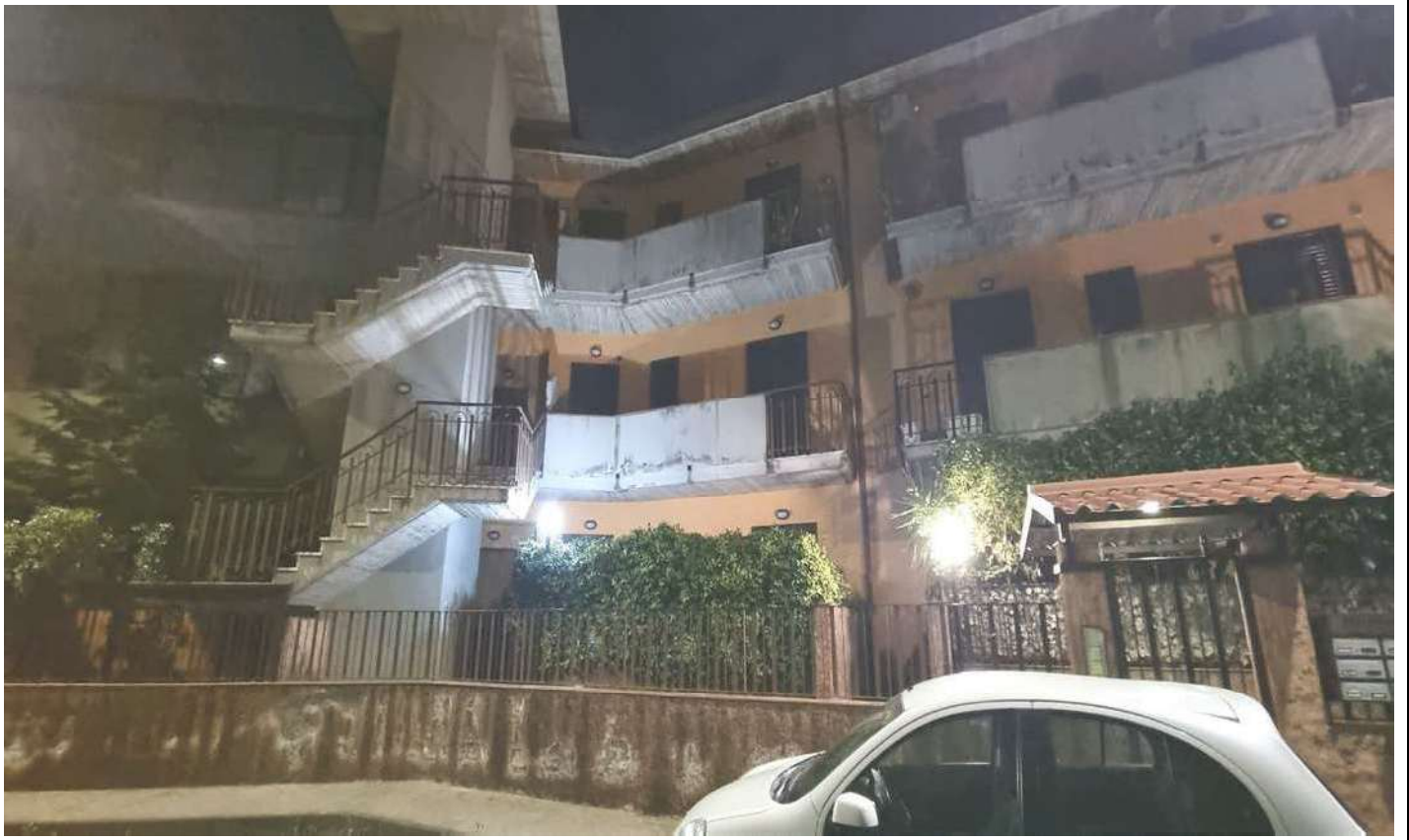
Allegato 33 – Prospetto dell'edificio sulla via Ugo Foscolo ed ingresso.
