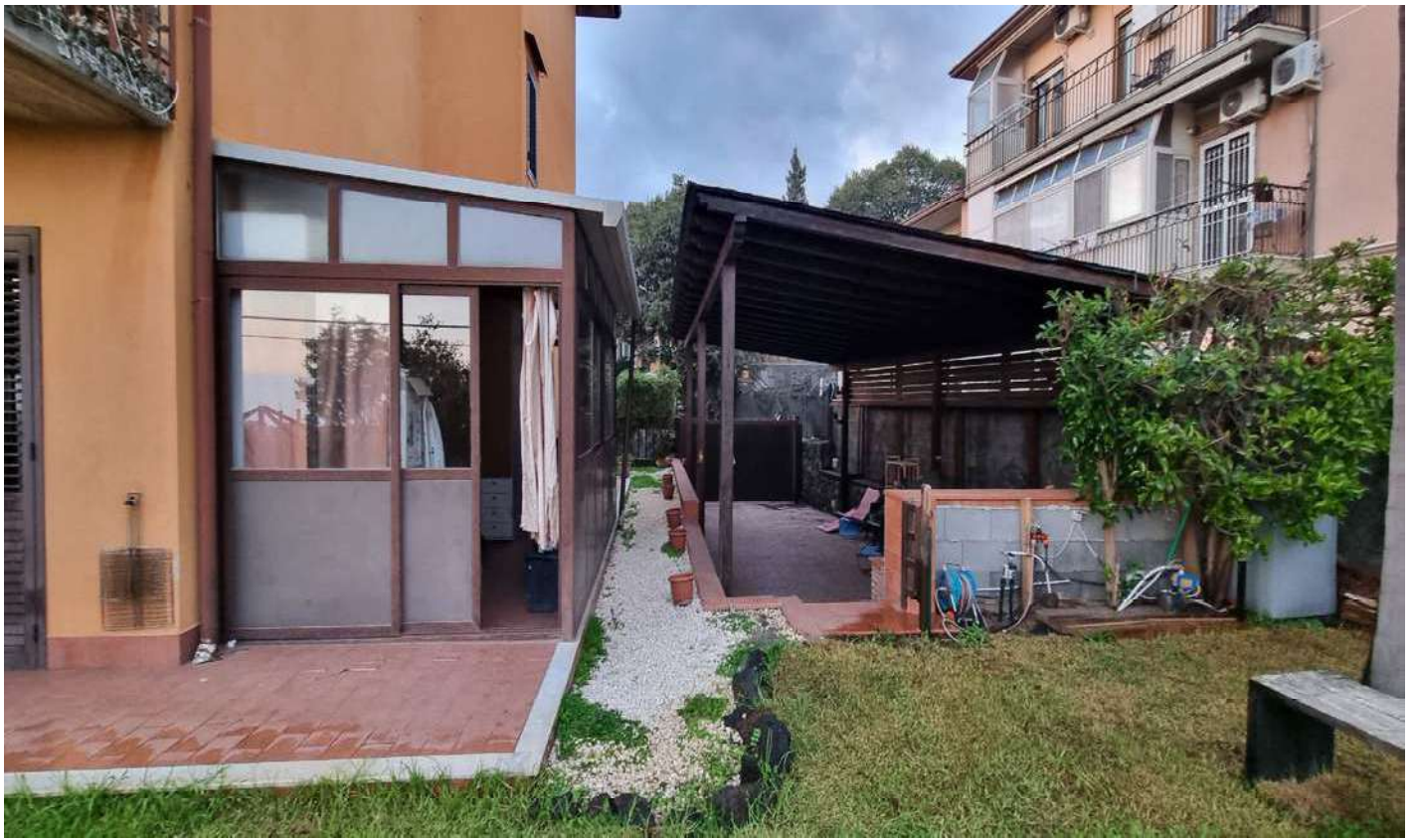
Allegato 25 – Area esterna con ripostiglio, tettoia adibita a posto auto e cancello di ingresso
