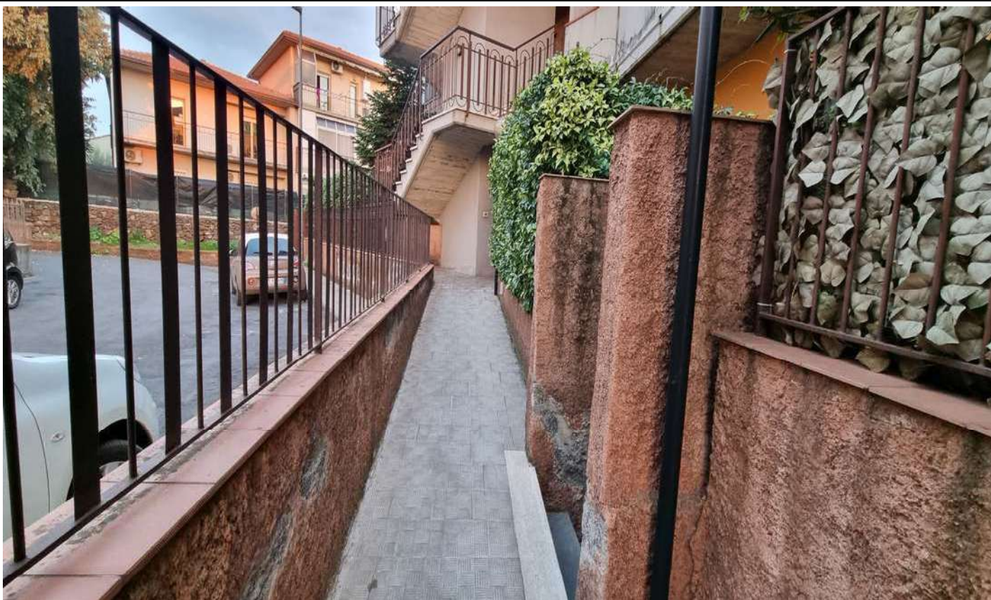
Allegato 4 – Accesso dalla via Ugo Foscolo e passaggio condominiale.
