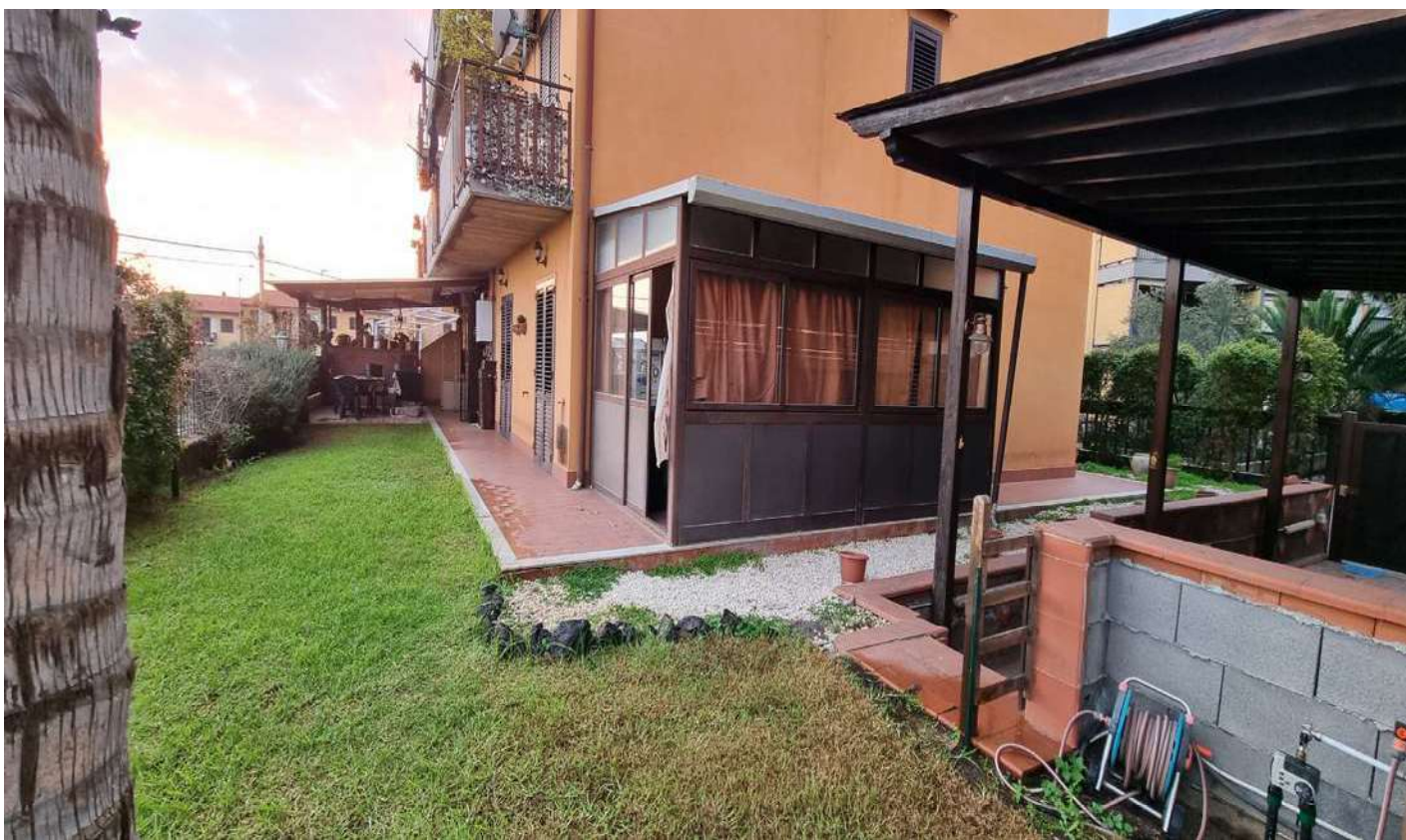
Allegato 24 – Area esterna con tettoie aperte e tettoia chiusa adibita a ripostiglio. Lato sudest
