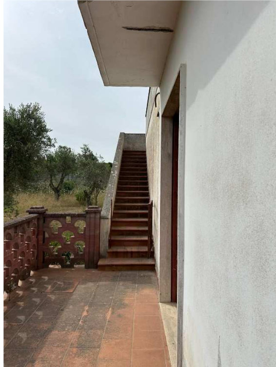
Foto 08: Vista esterna – Scala accesso terrazza
