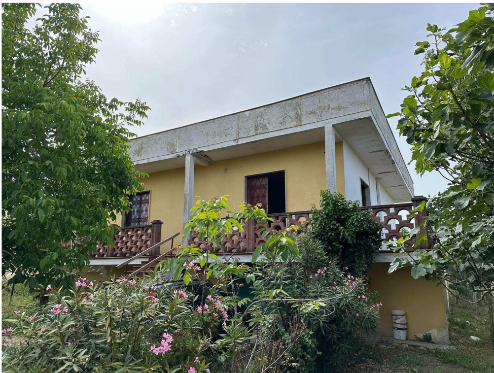
Foto 04: Vista esterna – Prospetto frontale
