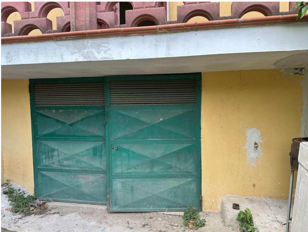
Foto 02: Vista esterna – Vano deposito
