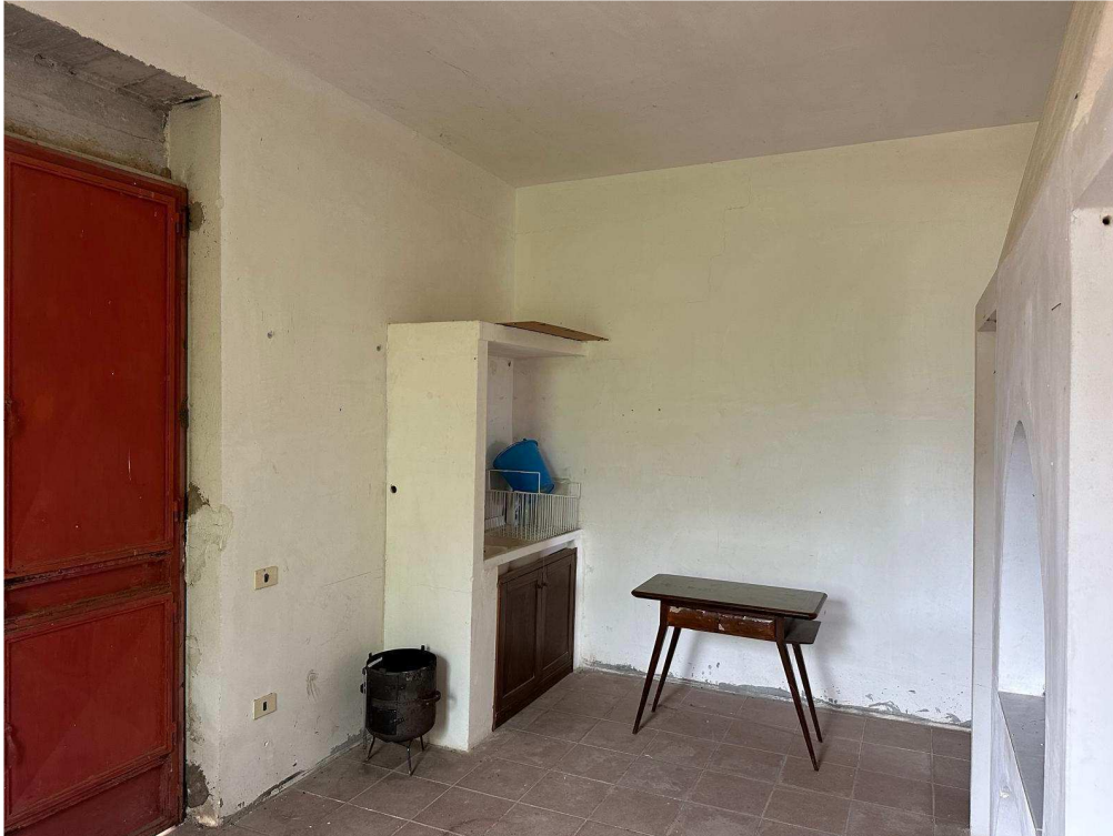
Foto 12: Vista interna – Vano cucina
