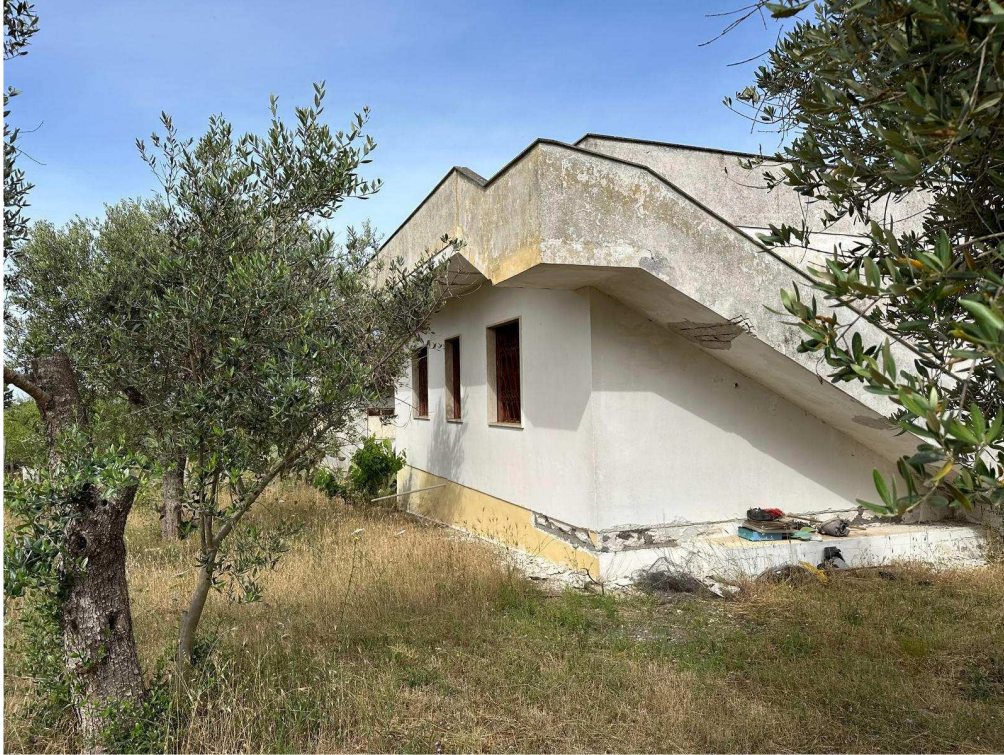
Foto 07: Vista esterna – Prospetto retrostante
