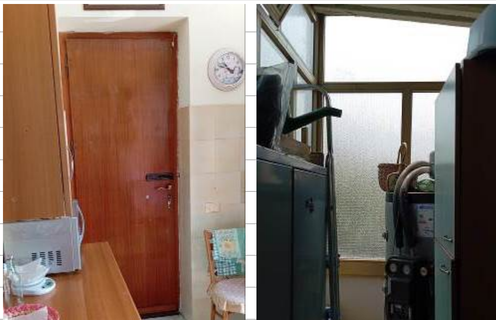
Foto 15 - 16_ Piano terra – viste dell'accesso e della veranda
