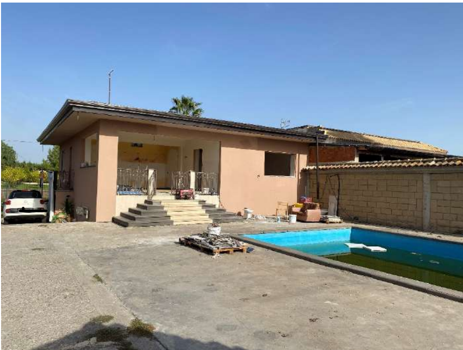
Foto 2: Vista prospetto principale, come è possibile evincere dalla foto l'immobile è stato recentemente ristrutturato, seppur tali lavori non risultano ancora completi, come meglio descritto nella perizia di stima.
