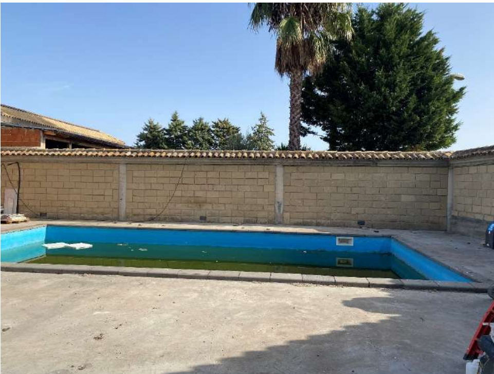
Foto 6: Vista piscina interrata da regolarizzare
