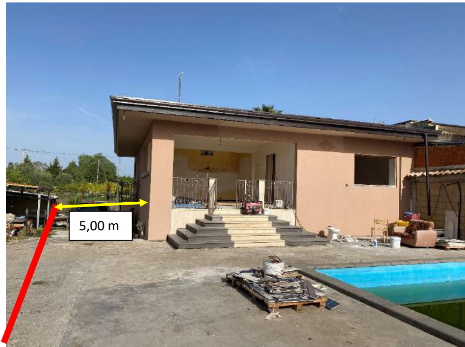
Foto 4: Vista prospetto principale, la linea rossa indica il confine di proprietà del lotto da ripristinare.
