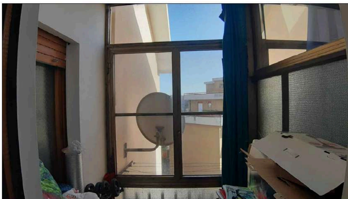
foto 12 - vista del balcone n. 2 con la vetrata da rimuovere.
