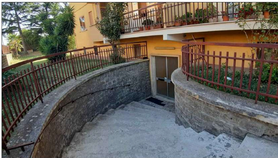
foto 3 - dettaglio dell'ingresso pedonale al vano scala principale dell'edificio.
