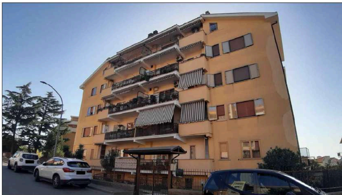
foto 1 - vista della facciata principale dell'edificio in cui sono ricompresi gli immobili oggetto di Pignoramento con l'ingresso al vano scala.
