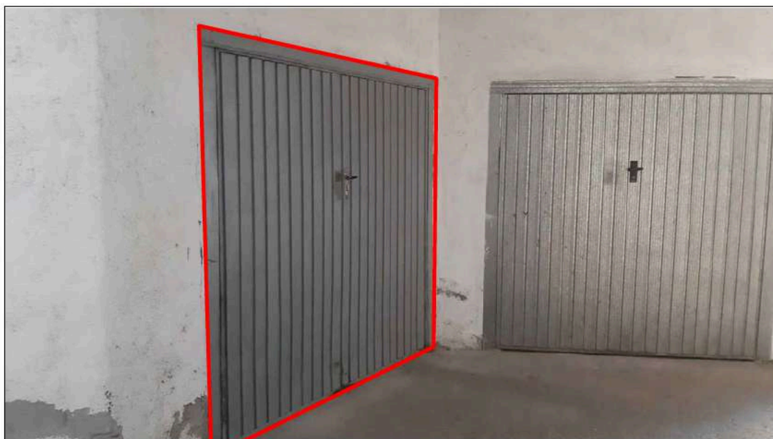
foto 20 - vista delle porte dei garage (bene pignorato lato sinistro).
