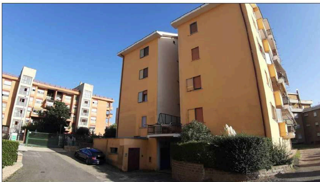
foto 2 - vista di una facciata secondaria, con l'ingresso carrabile al piano seminterrato ove sono ubicati i garage.
