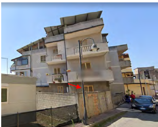
Foto 5- Prospetto su via S. Pio X
