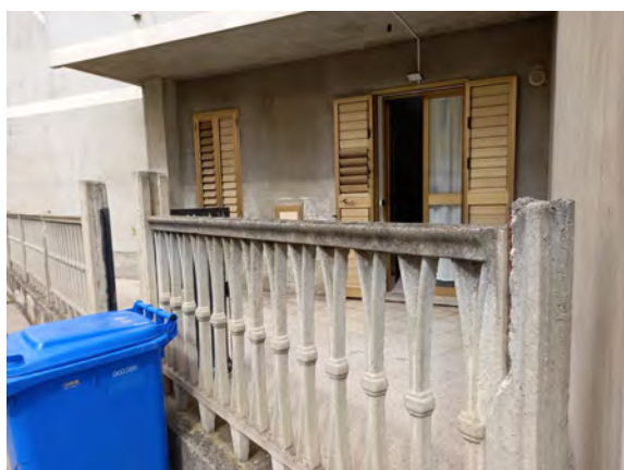
Foto 9: Veranda sulla via S. Pio X
