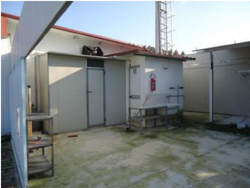
Foto n. 26 Bagno esterno e deposito
