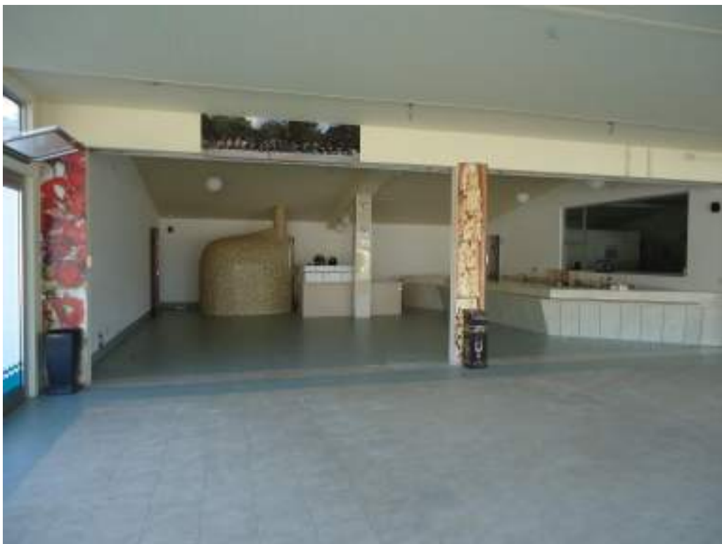
Foto n. 16 Interno veranda con collegamento corpo esistente
