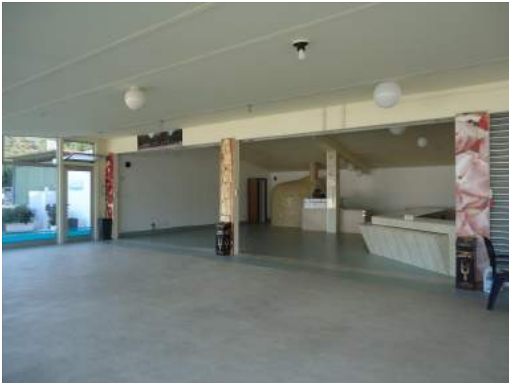
Foto n. 15 Interno veranda con collegamento corpo esistente
