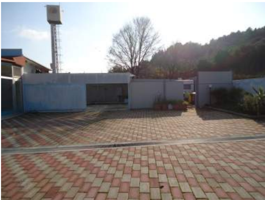
Foto n. 31 Piazzale esterno comprendente p.lle 2020, 2022 e 2406
