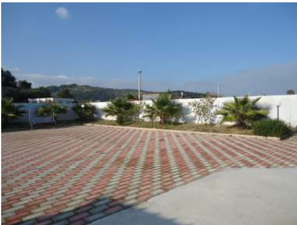
Foto n. 29 Piazzale esterno comprendente p.lle 2020, 2022 e 2406
