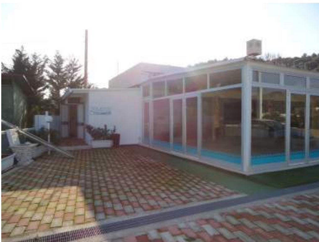
Foto n. 6 Vista Veranda e bagni lato Nord
