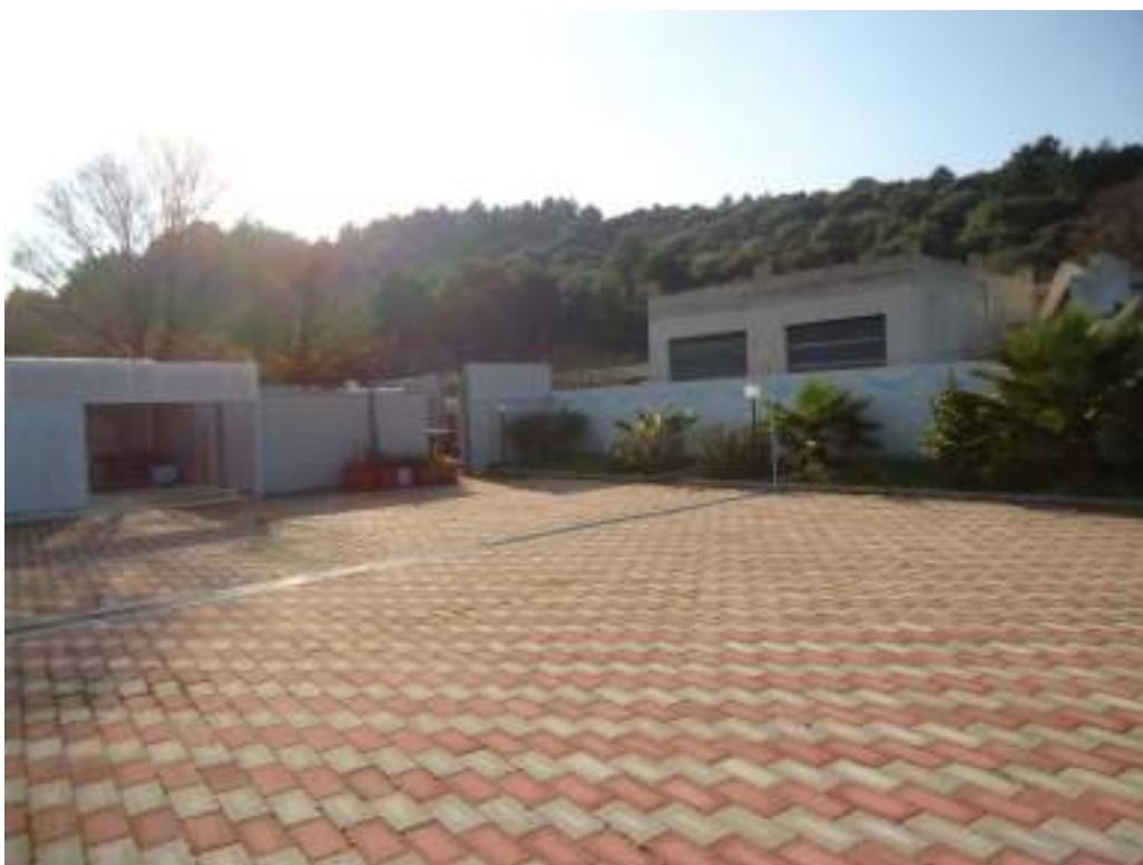
Foto n. 30 Piazzale esterno comprendente p.lle 2020, 2022 e 2406
