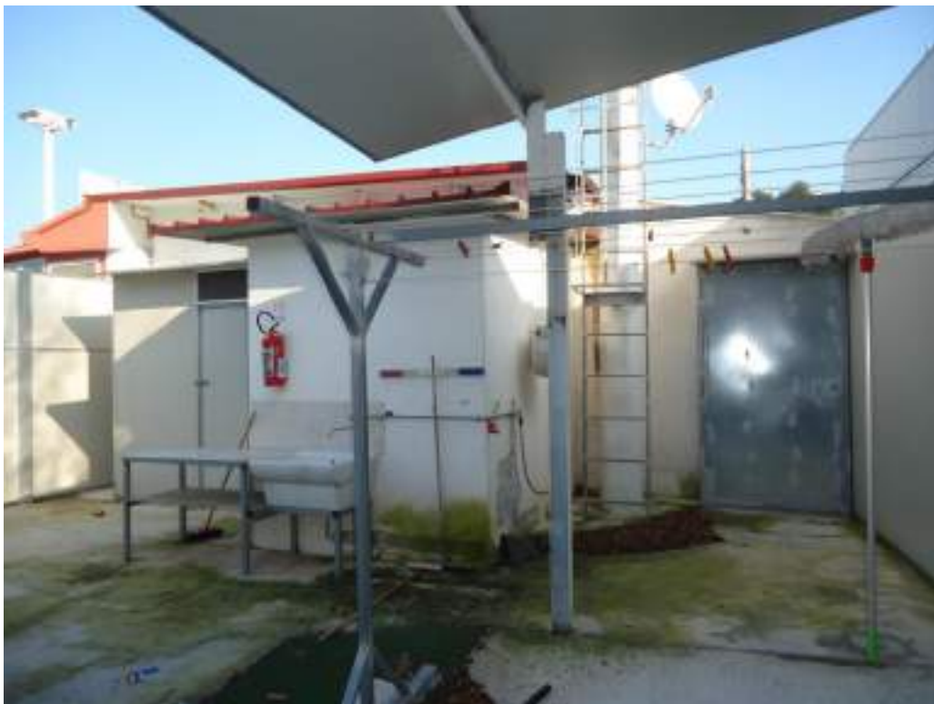
Foto n. 28 Esterno lato sud
