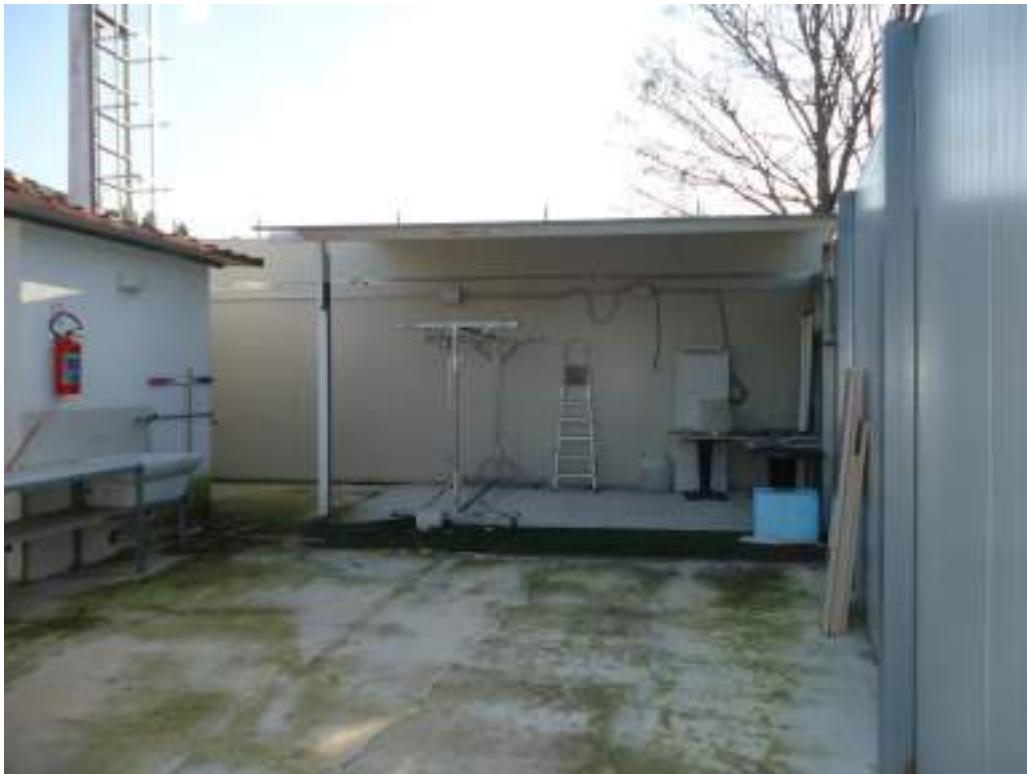
Foto n. 27 Tettoia esterna Sub. 7
