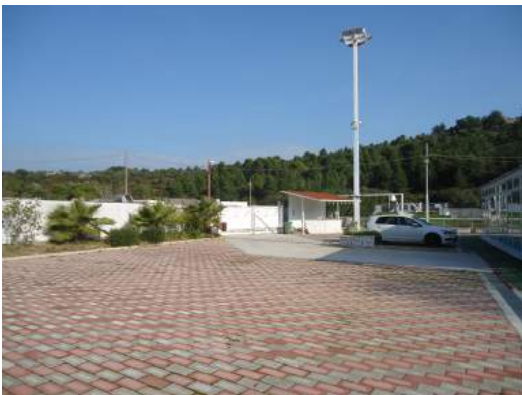
Foto n. 32 Piazzale esterno comprendente p.lle 2020, 2022 e 2406
