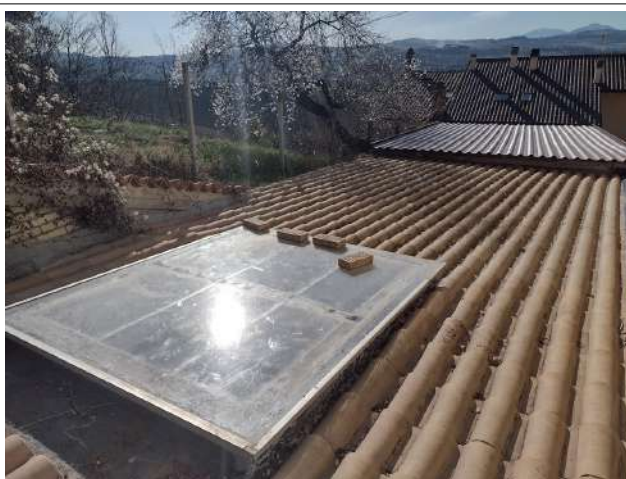
Copertura accessorio sub 8 sub 10 e vista copertura tettoia condominiale
