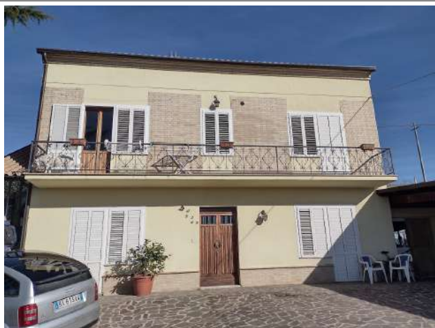
Fronte sud fabbricato f. 4 p.IIa 163
