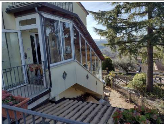
Part. Scala esterna tamponata e tettoia coperta p.terra
