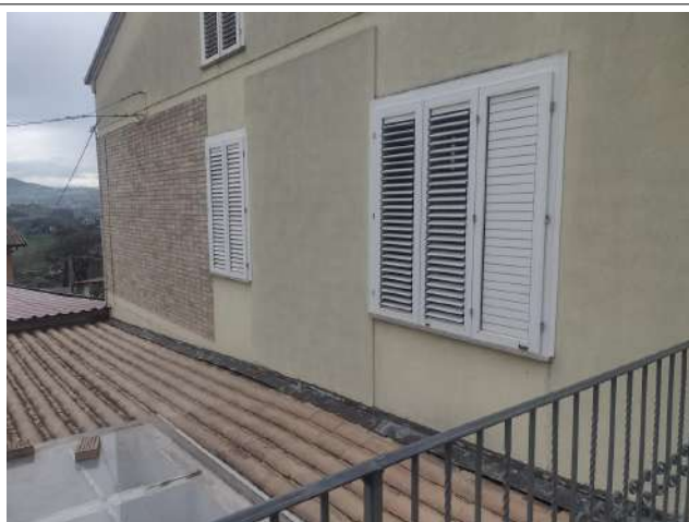
Copertura accessorio est
