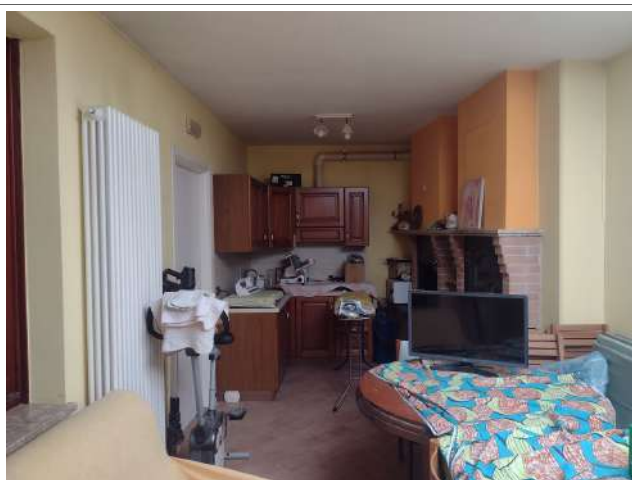
Interno deposito sub 8 adibito a taverna senza verifica areoilluminante ed altezze utili abitative
