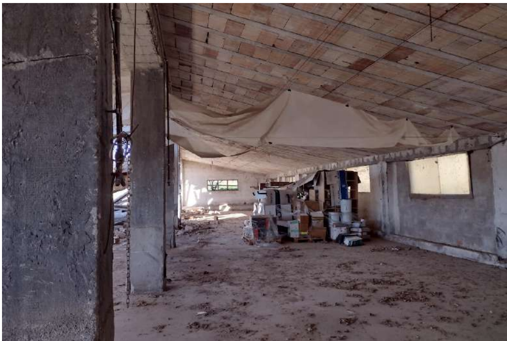
Interno fabbricato collabente ex pollaio
