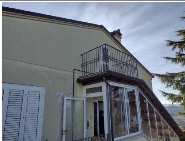
Part. Scala esterna tamponata con balconcino soffitta
