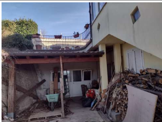
Tettoia esterna antistante il sub 11 su corte condominiale
