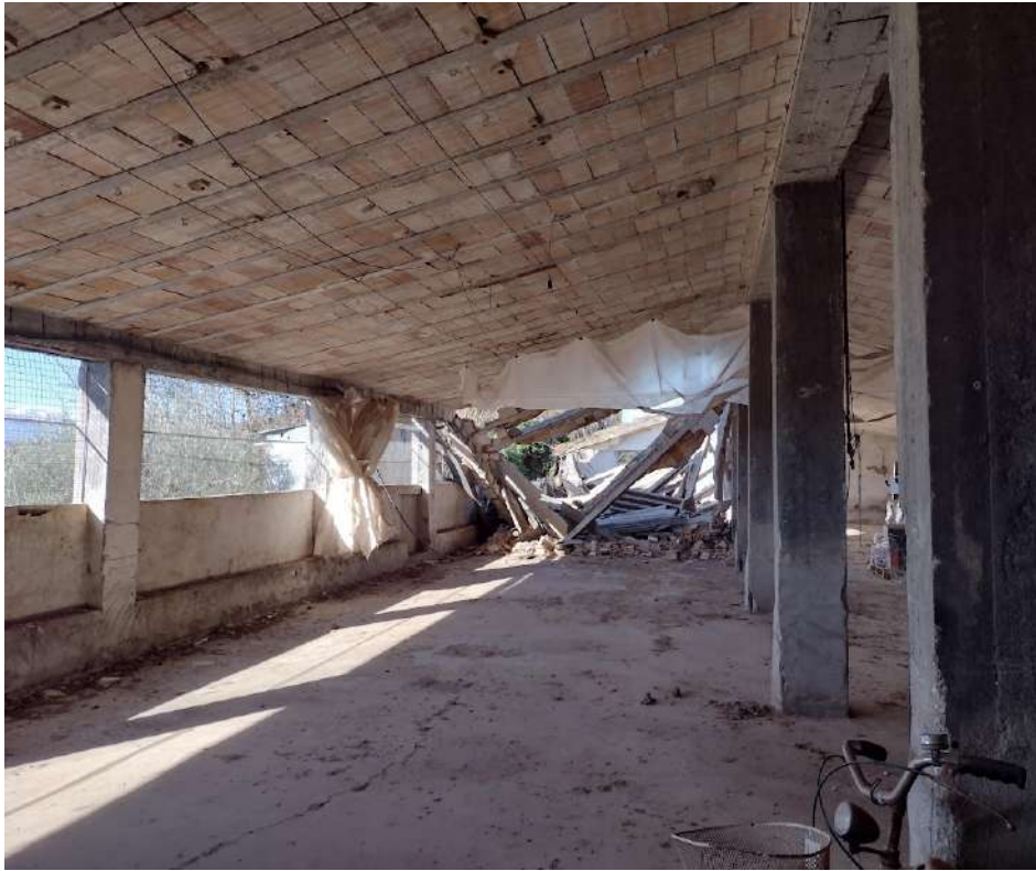
Interno fabbricato collabente ex pollaio
