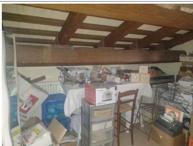
Interno soffitta sub 9
