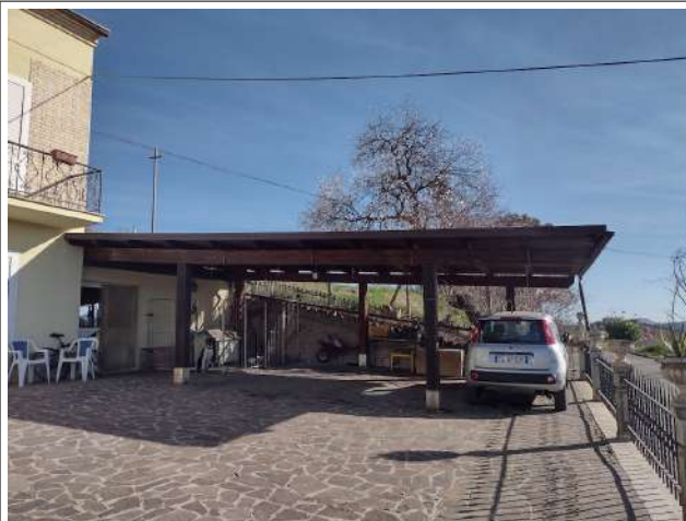
Vista tettoia esterna autorizzata a pergola area condominiale
