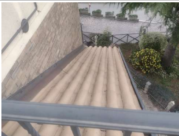
Copertura scala vista dal balconcino soffitta
