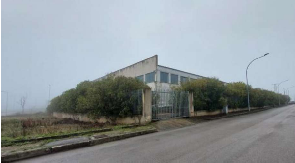
Cancello nord est – vista esterna
