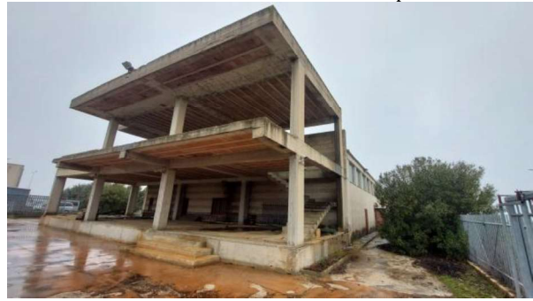
Vista fabbricato in costruzione adiacente a parete ovest
