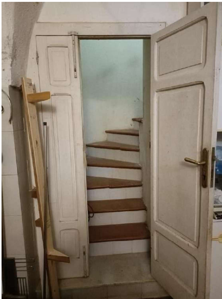
Figura 5 – Scala interna accesso Piano Primo
