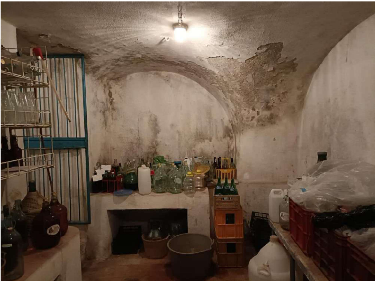
Figura 8 – Cantina Piano Seminterrato.
