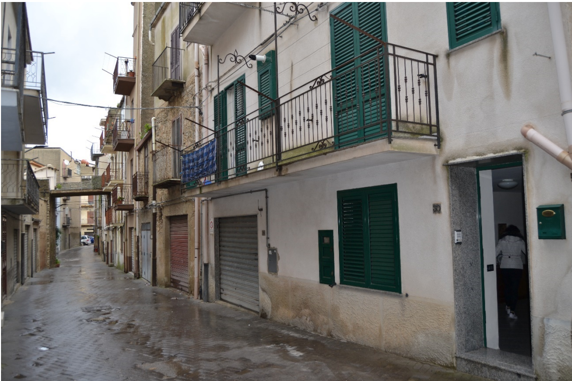
Fotografia 4 – Prospetto via Mulino nn. 28-30
