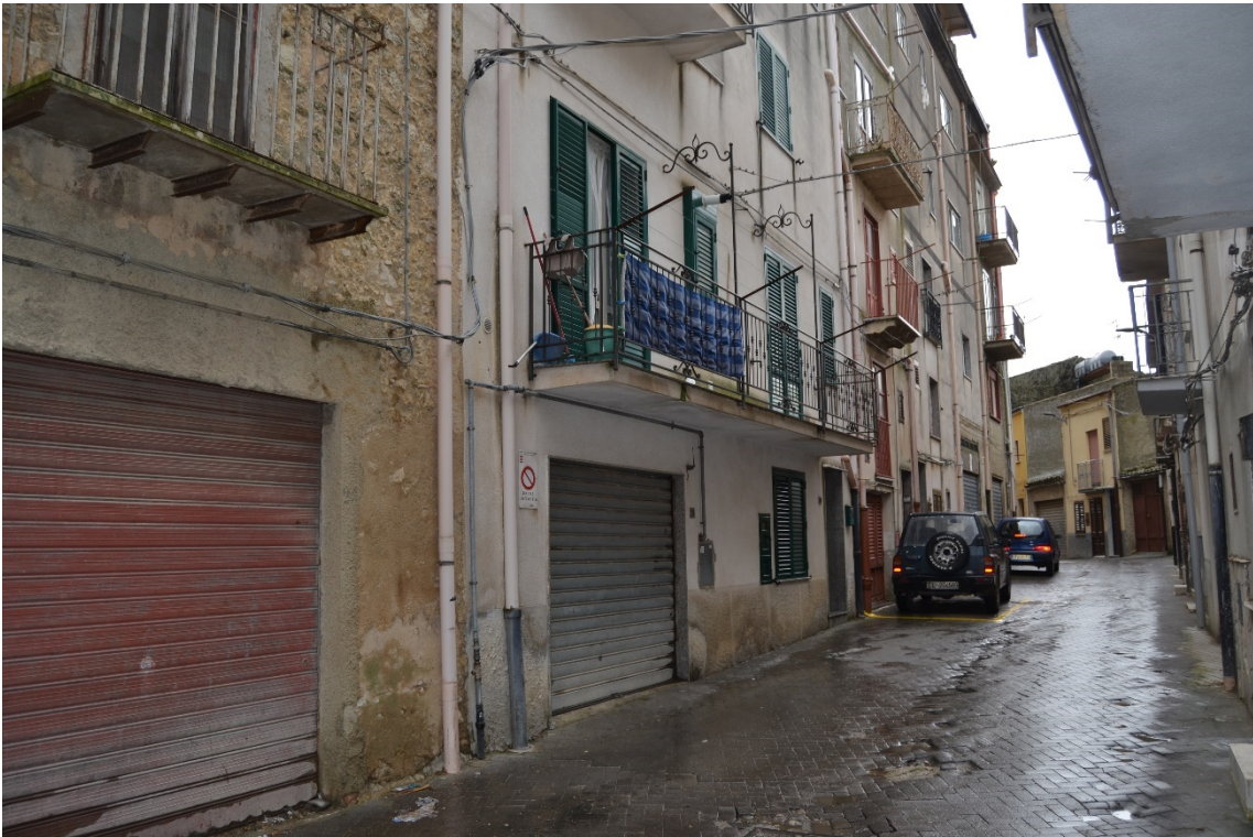
Fotografia 3 – Prospetto via Mulino nn. 28-30
