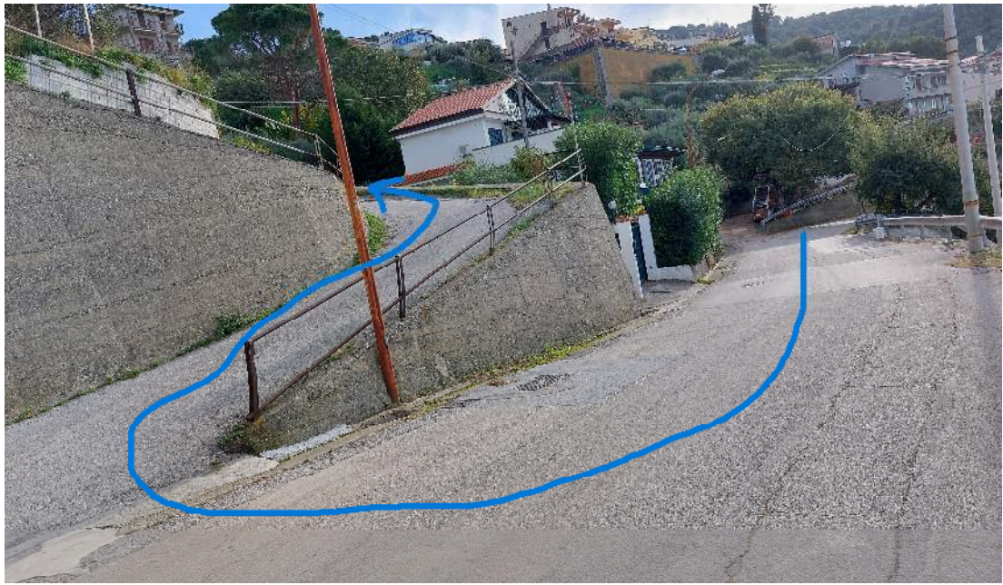
Particolare strada di accesso - da valle verso monte
