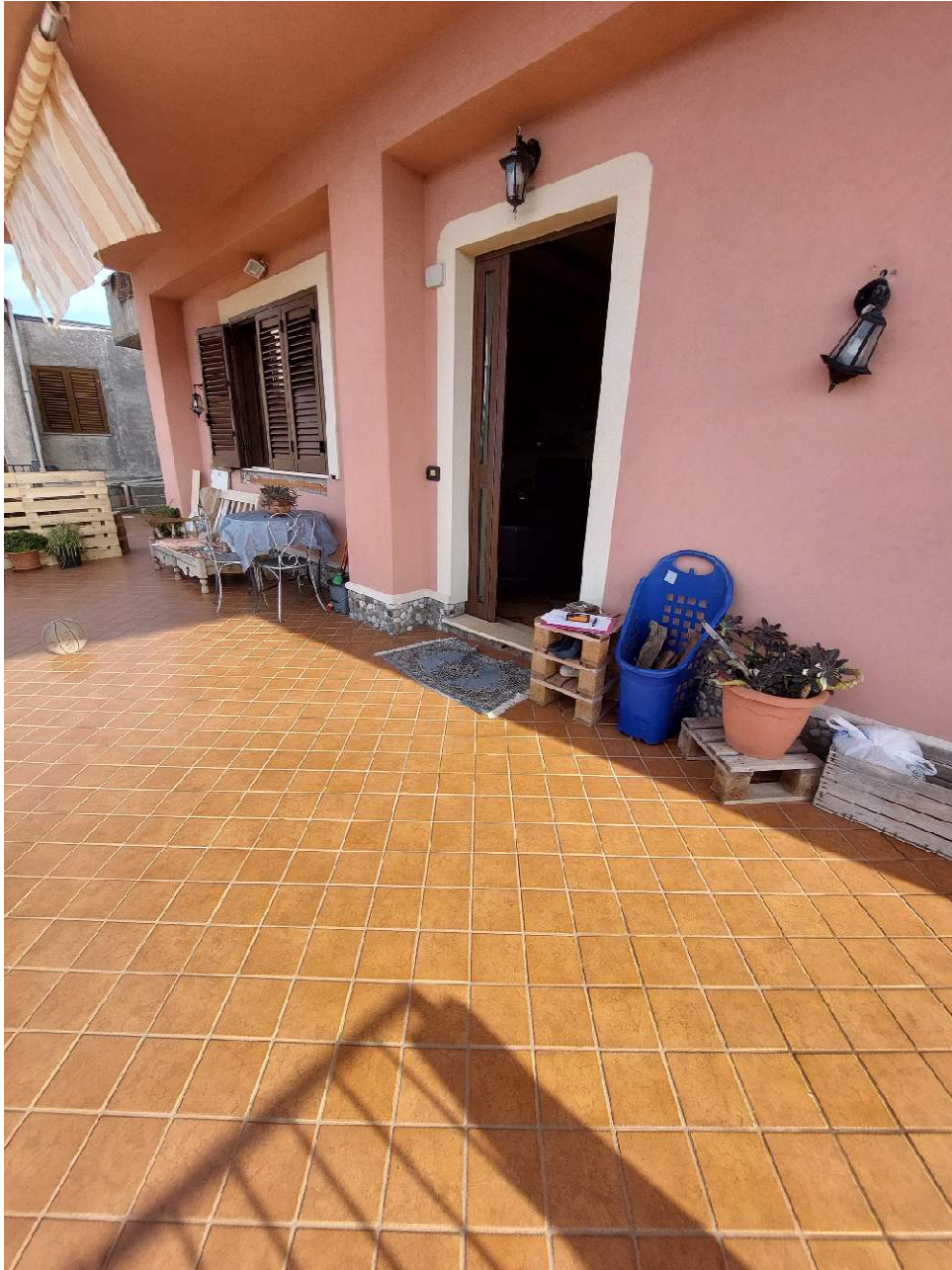
Prospetto principale - entrata
