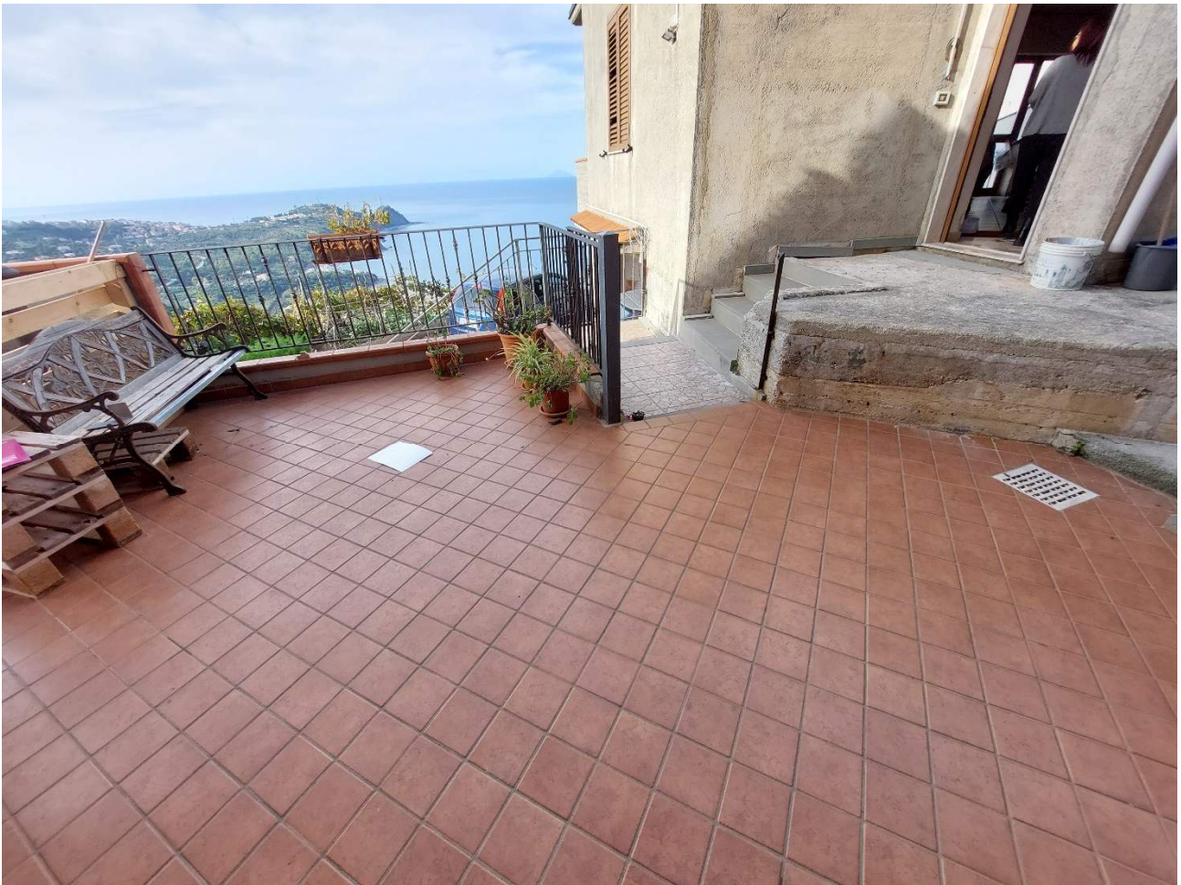
Cortile - particolare a)
