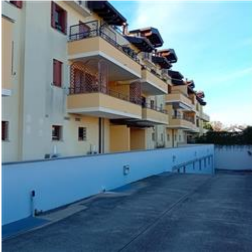
Rampa di accesso
