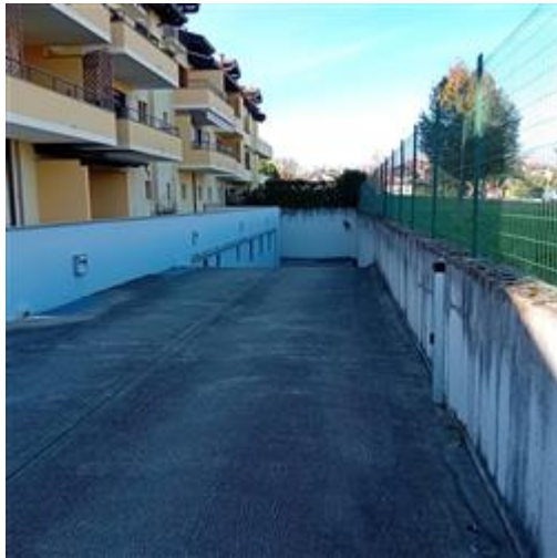
Rampa di accesso
