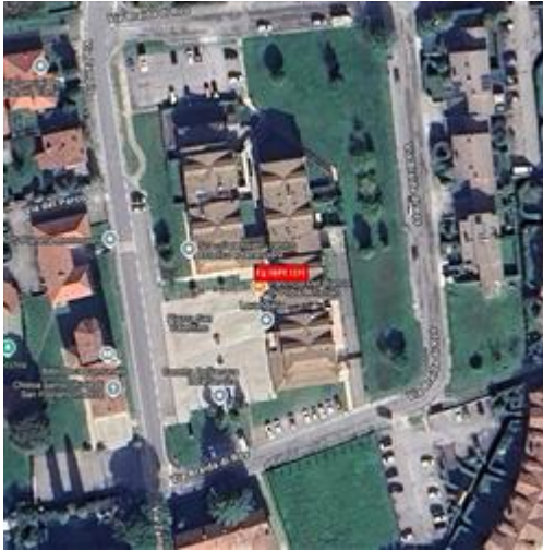
Vista aerea di dettaglio
