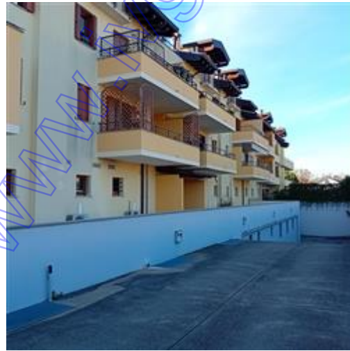
Prospetto retro con rampa di accesso al piano sotterraneo
