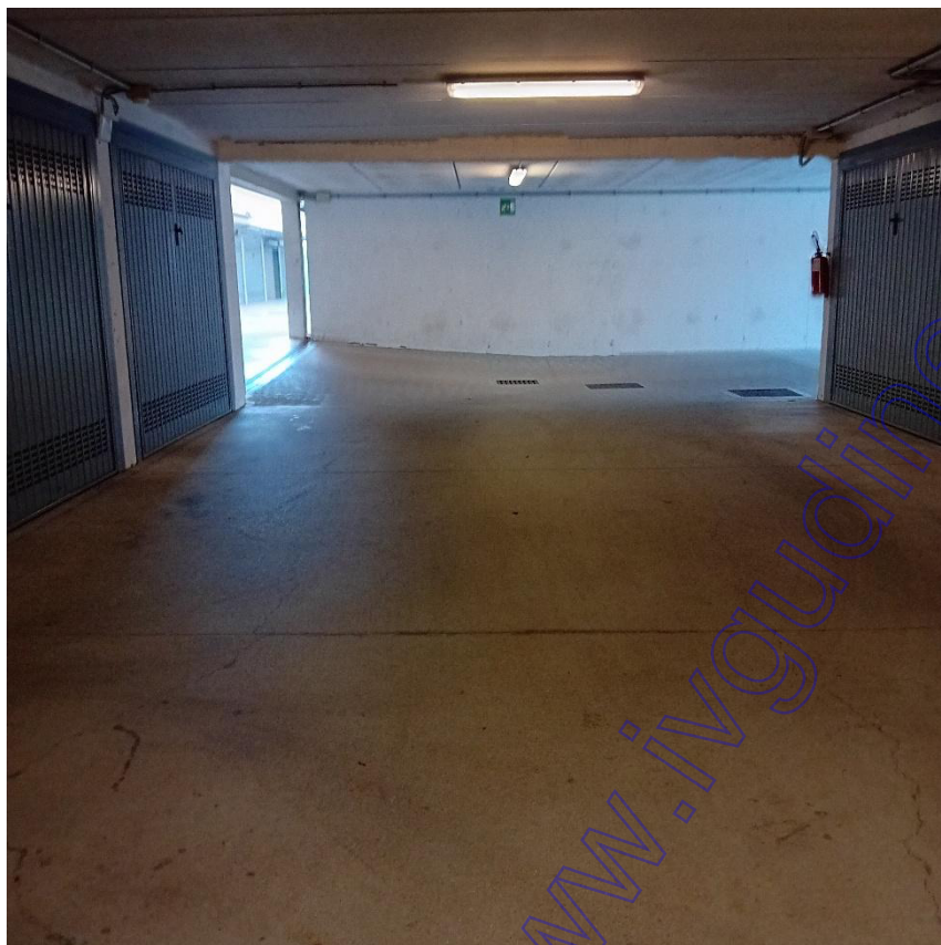
VISTE INTERNI PARTI COMUNI PIANO INTERRATO E GARAGE SUB 23
