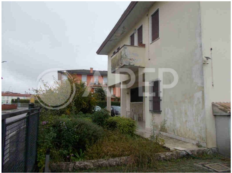
Foto 4- Vista lato ovest
