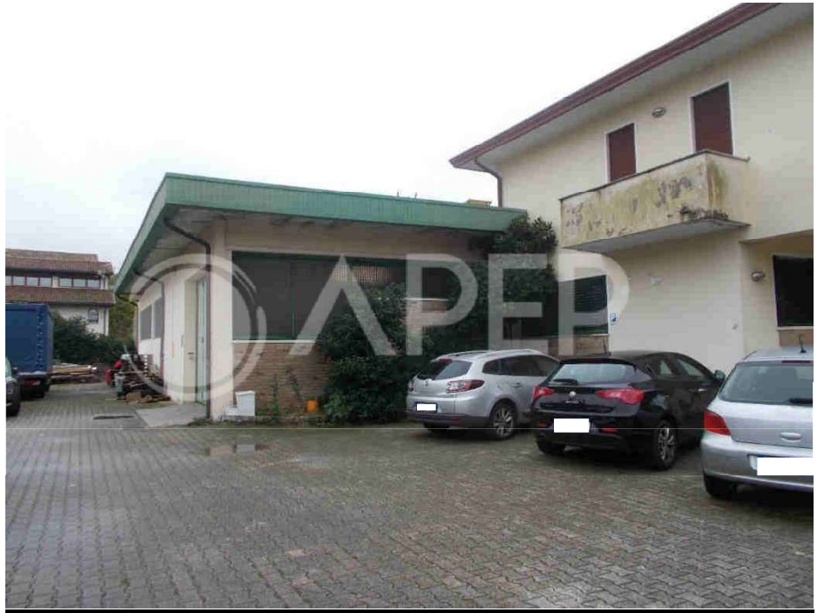
Foto 3- Vista da nord ovest- Fronte nord
