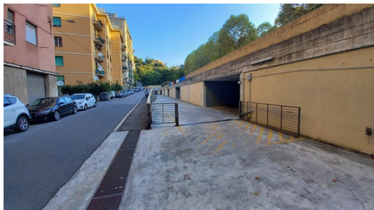
Accesso al 1° livello autorimessa ( quota +11,00)
