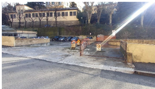
Accesso al 2° livello autorimessa ( quota +14,00)
