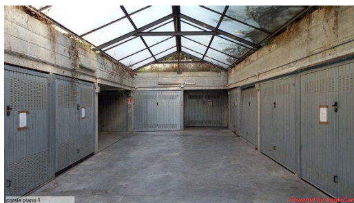
Corsia di manovra interna 2° livello autorimessa ( quota +14,00)
