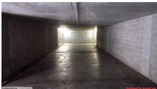
Corsia di manovra interna 1° livello autorimessa ( quota +11,00)
