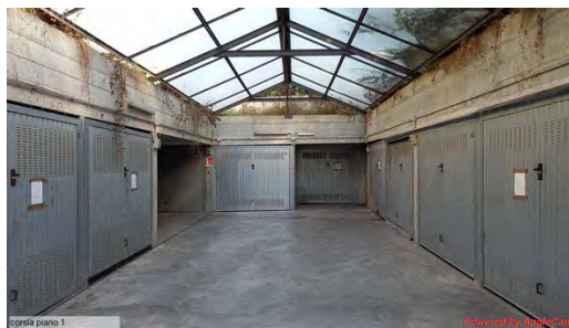
Corsia di manovra interna 2° livello autorimessa ( quota +14,00)
