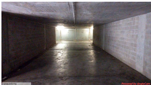
Corsia di manovra interna 1° livello autorimessa ( quota +11,00)
