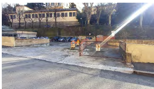
Accesso al 2° livello autorimessa ( quota +14,00)
