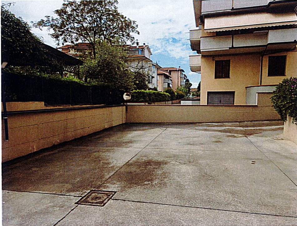
Arrivo della rampa di accesso al resede comune
