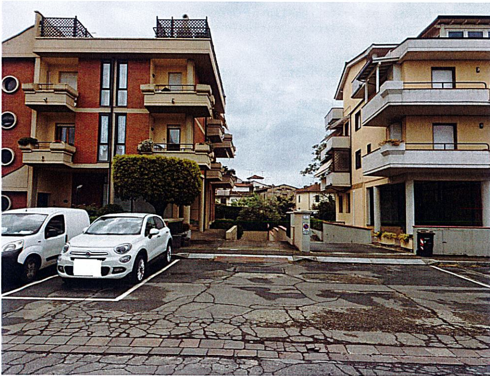
Ingresso della rampa di accesso al resede comune
