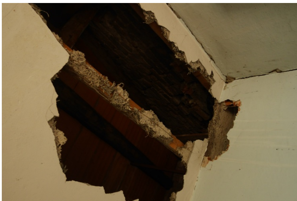
FOTO 13 - Piano primo. La struttura della copertura.
