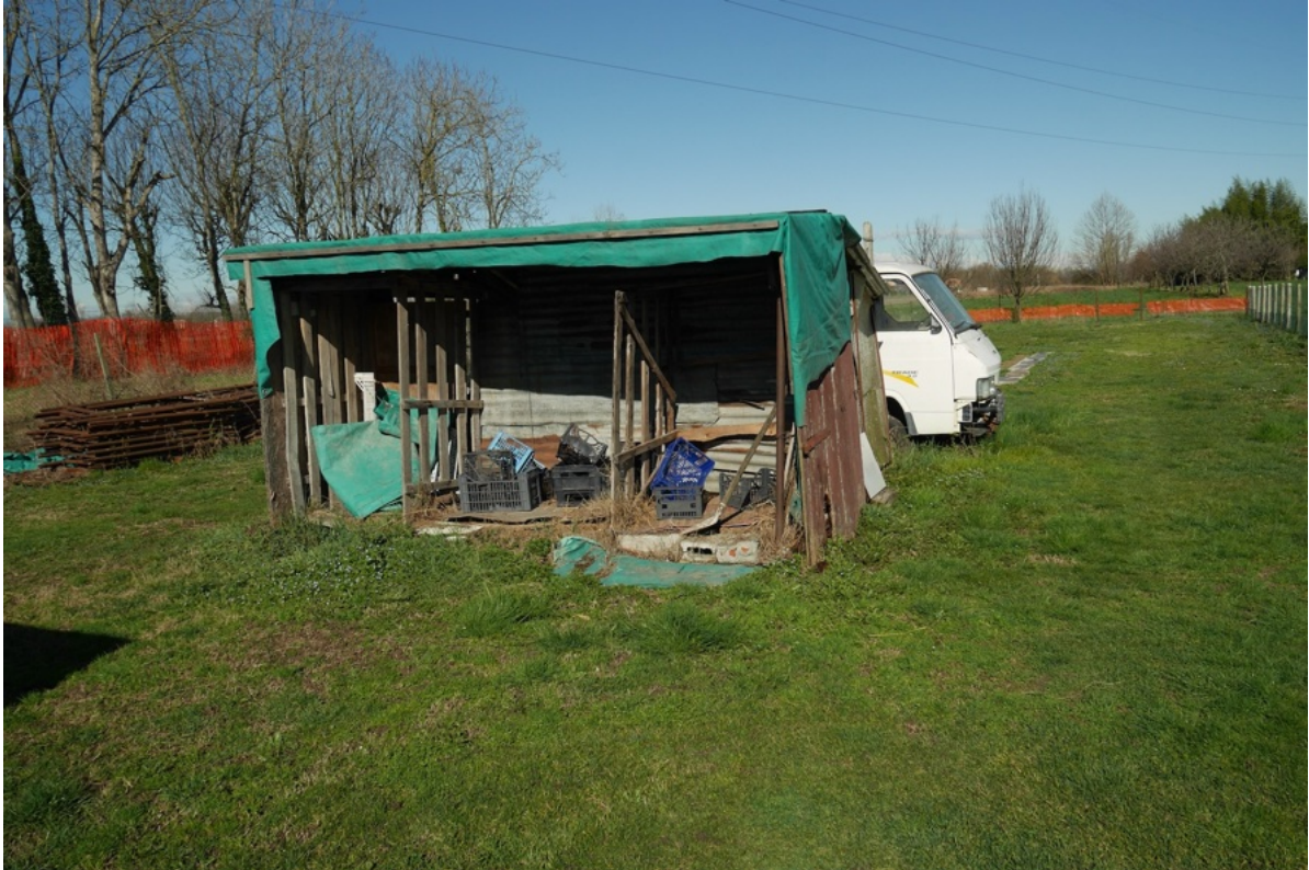
FOTO 4 - Altro manufatto. Si notano i cavi dell'elettrodotto.
