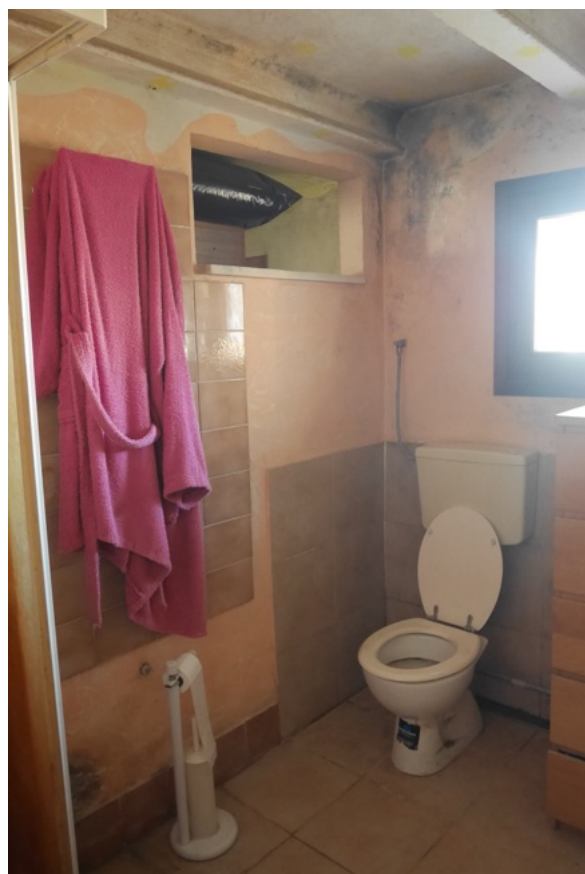
FOTO 8 - Piano terra. Il bagno.
