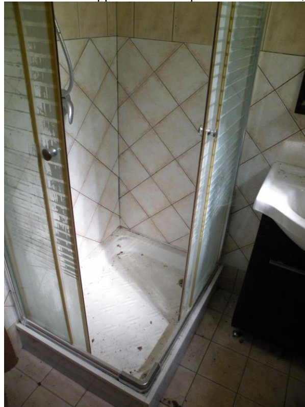
FOTO N°13: Vista dell'appartamento al piano seminterrato, bagno/2.
