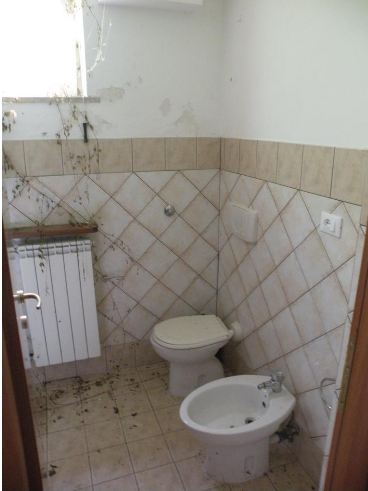
FOTO N°12: Vista dell'appartamento al piano seminterrato, bagno/1.
