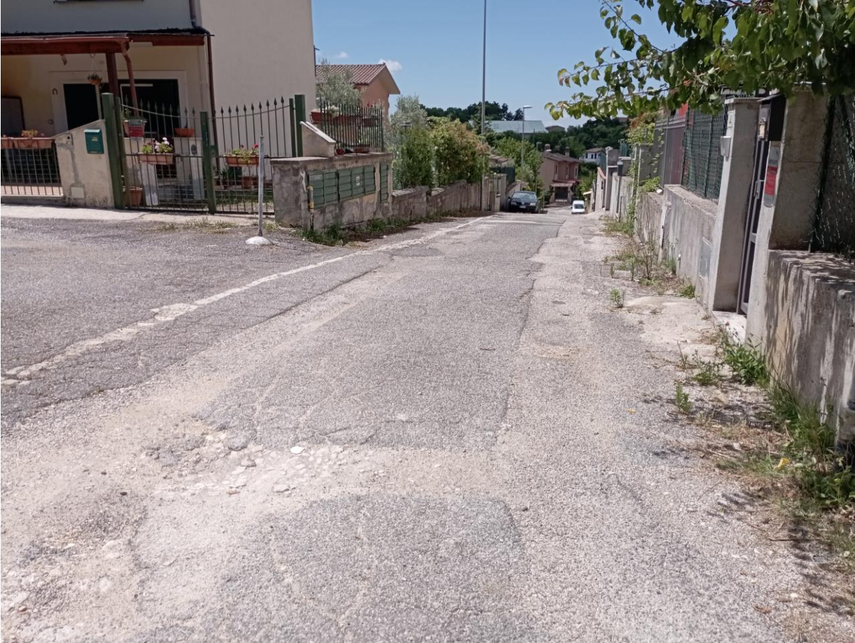
FOTO N°1: Vista della strada di accesso all'immobile.
