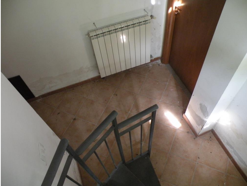
FOTO N°9: Vista dell'appartamento al piano seminterrato, disimpegno/1.
