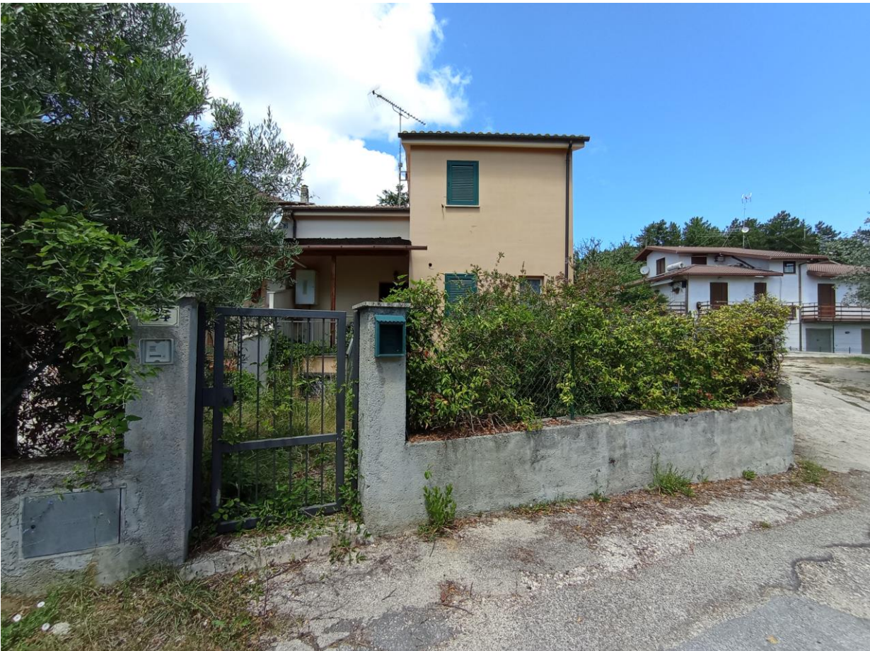
FOTO N°2: Vista della strada di accesso all'immobile/2.
