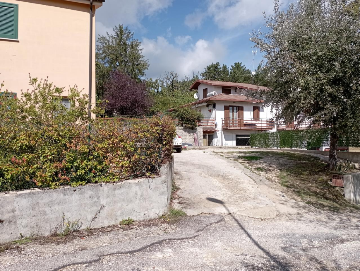
FOTO N°3: Parte corte esclusiva adibita a parcheggio/1.
