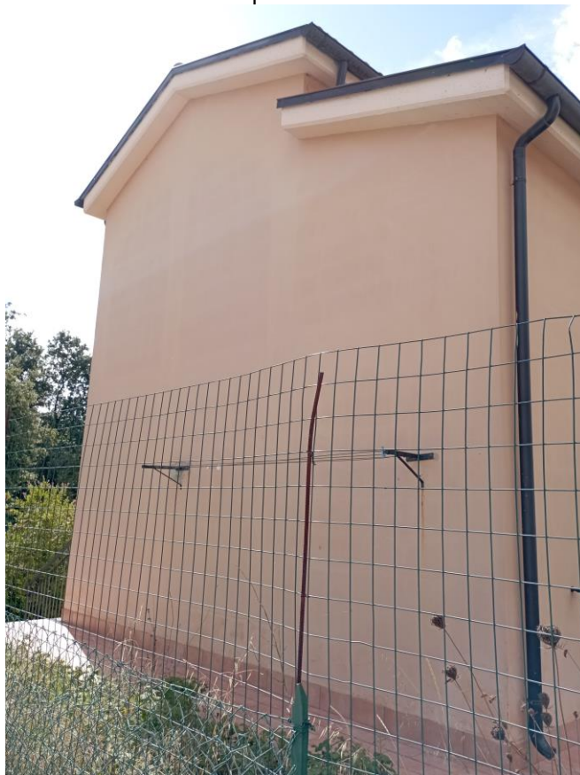
FOTO N°6: Prospetto Nord del fabbricato.
