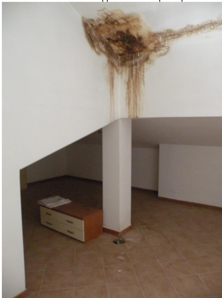
FOTO N°29: Vista dell'appartamento al piano primo /3.
