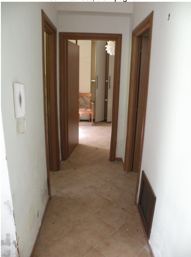
FOTO N°10: Vista dell'appartamento al piano seminterrato, disimpegno/2.
