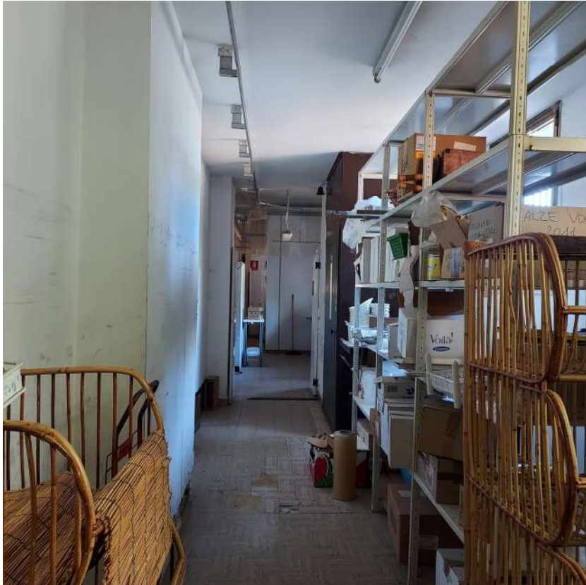
40. Foto Piano Terra
