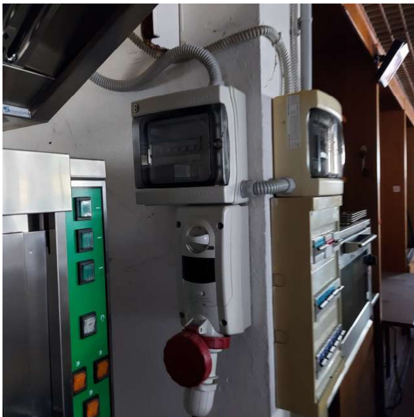
48. Foto Piano Terra
