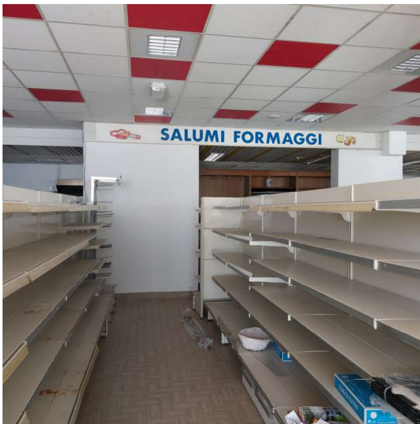
36. Foto Piano Terra
