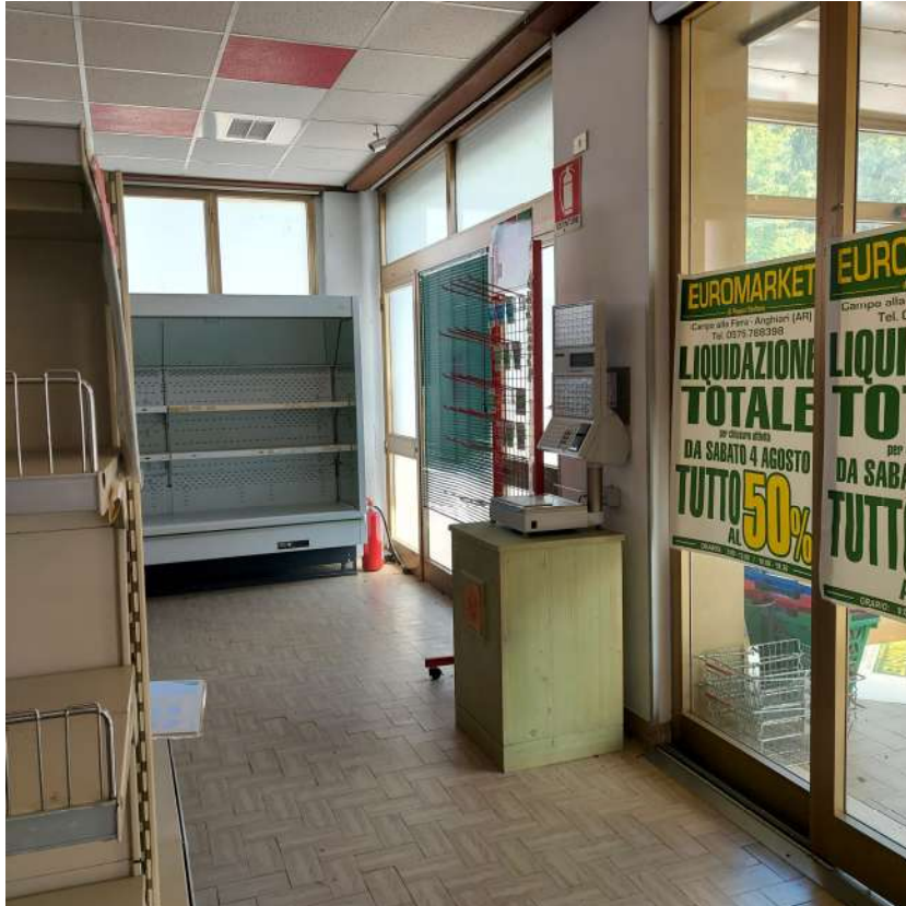
38. Foto Piano Terra
