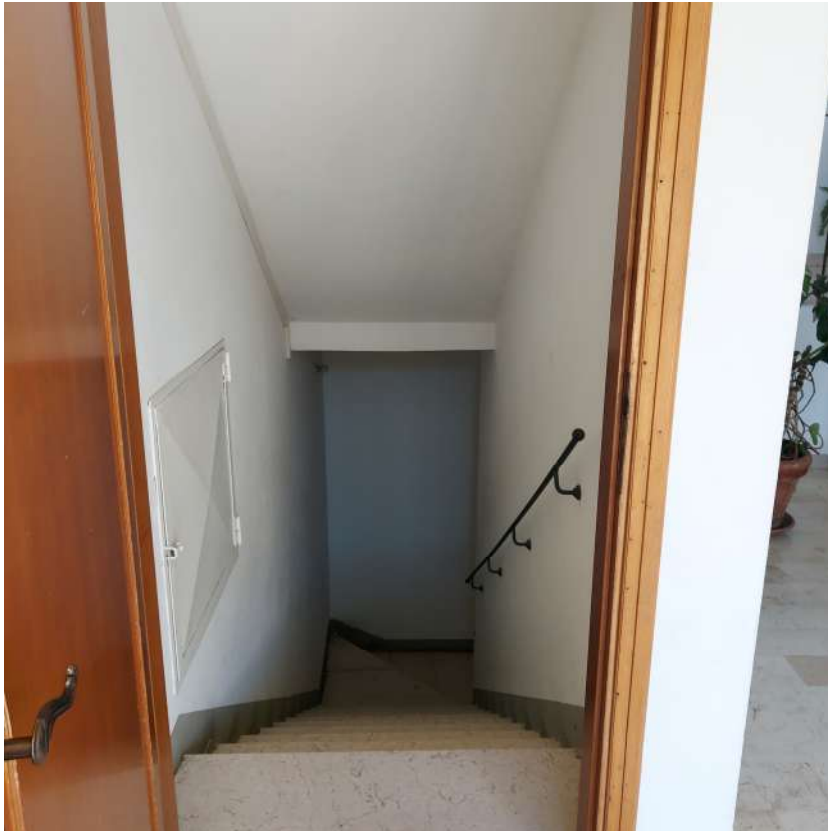
52. Foto Vano Scala Condominiale
