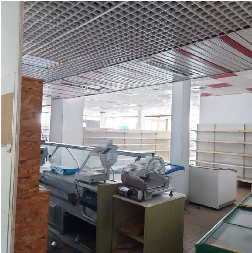
45. Foto Piano Terra
