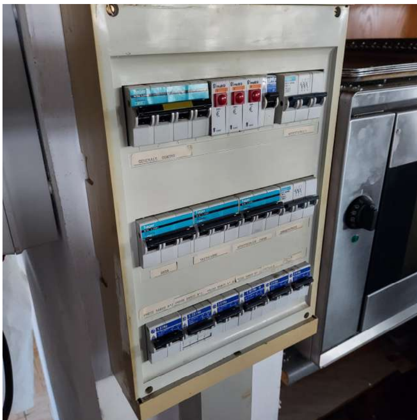
47. Foto Piano Terra
