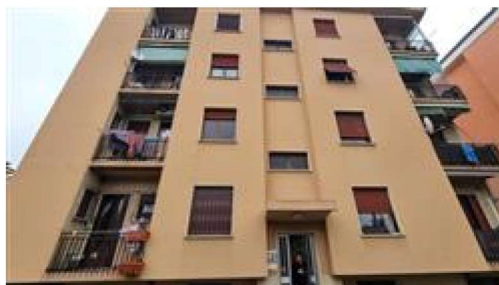
prospetto principale con ingresso condominiale
