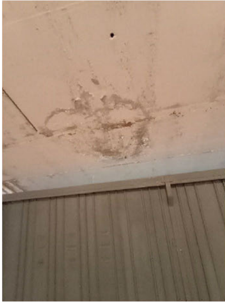
Immagini 13 - Interno del box oggetto di perizia - Particolare delle macchie di umidità a soffitto (ingresso) - Fonte: Sopralluogo in loco Immagini 14 - Particolare delle macchie di umidità a soffitto (fondo) e piccole fessurazioni a parete - Fonte: Sopralluogo in loco
