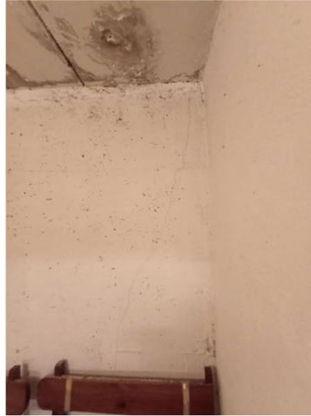
Immagini 13 - Interno del box oggetto di perizia - Particolare delle macchie di umidità a soffitto (ingresso) - Fonte: Sopralluogo in loco Immagini 14 - Particolare delle macchie di umidità a soffitto (fondo) e piccole fessurazioni a parete - Fonte: Sopralluogo in loco
