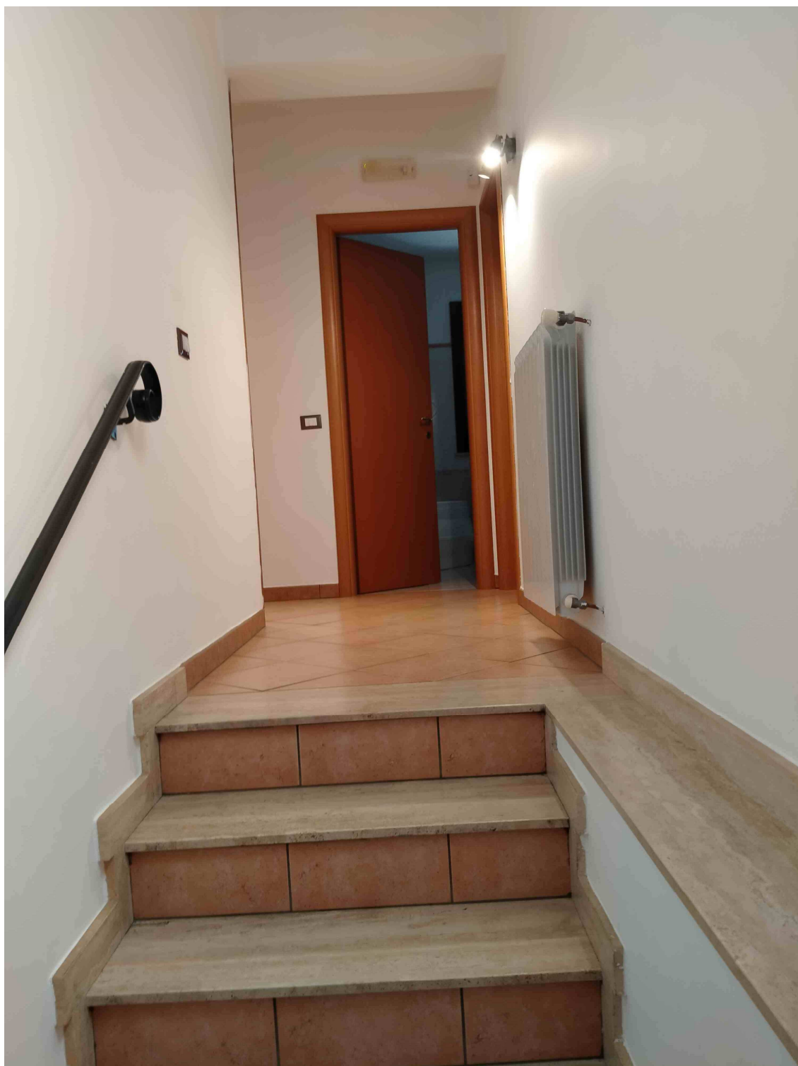
Foto n.12 – Rampa scale accesso primo piano.
