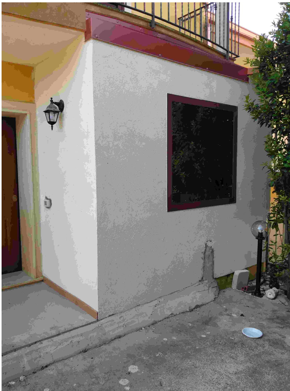
Foto n. 19 – Esterno locale cucinino adiacente alla porta di ingresso A.
