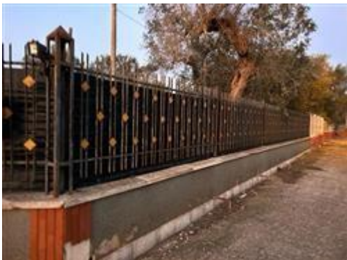
recinzione su SP
