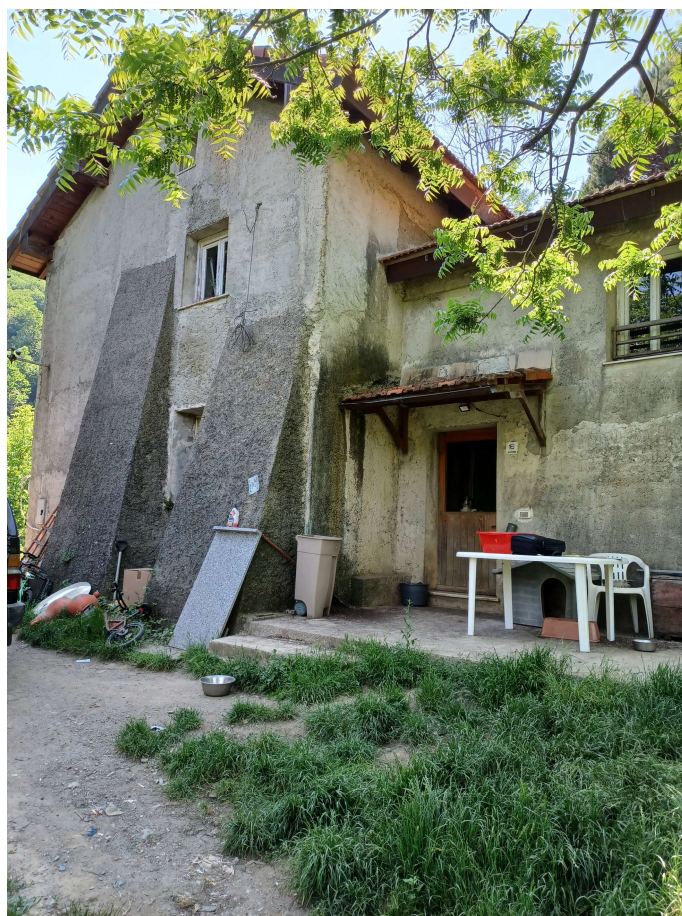
FOTOGRAMMA n.° 2: PROSPETTO EST – ingresso principale
