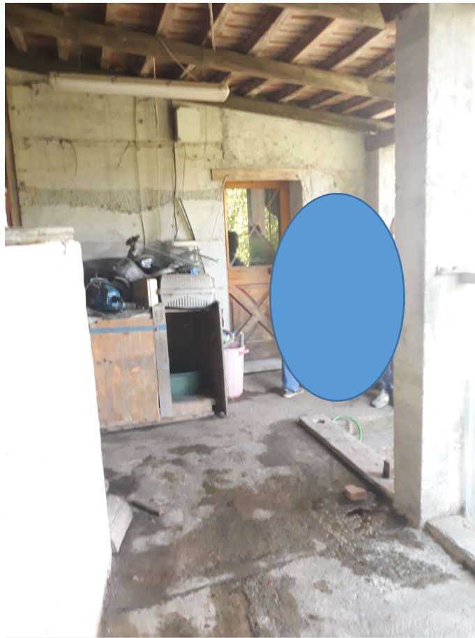
FOTOGRAMMA n.° 7: PROSPETTO SUD – ingresso secondario
