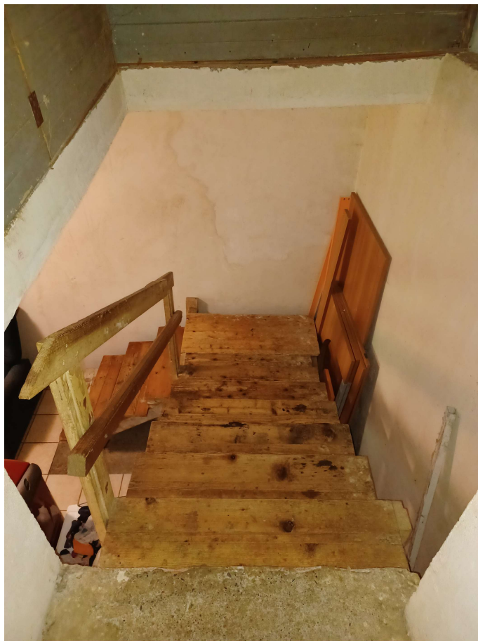
FOTOGRAMMA n.° 15: PIANO PRIMO - scala di collegamento tra piano terra e primo
