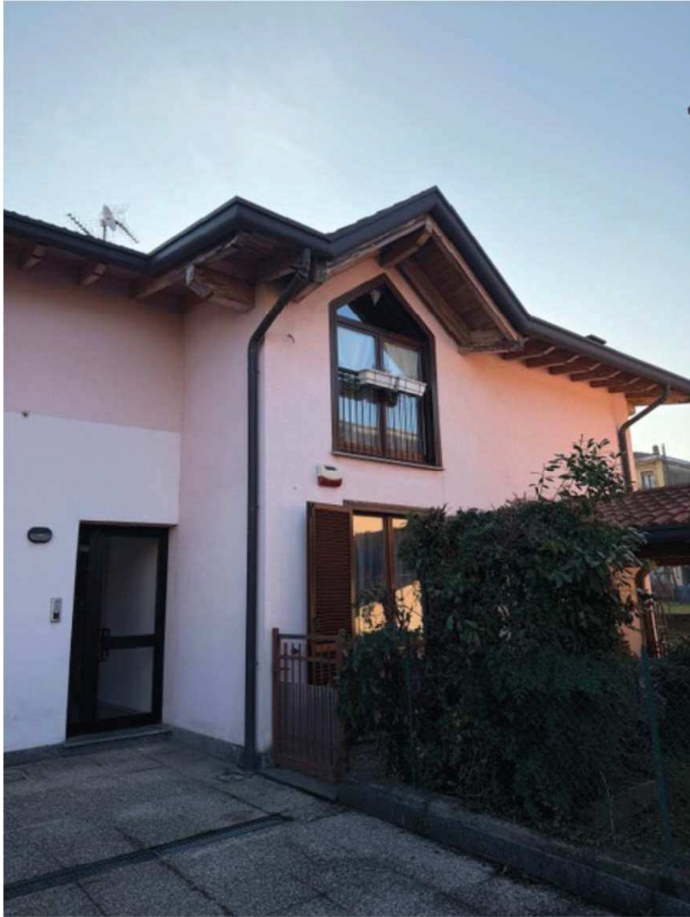
Ingresso comune e vista del prospetto Nord
