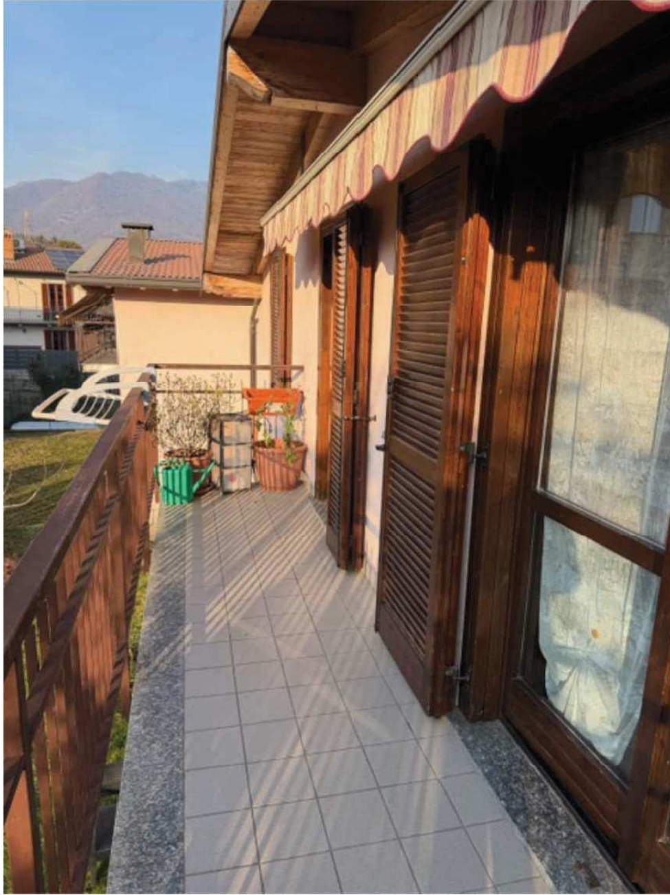
Balcone prospetto Ovest
