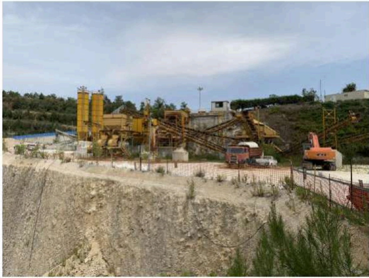
Vecchio impianto di frantumazione
