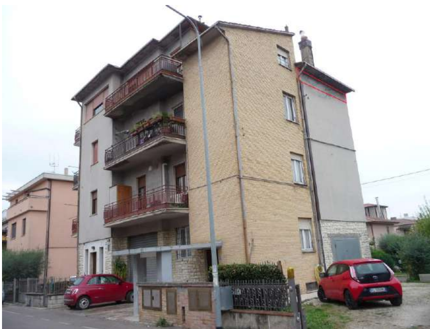
Foto n. 3 Edificio - fronte strada e fianco nord (in rosso l'ubicazione dell'appartamento pignorato)
