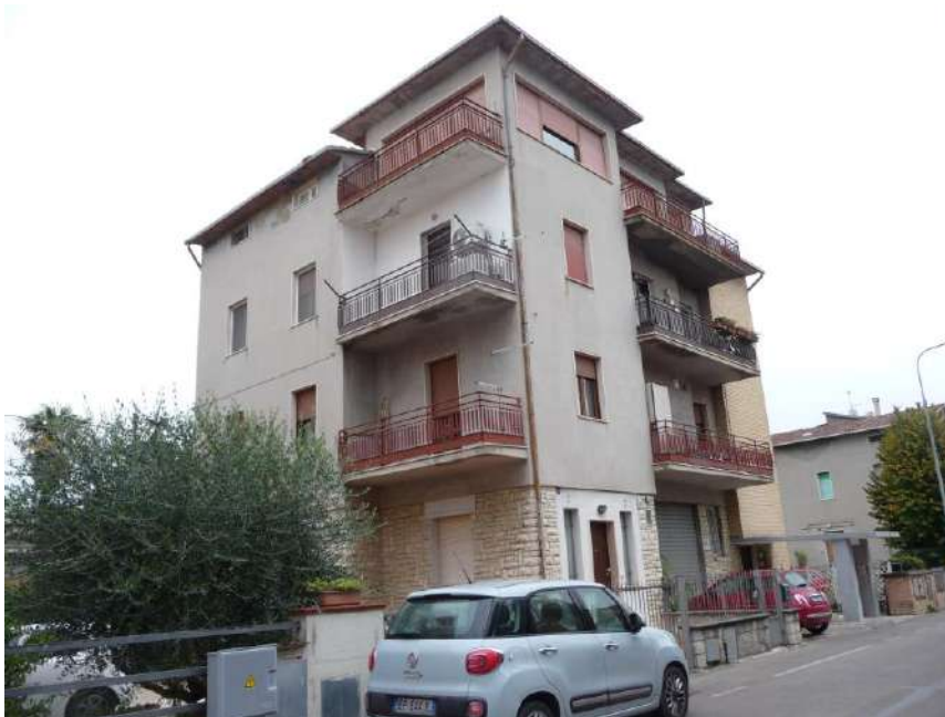
Foto n. 2 Edificio - fronte strada e fianco sud
