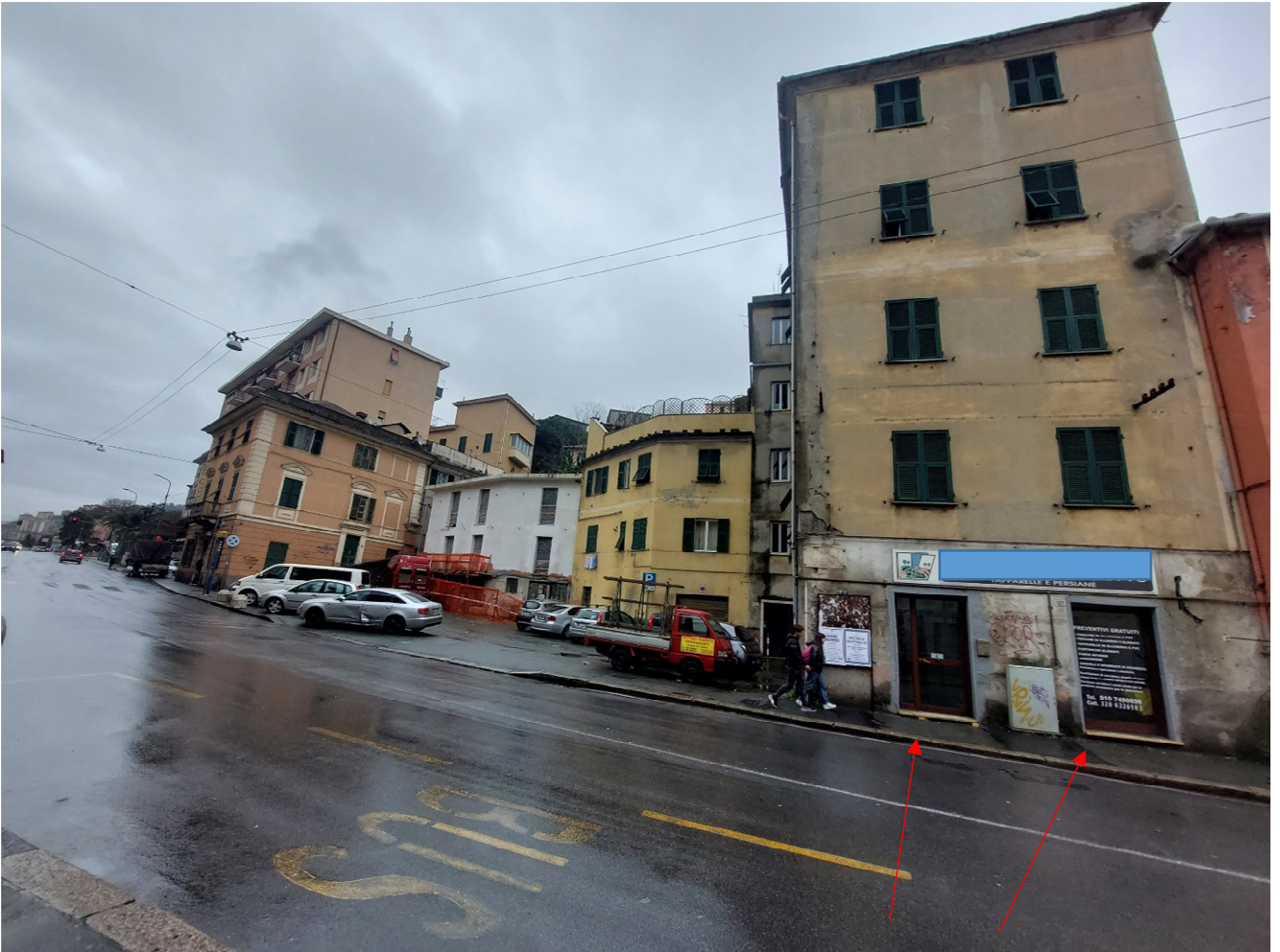
FOTO 3: vista del prospetto principale del civ. 67 e dei due ingressi al locale commerciale, civ. 107r e civ. 109r
