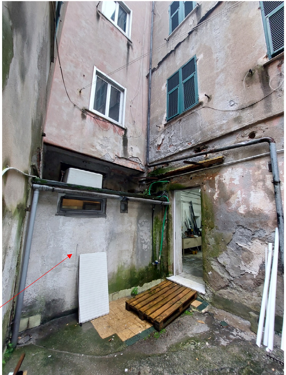
FOTO 21,22: cortile – vista sul volume realizzato a contenere il servizio igienico
