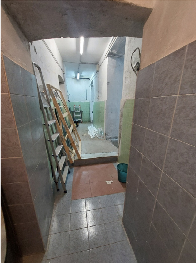
FOTO 26: corridoio disimpegno – vista dal servizio igienico verso i vani “cantina”
