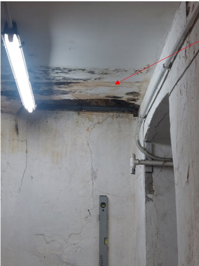
FOTO 27,28: corridoio disimpegno – in evidenza la zona ove sono in corso abbondanti perdite d’acqua
