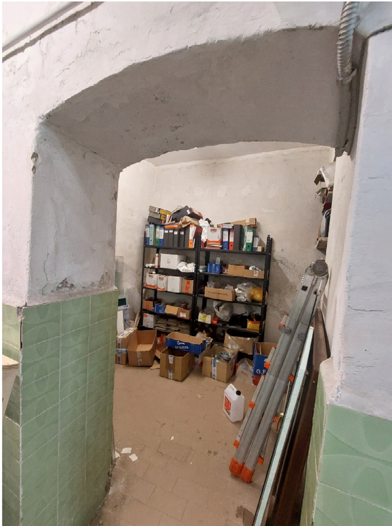
FOTO 29: vista verso il vano "cantina" di minori dimensioni
