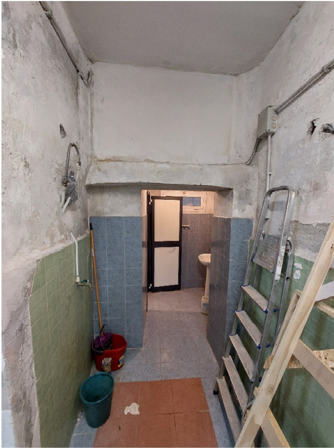
FOTO 23: corridoio disimpegno verso il servizio igienico
