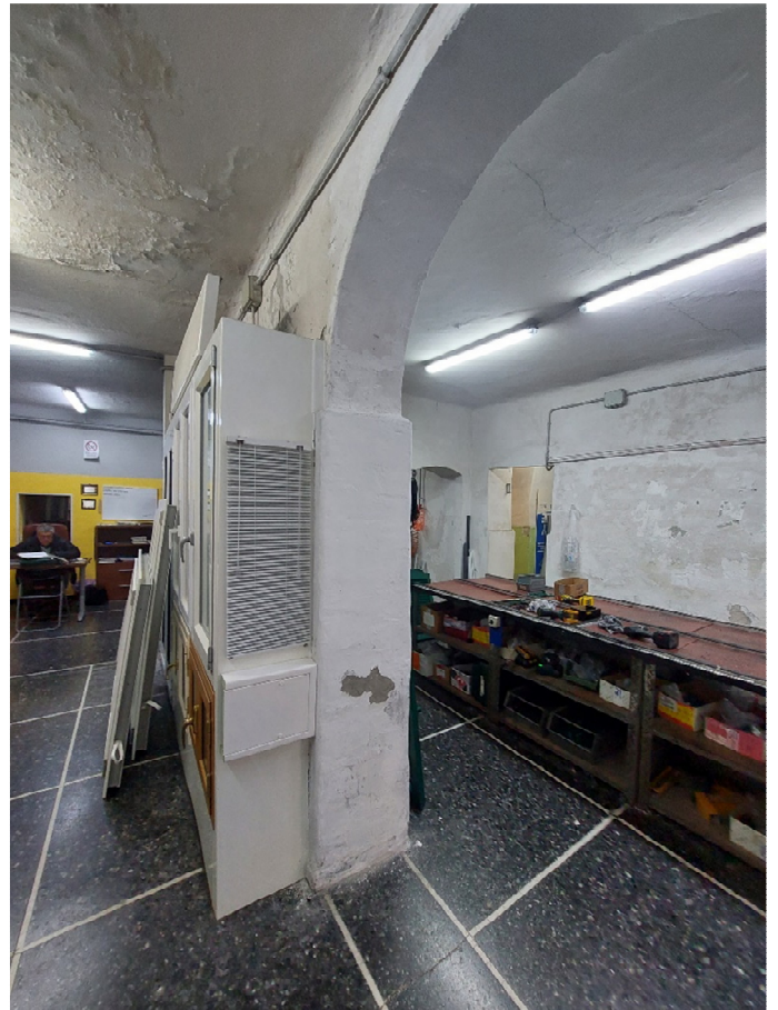
FOTO 12: vista del muro di spina che separa i due ambienti
