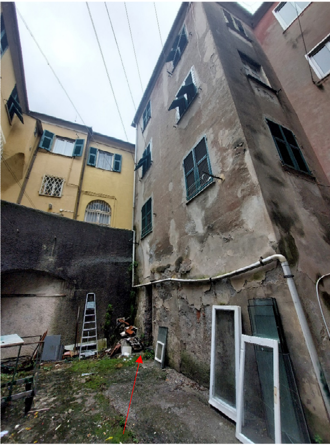
FOTO 31: cortile –ingresso al vano di sgombero
