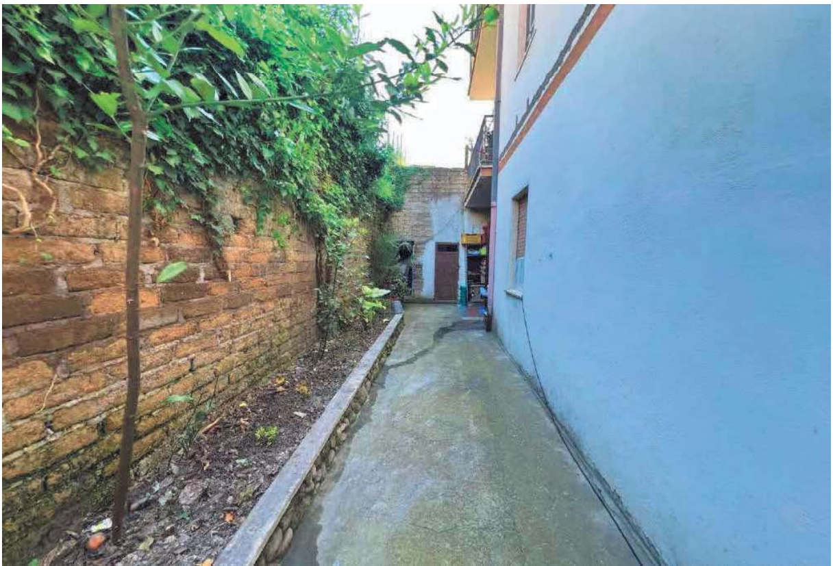
FOTO 12: Veduta corte comune ai sub. 1-3 lato nord (catastalmente sub. 5)
