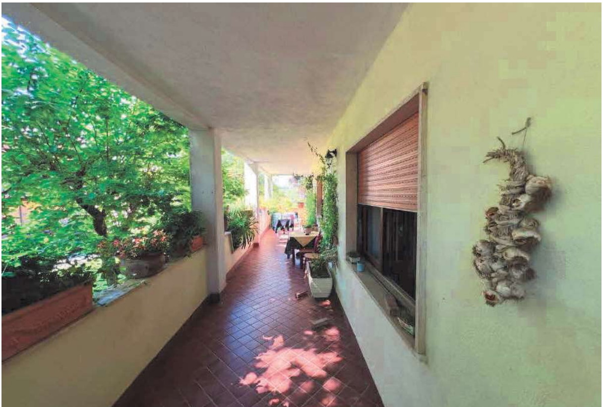
FOTO 10: Veduta porticato perimetrale lato sud
