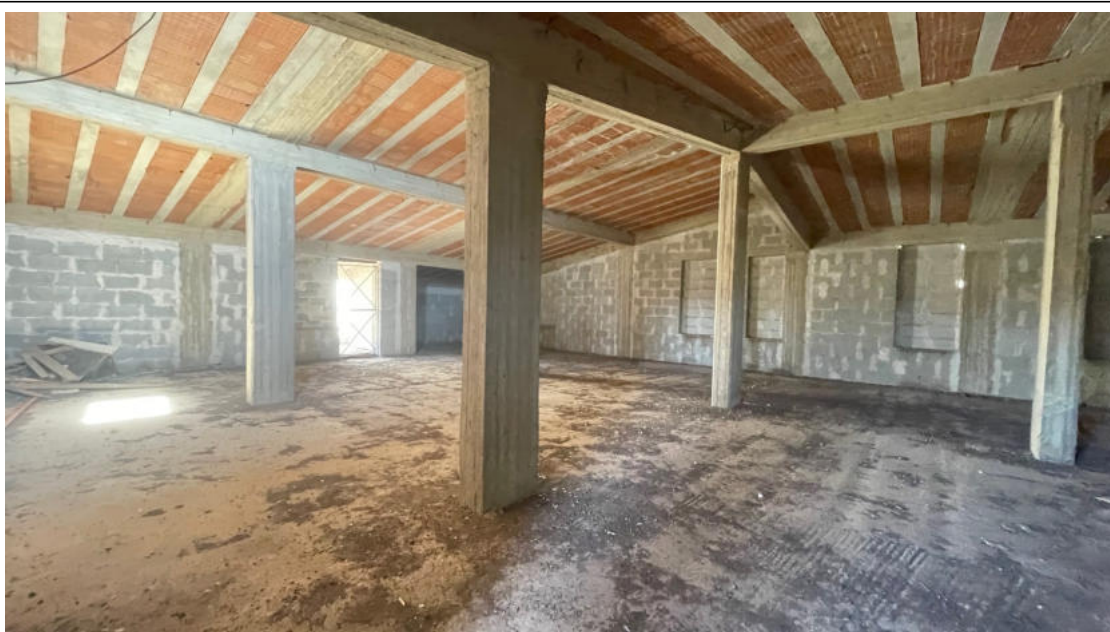
Foto 7. Vista del locale piano secondo.
