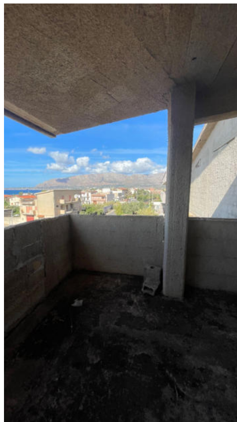
Vista del terrazzo di ingresso al piano 2
