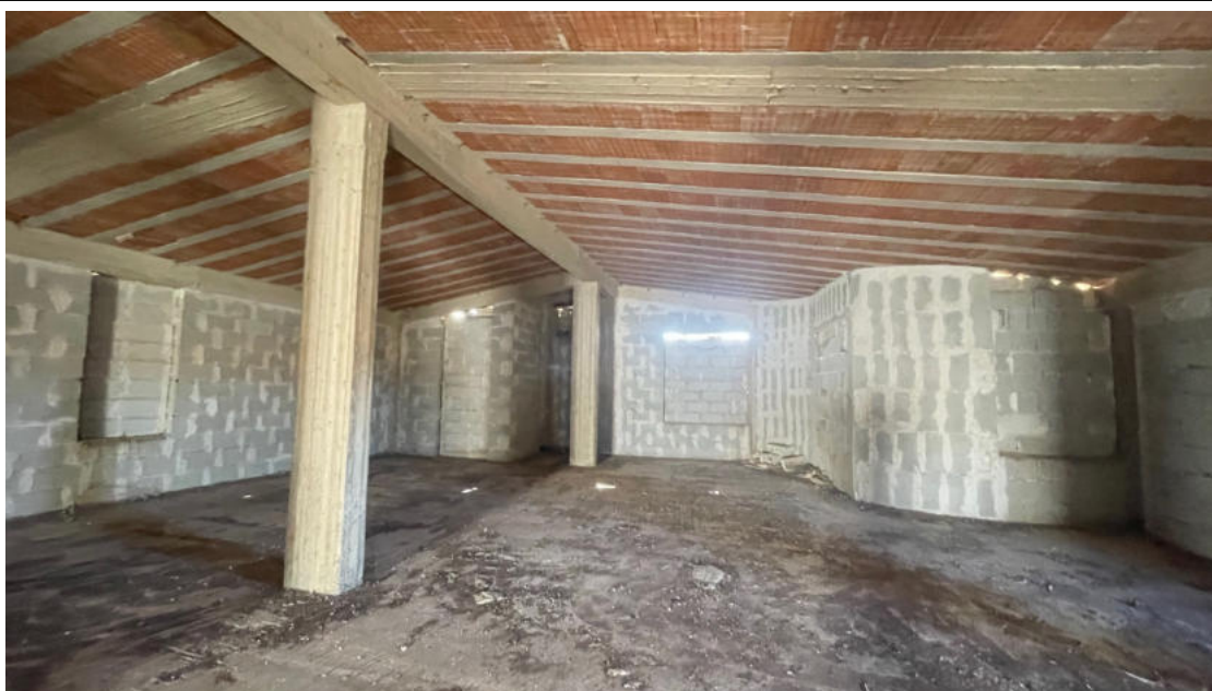
Foto 6. Vista del locale piano secondo.
