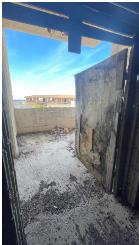
Foto 1-2. Vista dell'ingresso al piano 2.
