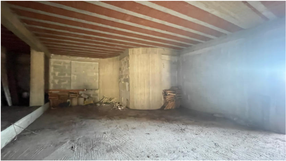
Foto 8. Vista del locale piano primo.
