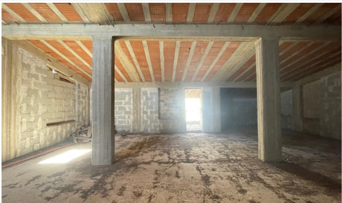
Foto 4. Vista del locale piano secondo.
