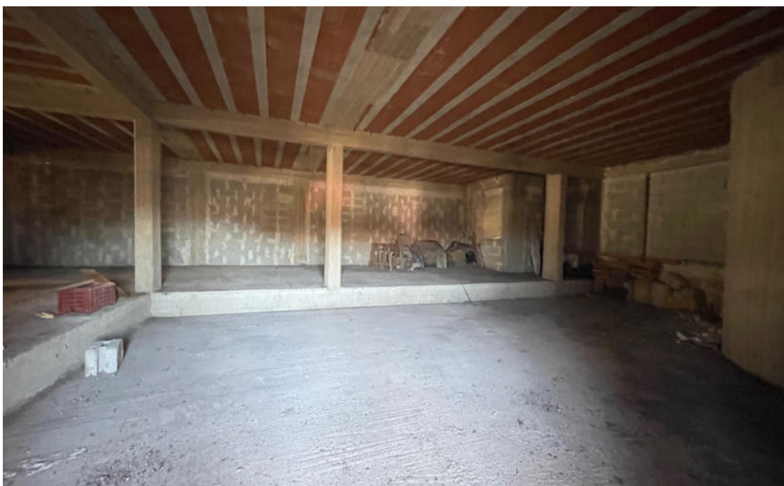
Foto 9. Vista del locale piano primo.
