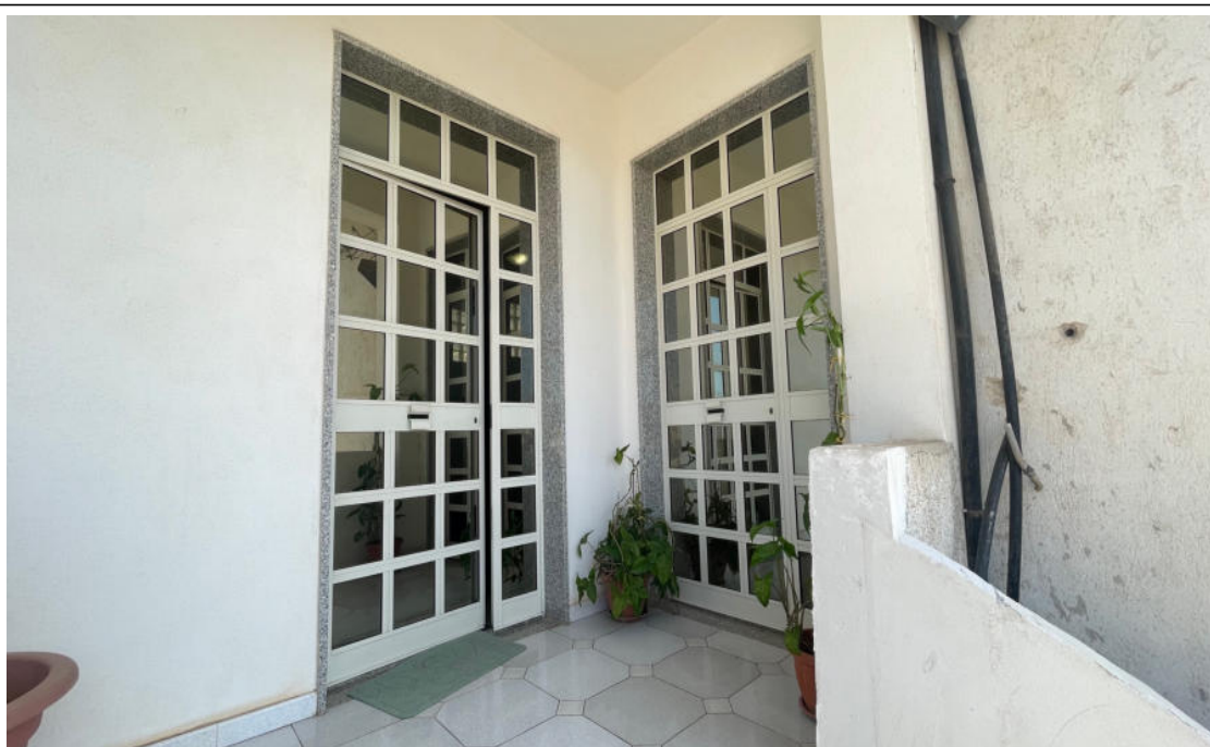
Foto 2. Vista ingressi principali a sinistra: piano rialzato, a destra ai piani 1 e 2.
