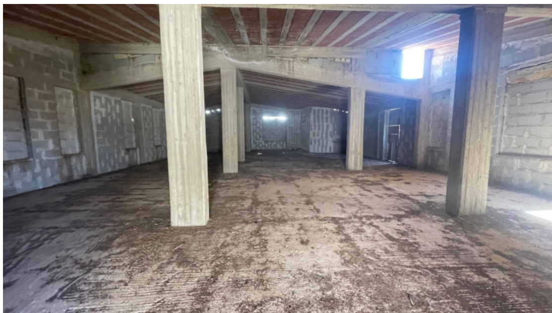
Foto 3. Vista del locale piano secondo.
