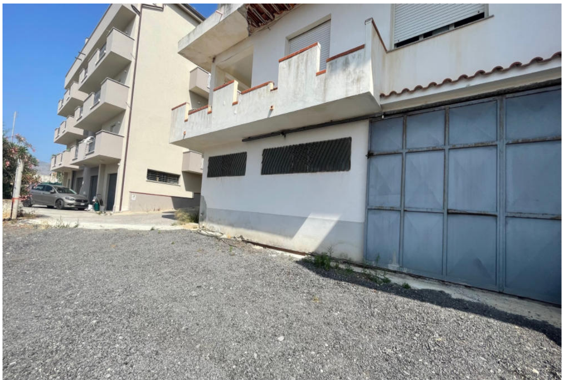
Vista del prospetto principale – accesso al piano seminterrato.
