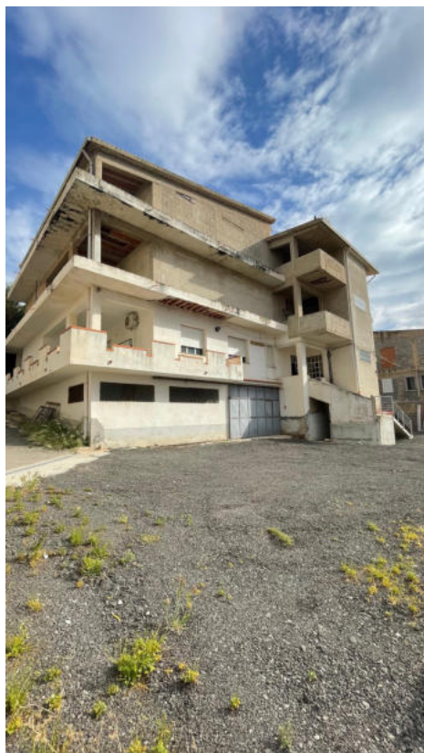
Vista dell'edificio, prospetto principale.
