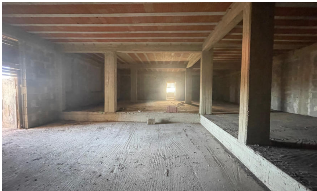
Foto 7. Vista del locale piano primo.
