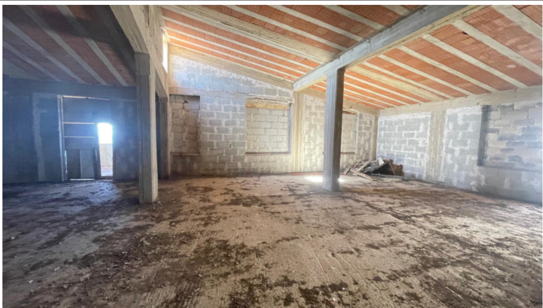
Foto 5. Vista del locale piano secondo.
