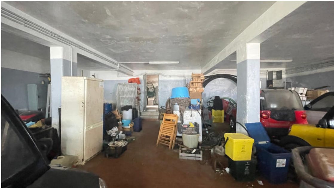
Foto 2. Vista del piano seminterrato
