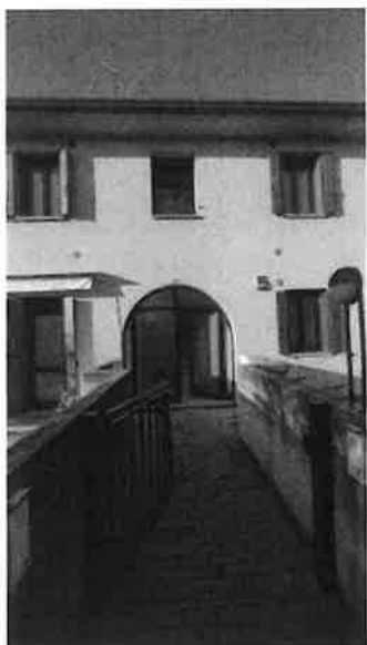
FOTO 1: vista prospetto sud
