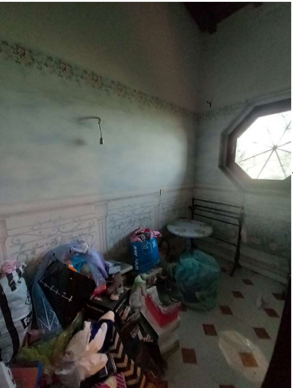
FOTO 66 : 1° piano : bagno con accesso da camera matrimoniale lato sud- ovest
