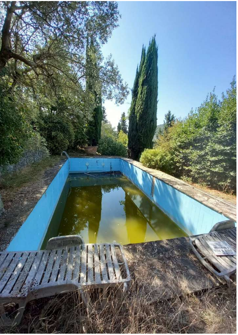
FOTO 19 ELIMINATA : FOTO 20 e 21 particolare ex cisterna/vasca di raccolta acqua trasformata piscina nella resede a comunel( opera oggetto di sanatoria ) ..
