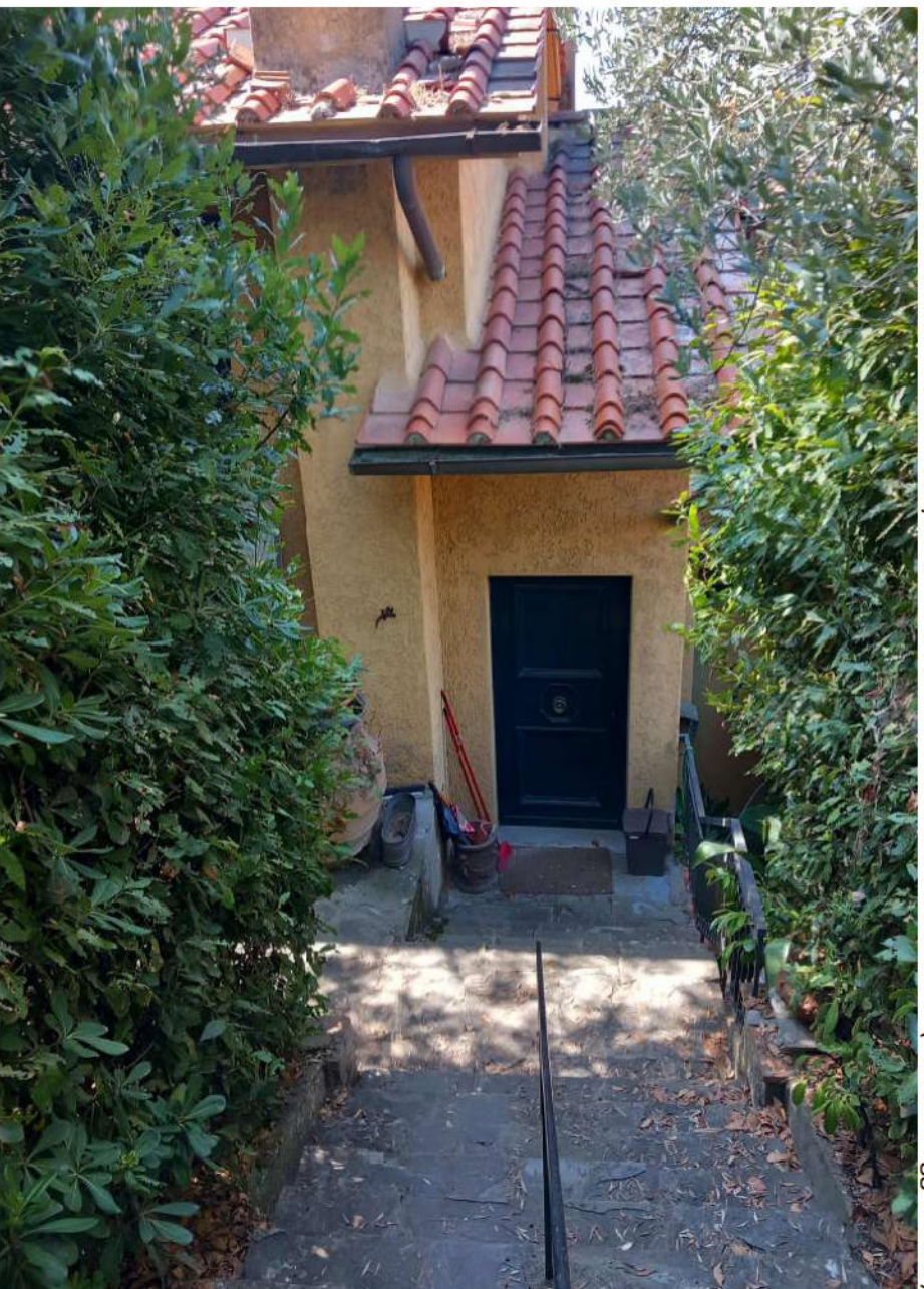
Ctu : Arch. Fabio Braccianti : R.G.E. n. 331/2023 – DOCUMENTAZIONE FOTOGRAFICA(versione aggiornata )
