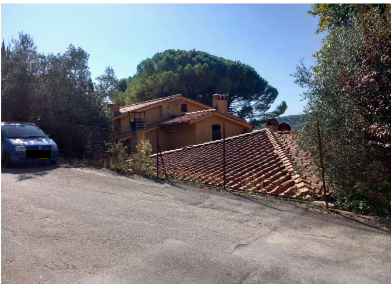
FOTO 2 : cancello 1° ingresso su via Fontibucci,10 ( accesso laterale appartamento lato studio/ingresso) - FOTO 3 : visione generale fronte sottostrada via Fontibucci
