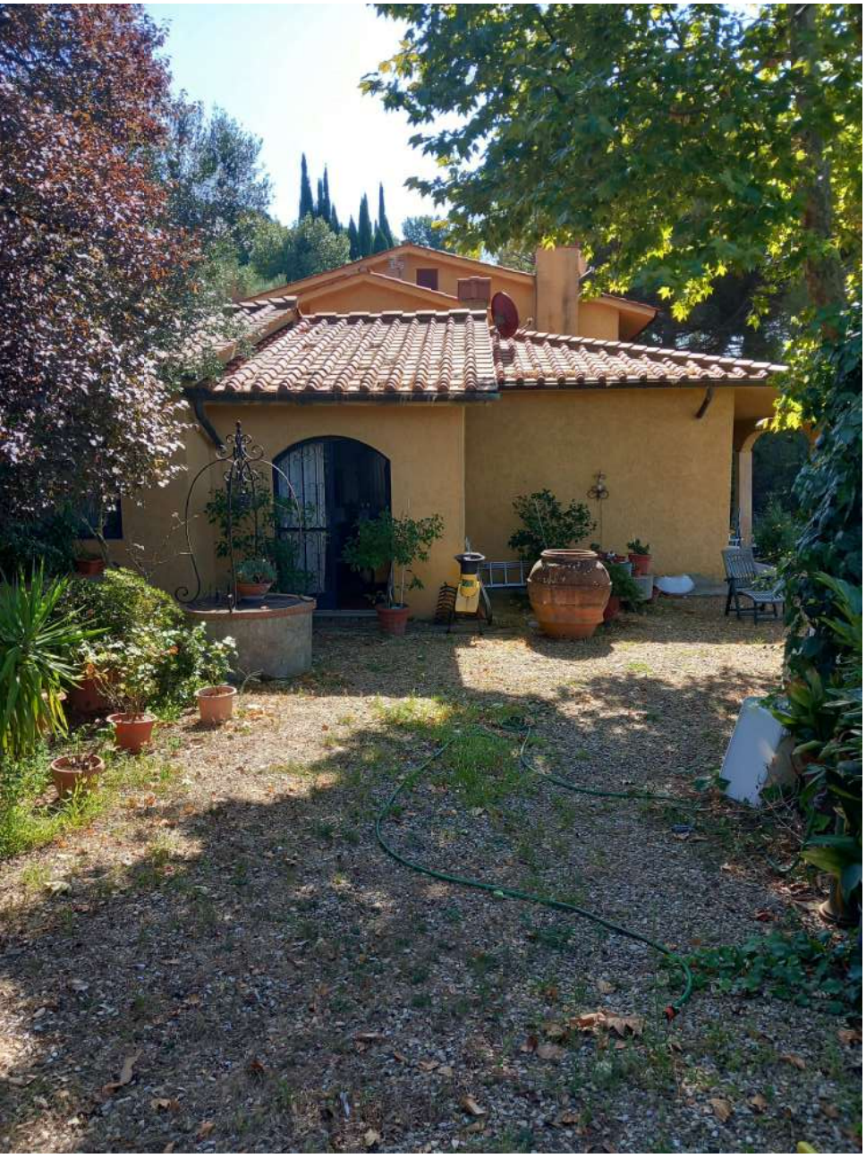
FOTO 10 : particolare resede tergale a giardino a comune
