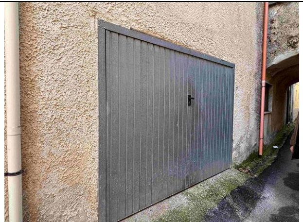
Vista esterna del box da via San Bartolomeo
