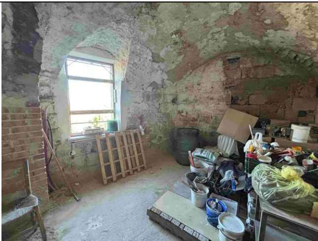
Piano terra – deposito 2
