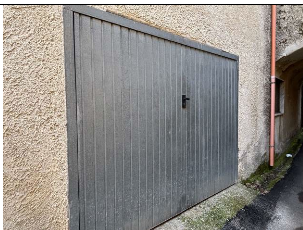
Vista esterna sub 9
