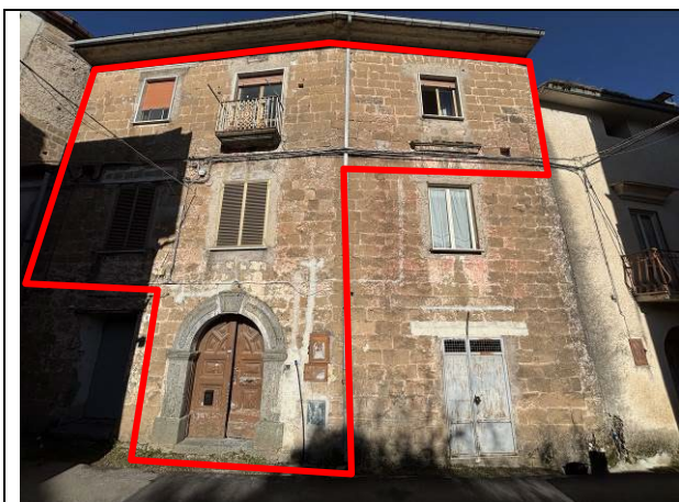
Vista esterna subb 16 e 17
