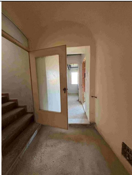
Piano Primo - Disimpegno
