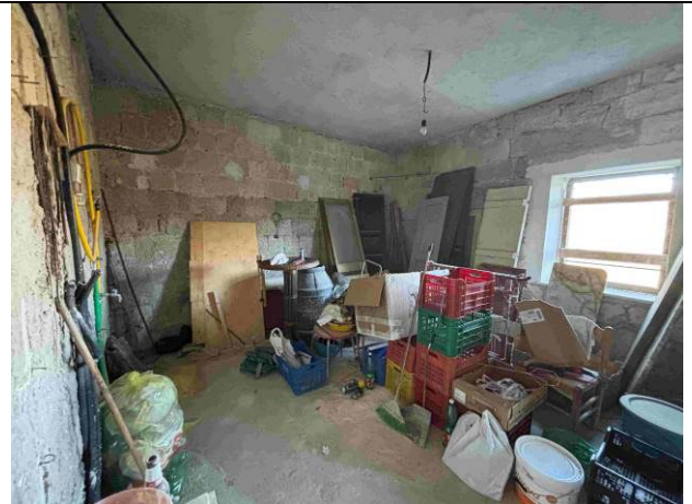
Piano terra – deposito 2
